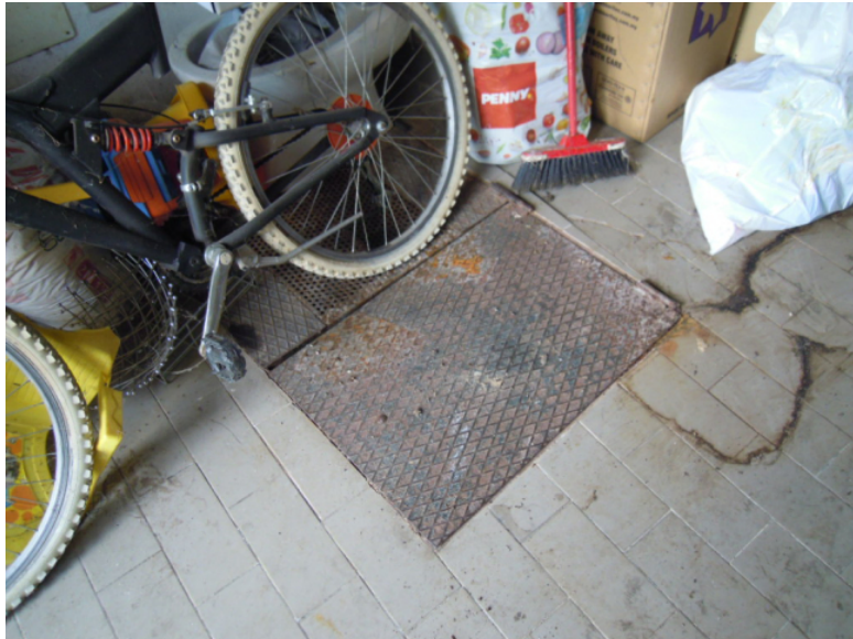
botola accesso cantina
