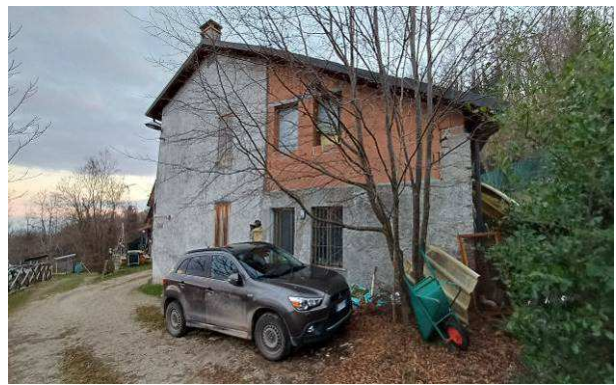
Vista esterna da nord-ovest
