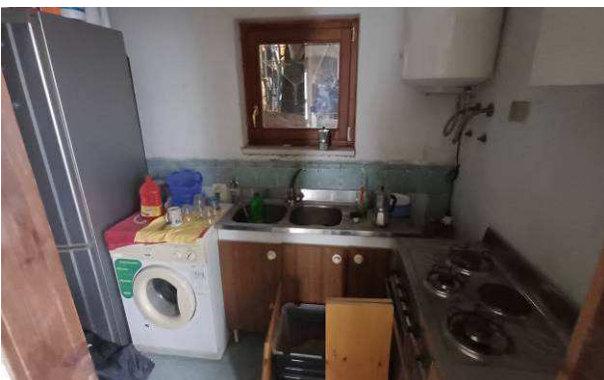
Zona lavello/cottura all'interno del locale bagno piano terra
