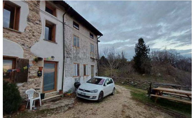
Vista esterna da sud-est
