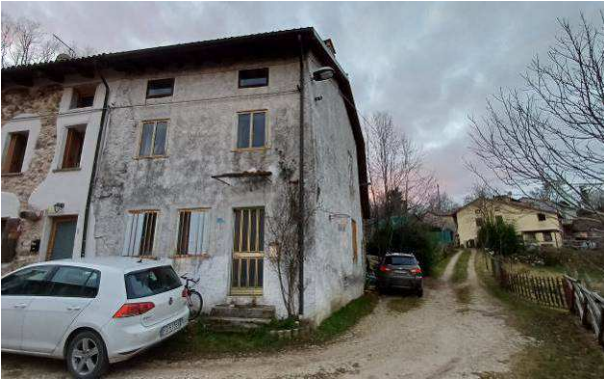
Vista esterna da nord-est
