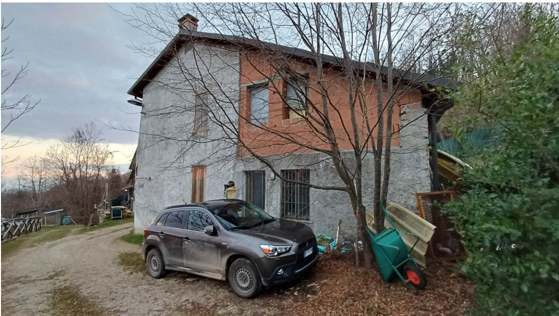
VISTA ESTERNA DA NORD-OVEST
