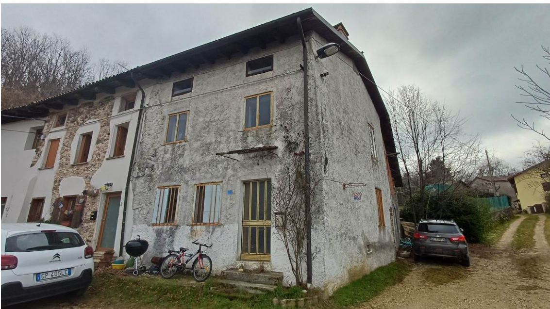
VISTA ESTERNA DA NORD-EST
