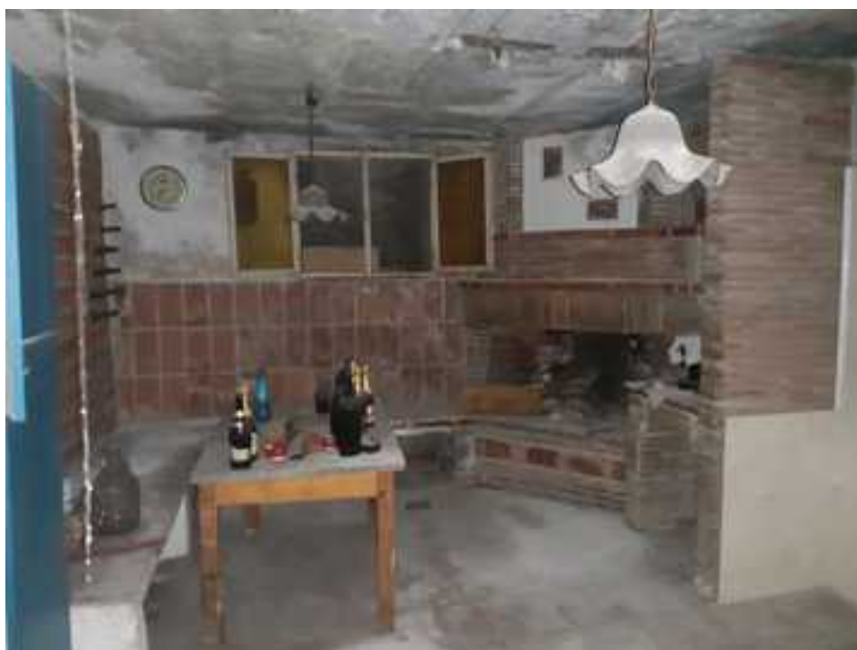
FOTO 15 CANTINA PIANO INTERRATO
