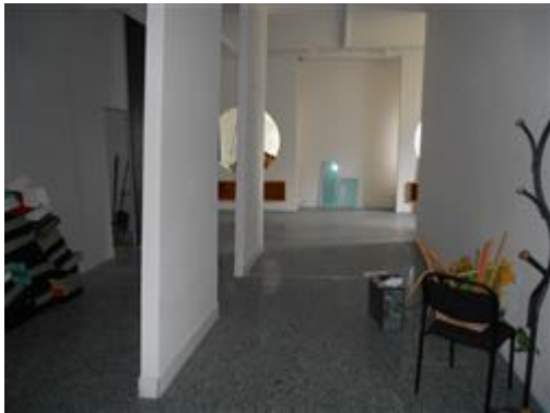
Interno del negozio con vista dei divisori in cartongesso esistenti
