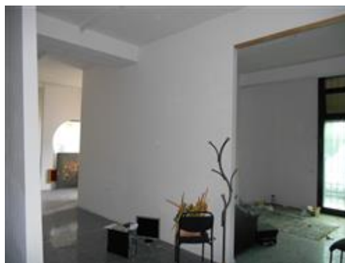
Interno del negozio - vista delle tramezzature in cartongesso esistenti (da rimuovere per la conformità urbanistica)
