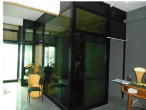
Infisso in alluminio-vetro esistente all'ingresso del negozio con vetrinette in legno lato ingresso
