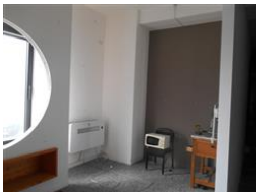
Interno negozio - zona adiacente infisso - finestra sul prospetto
