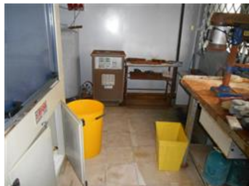
Locale laboratorio ricavato con tramezzatura da rimuovere
