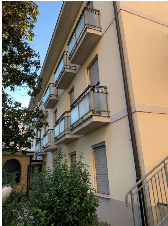
Dettaglio balconi esterni su via Lanza
