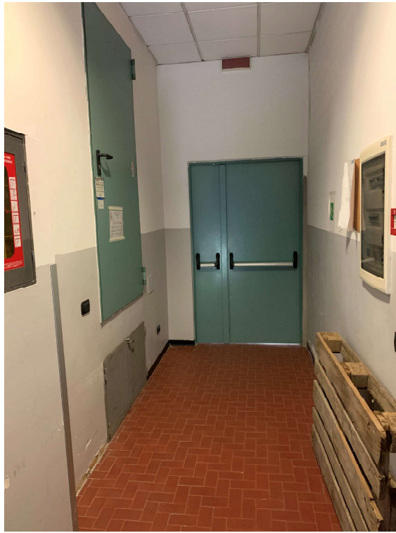
Vista disimpegno terzo piano (ingresso sala macchine ascensore)
