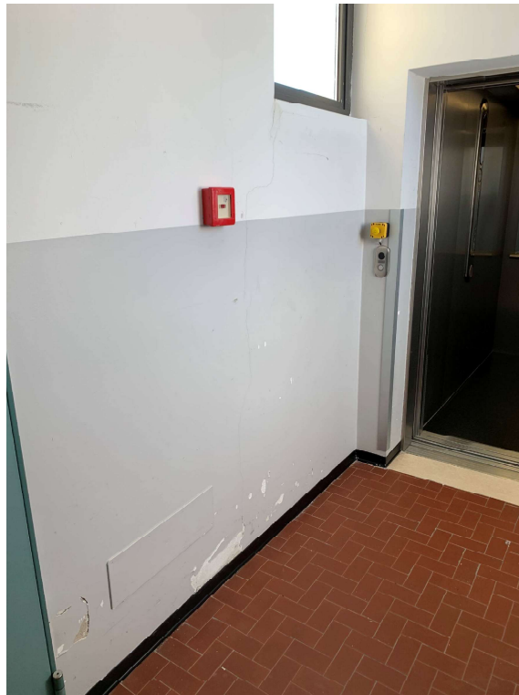
Sbarco montalettighe terzo piano
