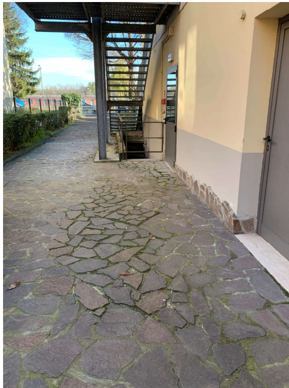
Accesso alla centrale termica
