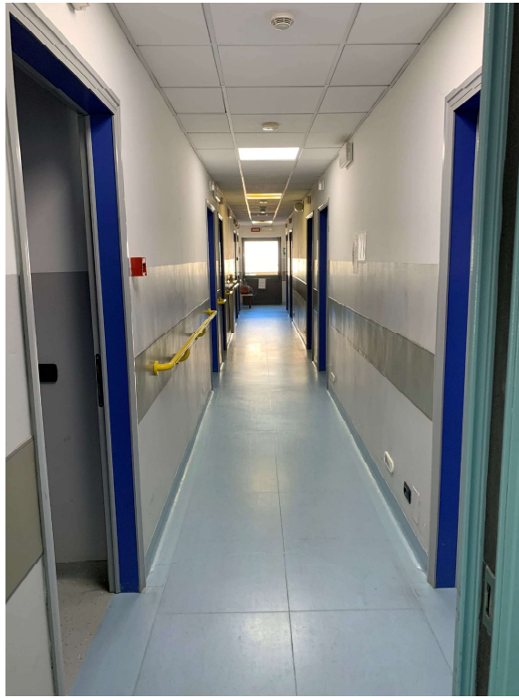
Vista disimpegno secondo piano (zona bassa)
