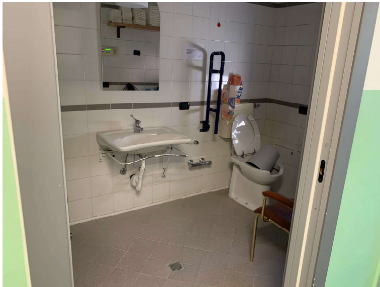
Bagno di piano primo piano
