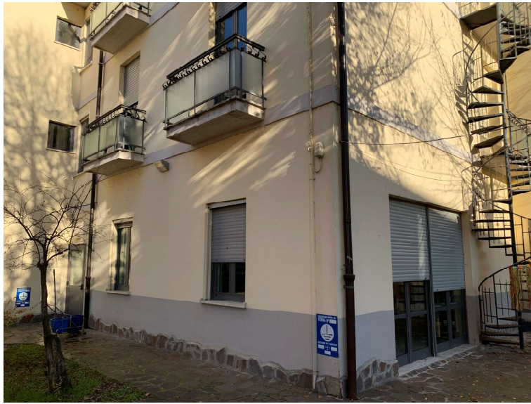
Dettaglio balconi su giardino interno
