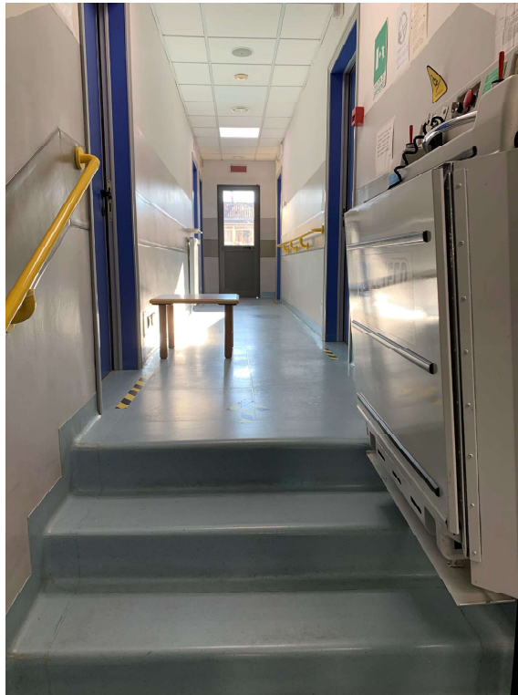
Vista disimpegno secondo piano (zona alta)
