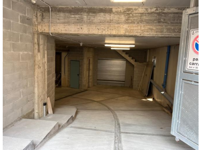
FIGURA 7: VISTA RAMPA COMUNE DI ACCESSO
