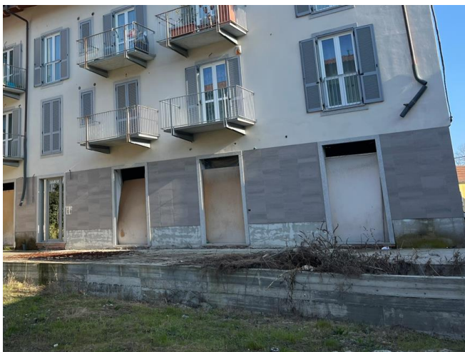
FIGURA 13: VISTA ESTERNA DA AREA C.T. MAPP. 646
