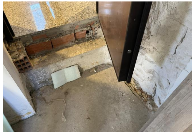
FIGURA 23: DETTAGLIO INGRESSO U.I.
