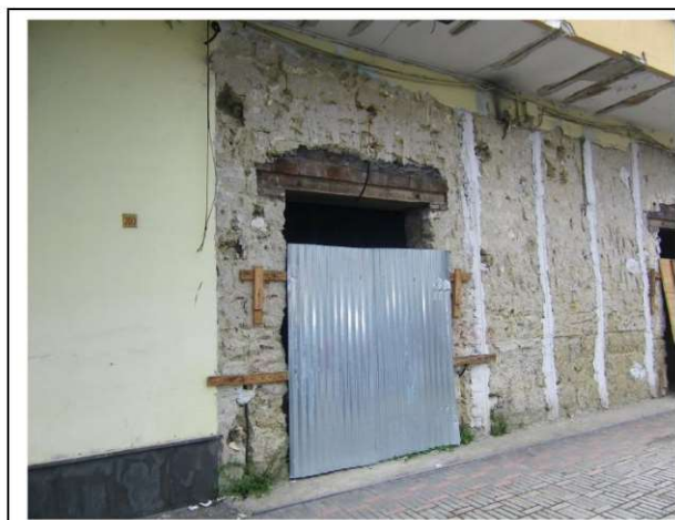
Sub 2 - foto 1 - prospetto dell'unità immobiliare su corso Umberto I
