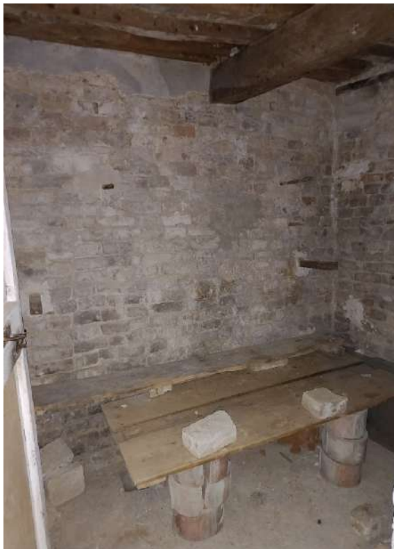
Interno ripostiglio p.S1
