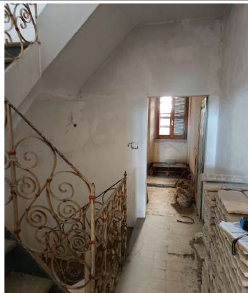
Interno disimpegno scala
