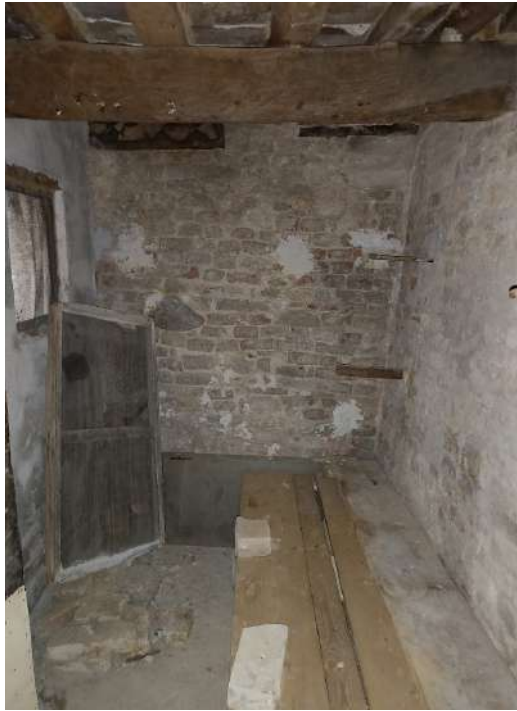
Interno ripostiglio p.S1
