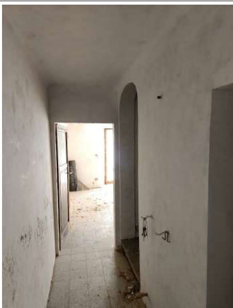
Interno disimpegno p.terra
