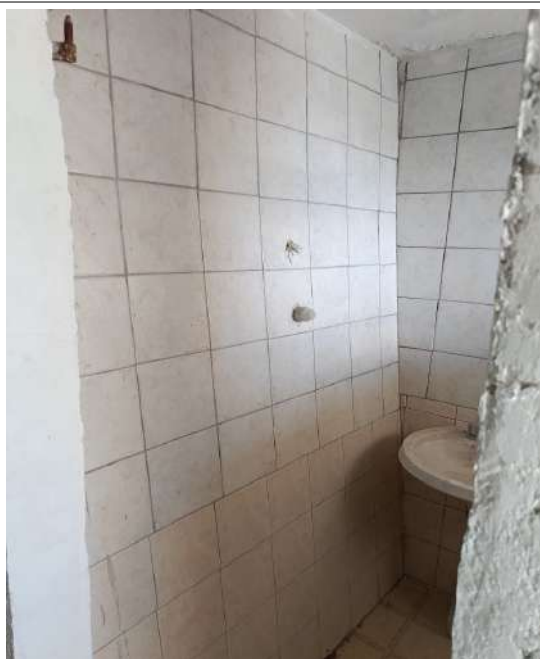
Loc wc piano S1 con luce su loggia S1
