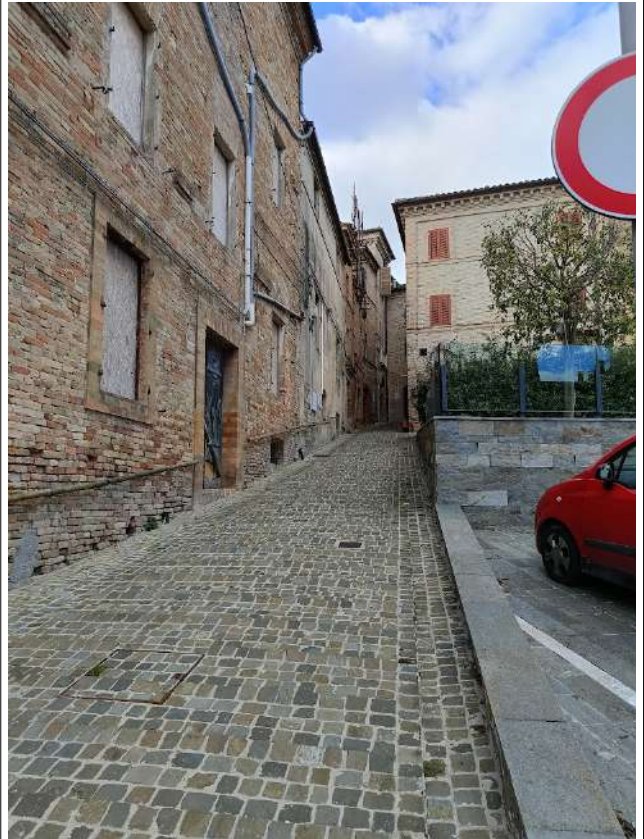
Strada di raccordo piazza-immobile esecutato
