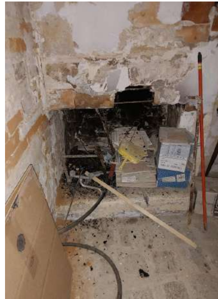
Interno loc cucina p.terra - camino
