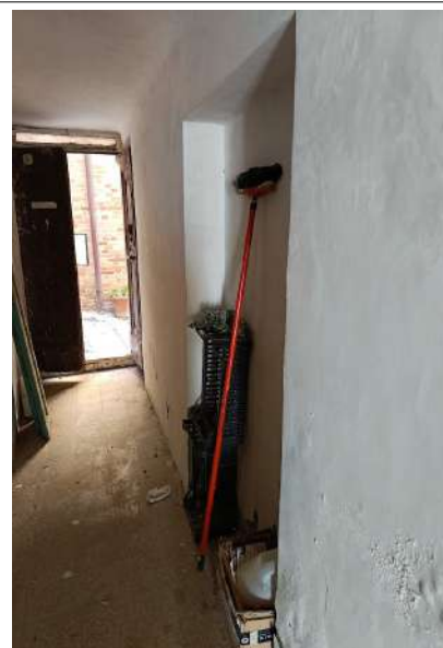
Interno disimpegno p.terra
