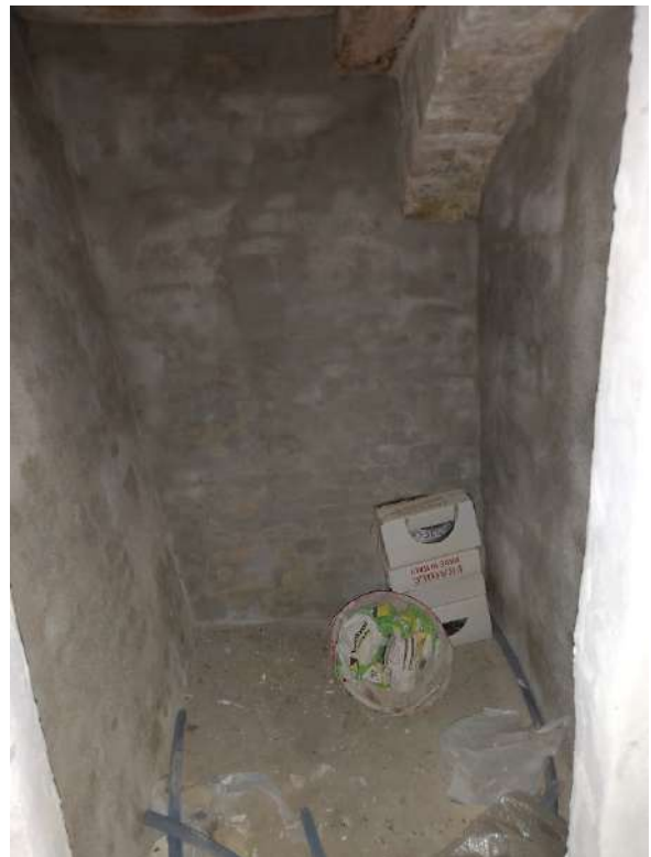
Interno ripostiglio p.S1
