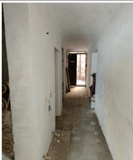
Interno disimpegno p.terra
