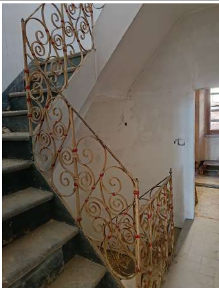
Interno disimpegno scala
