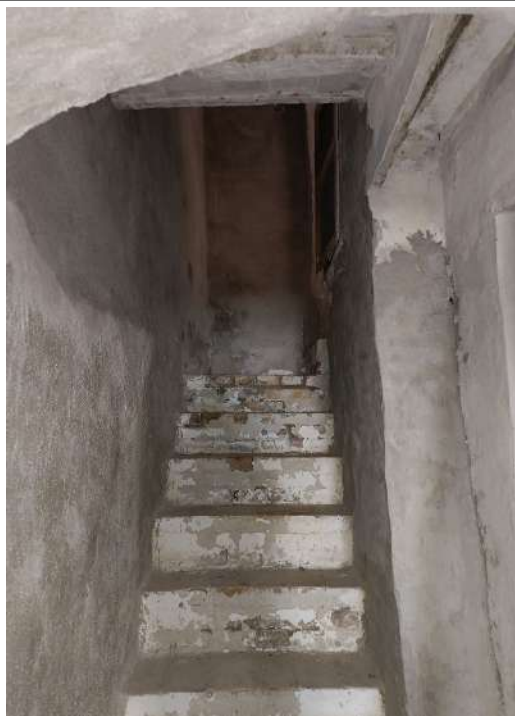
Interno Scala p.s1
