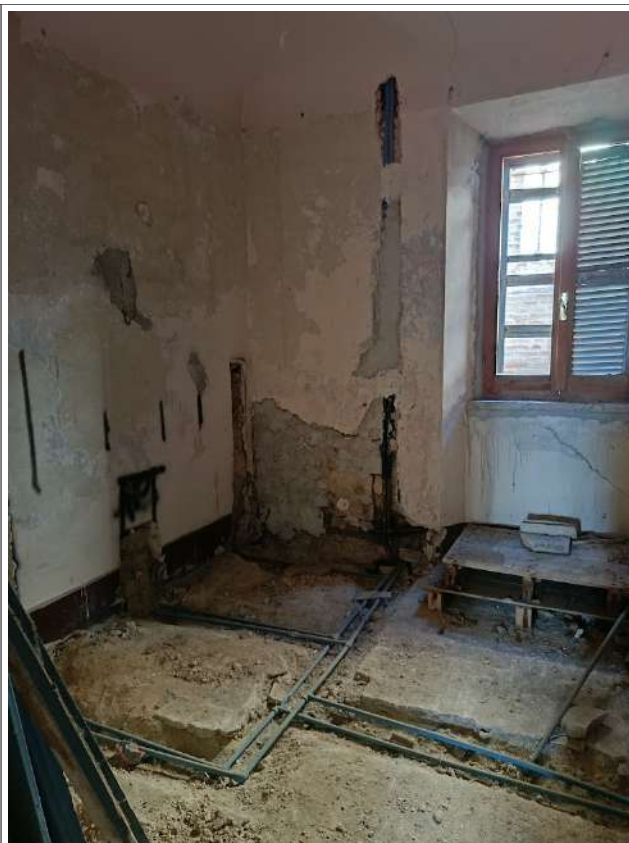
Interno bagno p1
