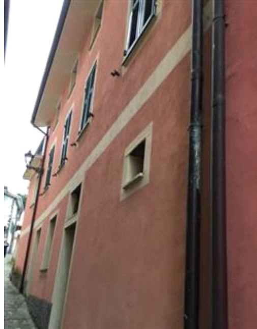
Prospetto lungo via A.Moro. Sono visibili gli accessi delle cantine facenti parte del subalterno 2
