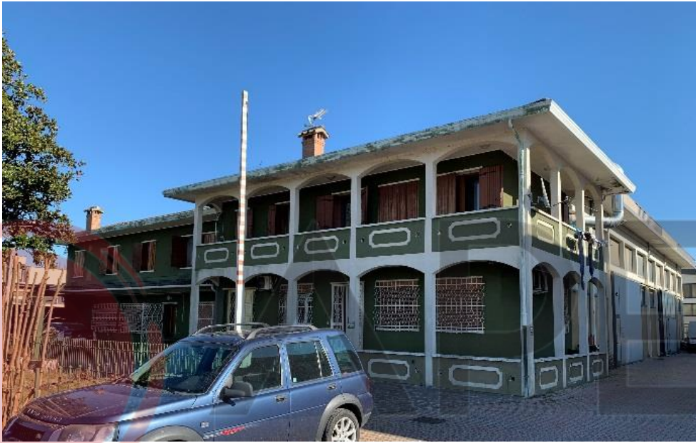
Capannoni ed abitazioni custode a S. Giorgio delle Pertiche |PD|- (coordinate Google 45°31'35.8"N 11°55'00.3"E).
