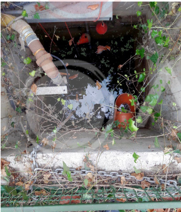
Foto N. 3 – Pozzetto di sollevamento da demolire (acque ex galvanica)
