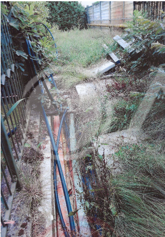
Foto n. 1 – Canalizzazioni da demolire
