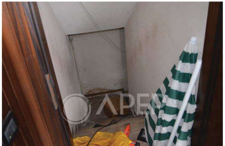
FOTO 33 | Scala di accesso alla cantina
