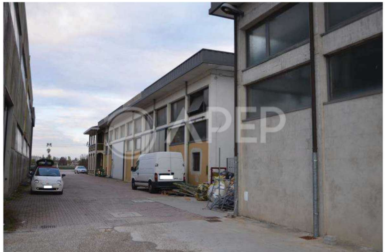
FOTO 2 | Prospetto laterale (sud)
