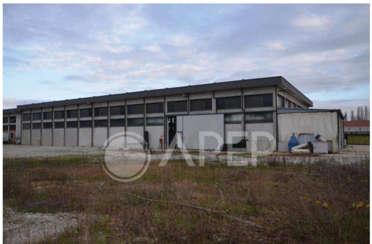
FOTO 18 | Prospetto laterale (sud)
