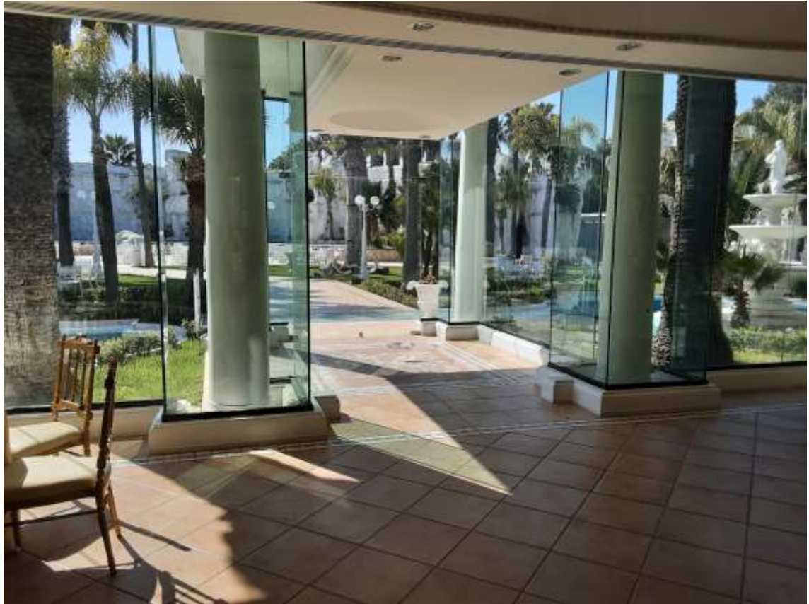
Foto 5 – sopralluogo del 30 marzo '21
