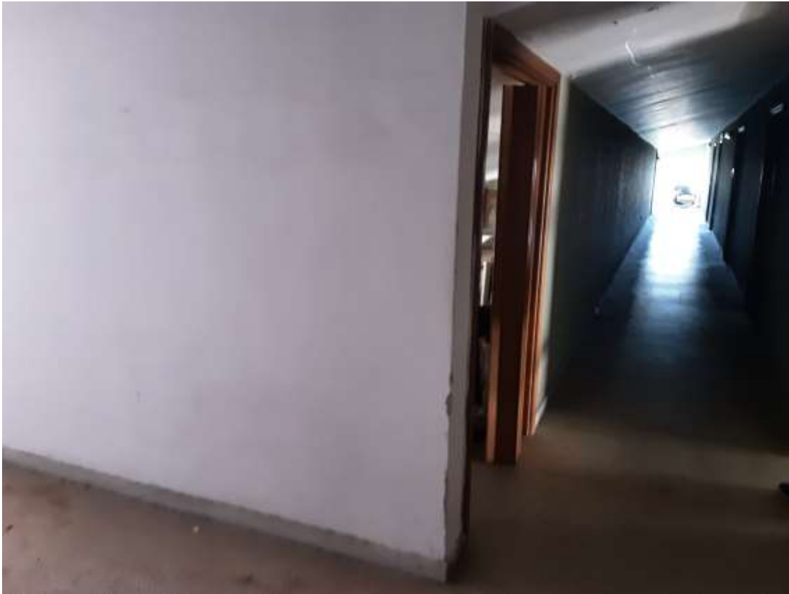
Foto 23 – sopralluogo del 30 marzo '21
