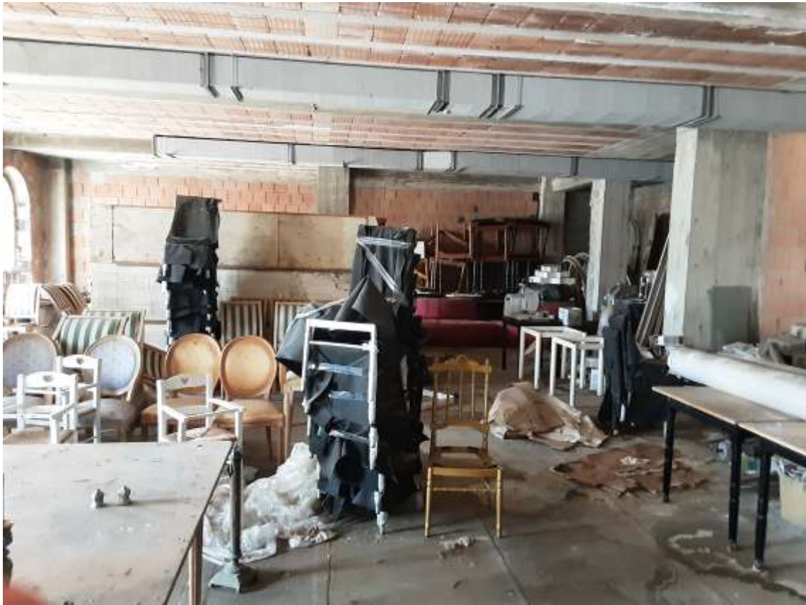
Foto 21 – sopralluogo del 30 marzo '21
