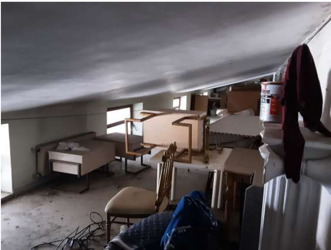
Foto 24 – sopralluogo del 30 marzo '21
