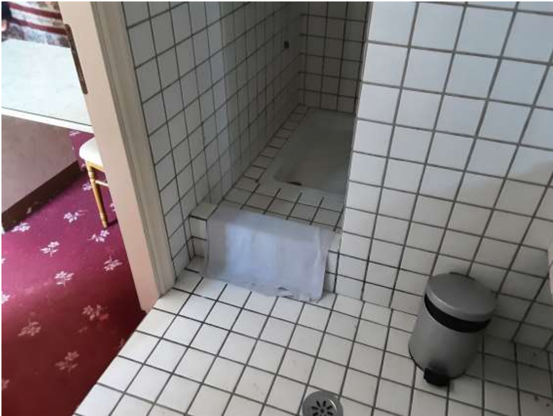
Foto 15 – sopralluogo del 30 marzo '21
