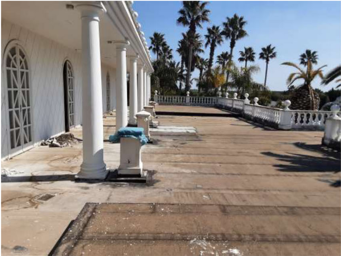
Foto 17 – sopralluogo del 30 marzo '21
