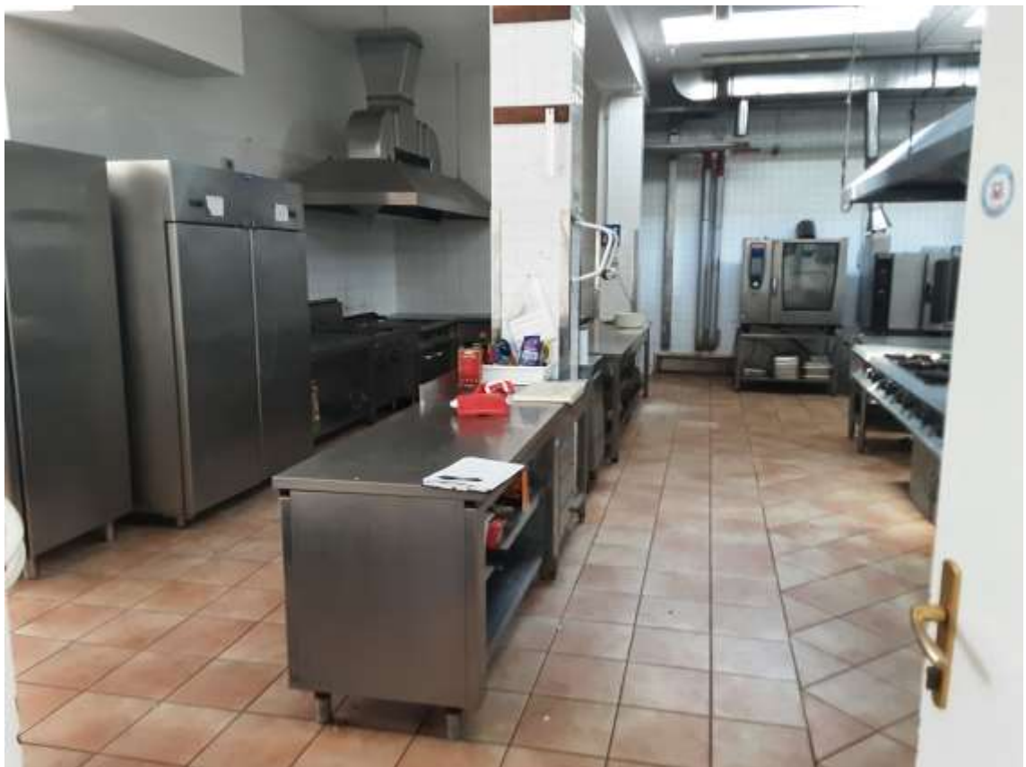
Foto 6 – sopralluogo del 30 marzo '21
