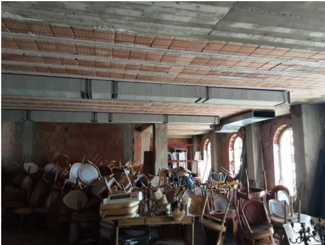
Foto 22 – sopralluogo del 30 marzo '21
