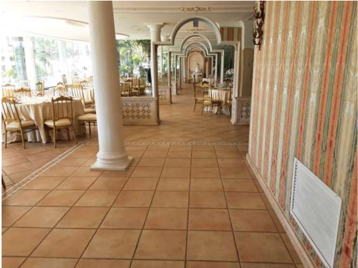
Foto 3 – sopralluogo del 30 marzo '21
