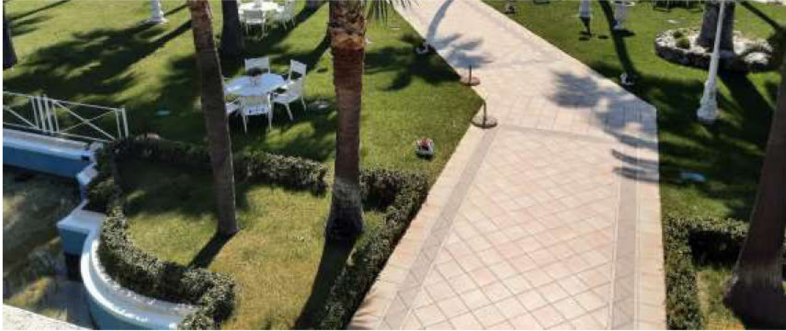
Foto 19 – sopralluogo del 30 marzo '21
