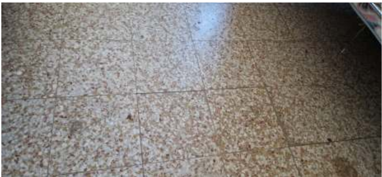
Viste dei tipi di pavimentazione
