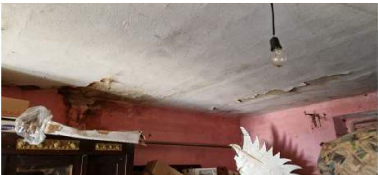
Viste del piano primo
