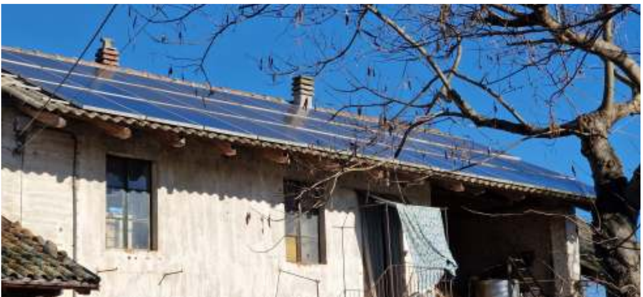
Vista dell'impianto fotovoltaico
