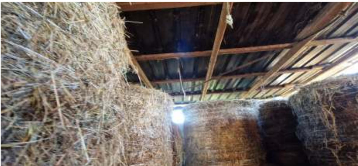
Viste della tettoia laterale
