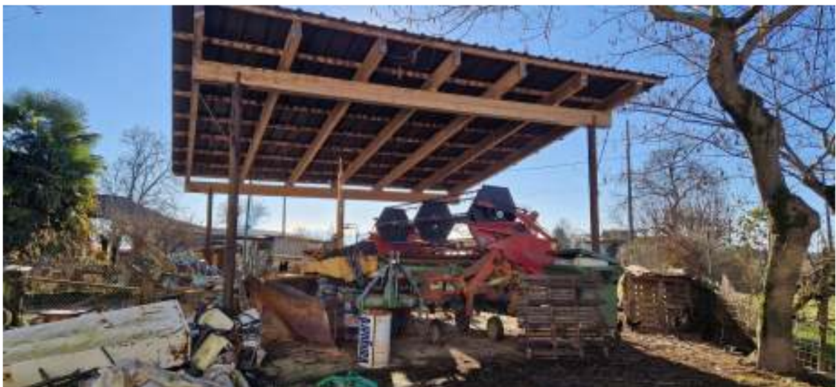
Viste esterne del fabbricato e della tettoia
