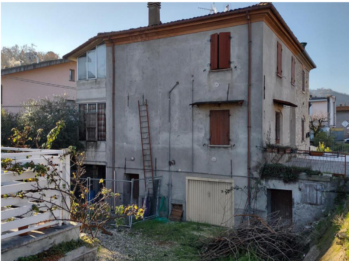
FOTO 2. Vista della porzione della casa con l'abitazione, il garage e la corte esclusiva
