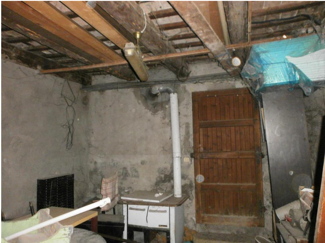
FOTO 23. Piano sottostrada: cantina
