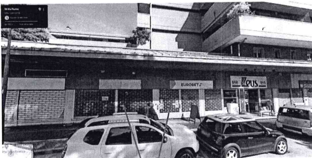
Estratto Ortofoto Ubicazione vetrine su via Fiume
