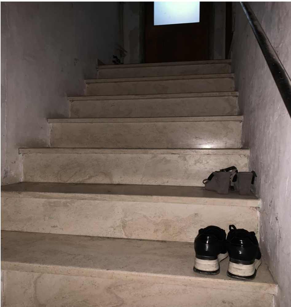
FOTO 14 - Vista interna Scala di accesso al piano primo
