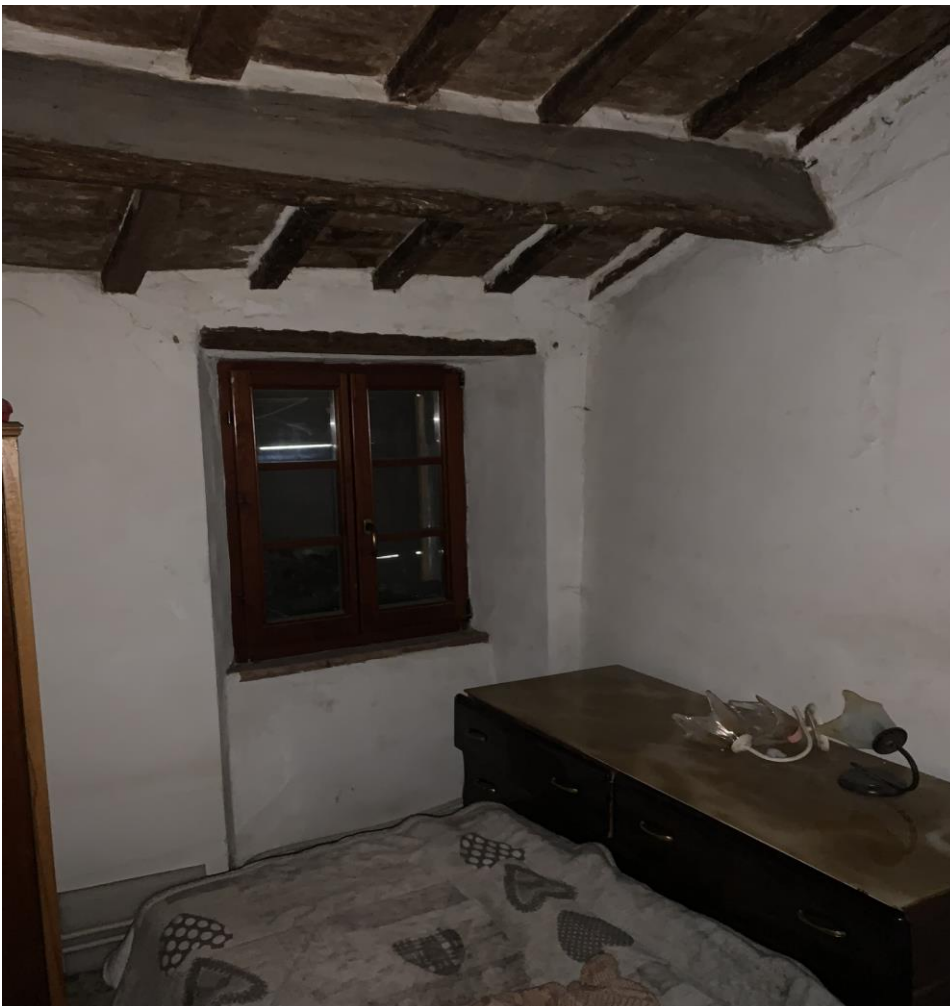
FOTO 18 - Vista interna piano primo
