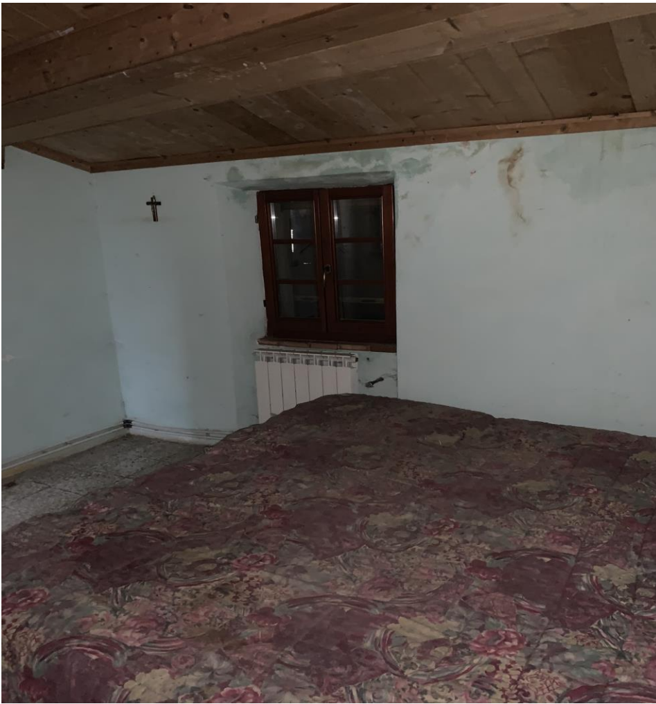
FOTO 19 - Vista interna piano primo
