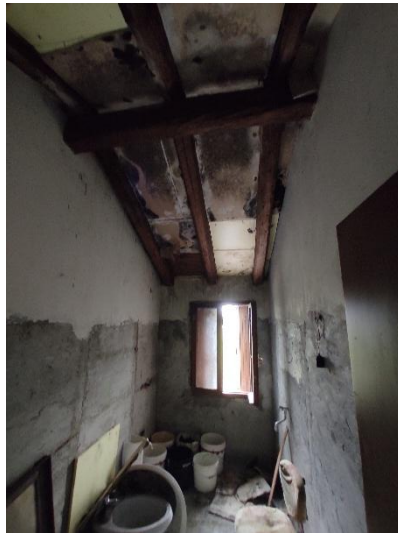
Particolare vani al grezzo e copertura
