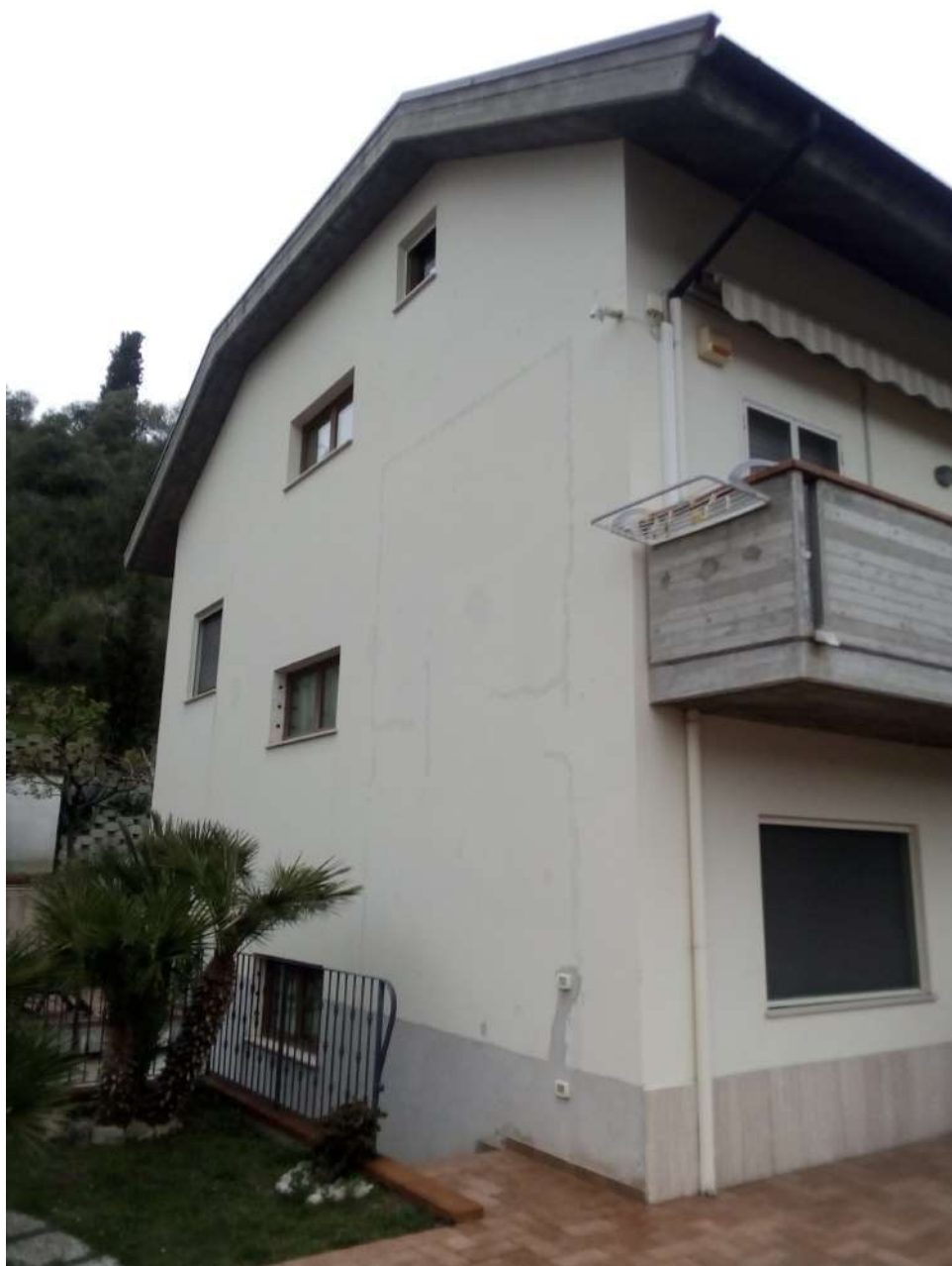
FOTO N.1: VISTA DEL PROSPETTO SUD
