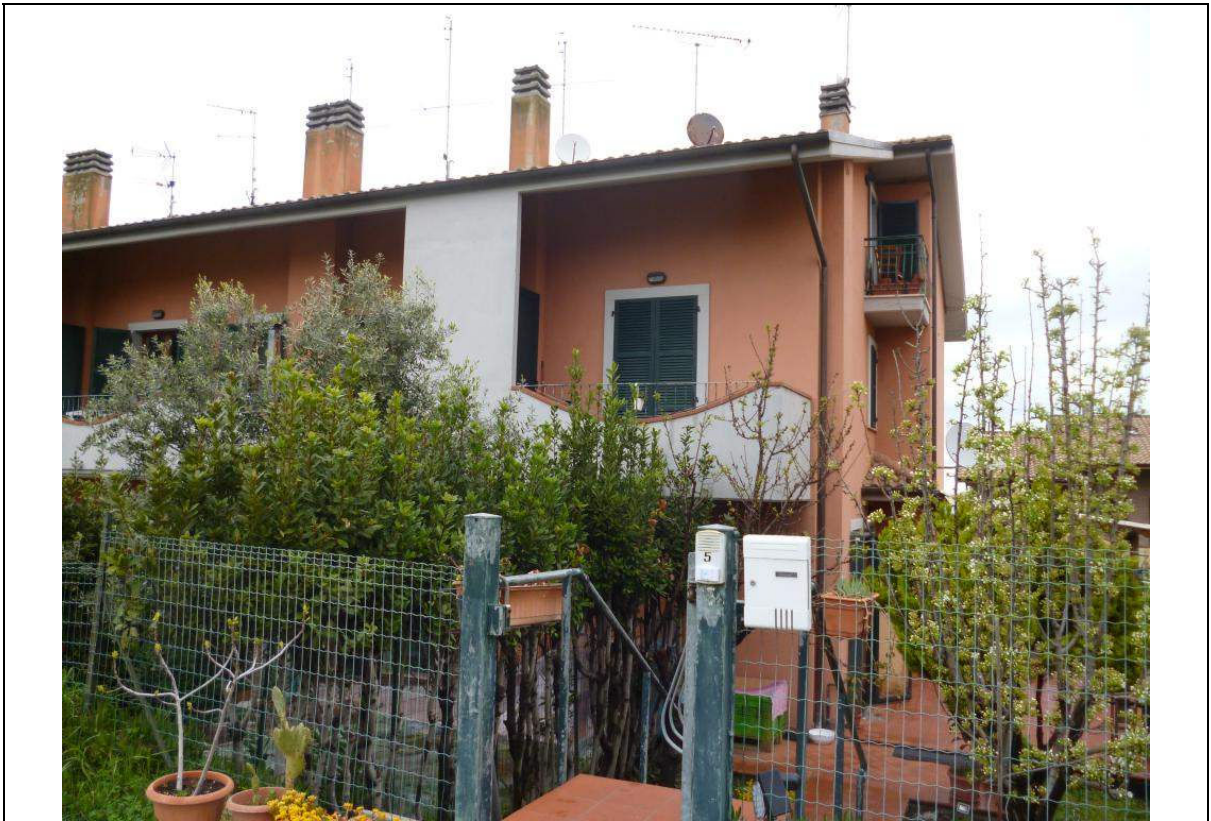
FOTO n° 1: VISTA ESTERNA SU VIA SARDEGNA
