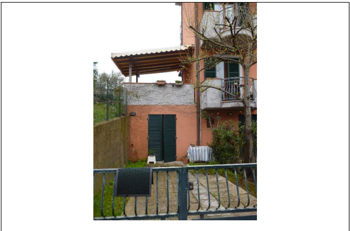
FOTO n° 2: VISTA ESTERNA SU VIA DEGLI ULIVI.
