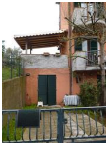
Foto entrata accesso carrabile su via degli Ulivi SNC
