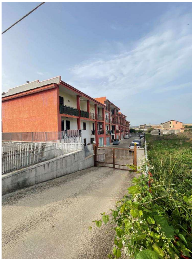
Foto n.3: Accesso carrabile complesso residenziale Via Alburnia n. 1 in loc. Borgo Carillia del Comune di Altavilla Silentina.
