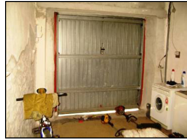
Deposito al piano terra.
