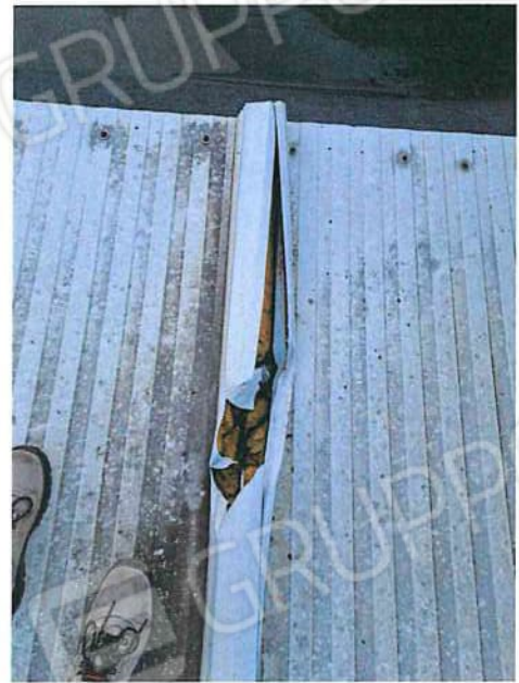
Foto 142 - Copertura pannello sandwich lesionato.jpg
