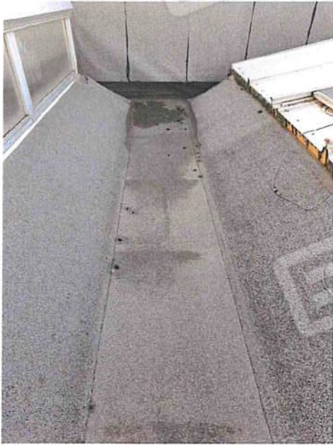
Foto 133 - Copertura gronda O.jpg
