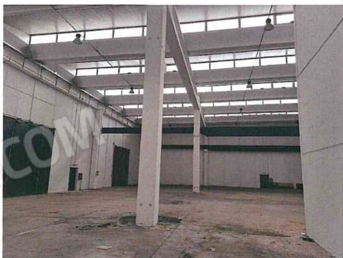
Foto 039 - Capannone lato O.jpg
