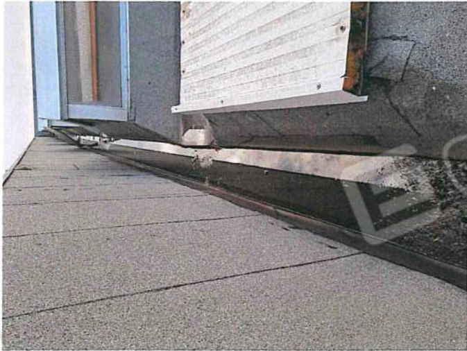
Foto 097 - Copertura gronda E.jpg
