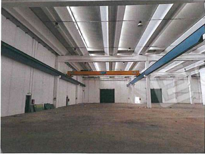
Foto 043 - Capannone lato N.jpg
