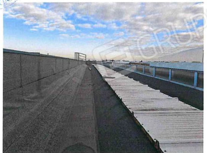
Foto 102 - Copertura lato N dx.jpg
