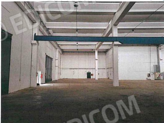
Foto 053 - Capannone lato E.jpg
