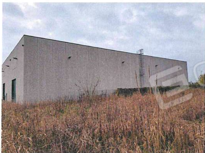
Foto 007 - Capannone industriale con uffici - prospetto N.jpg
