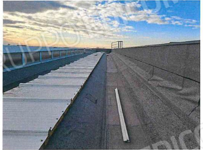
Foto 098 - Copertura lato N sx.jpg
