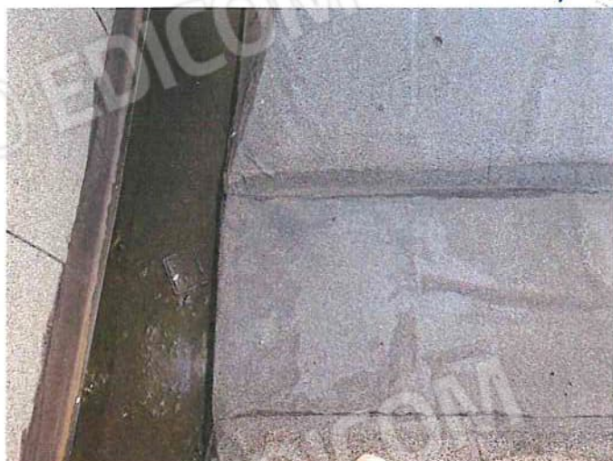
Foto 107 - Copertura lato N sx.jpg
