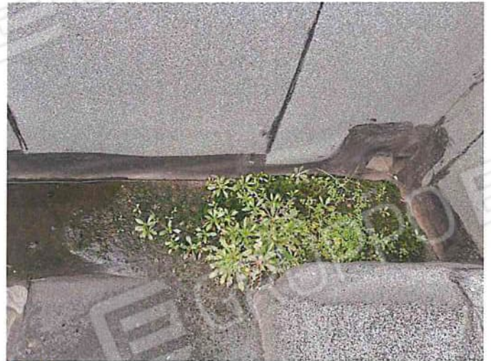
Foto 100 - Copertura gronda angolo N-O.jpg
