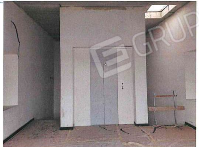
Foto 078 - Vano scala uffici p. II.jpg
