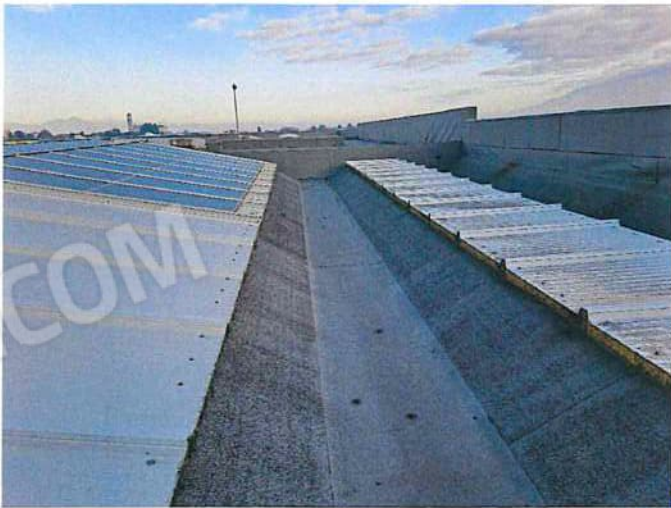
Foto 141 - Copertura angolo S-O.jpg
