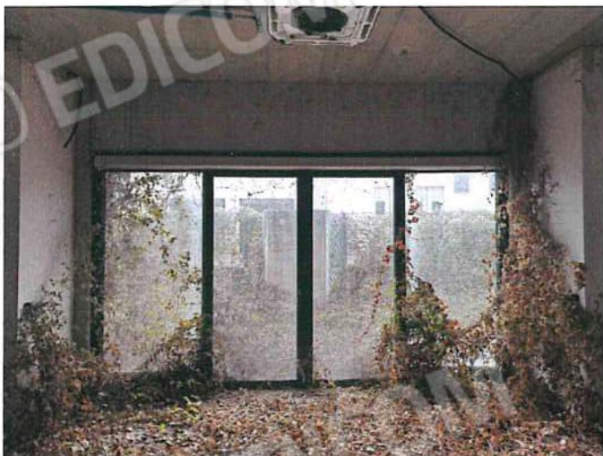
Foto 017 - Ingresso uffici p.T..jpg
