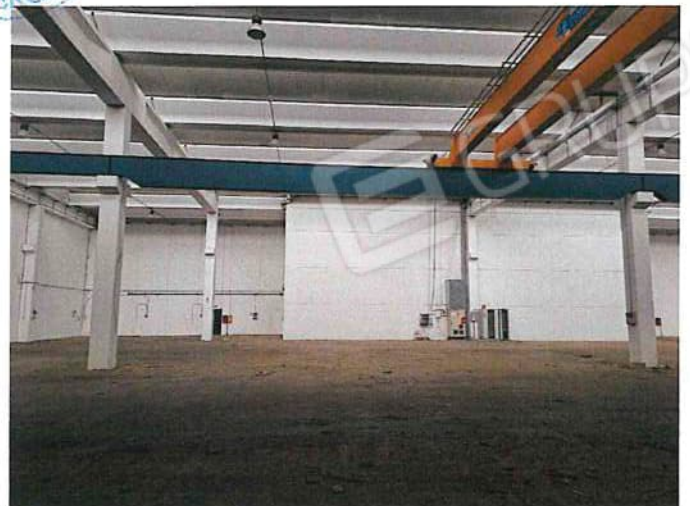
Foto 054 - Capannone porzione centrale.jpg
