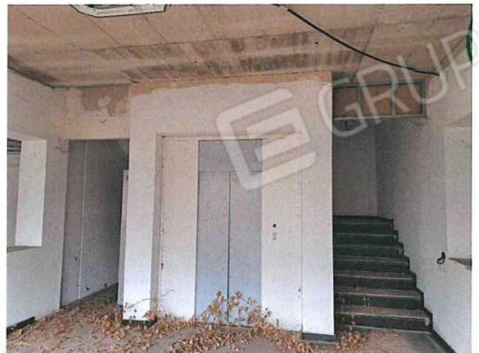
Foto 018 - Ingresso uffici p.T..jpg
