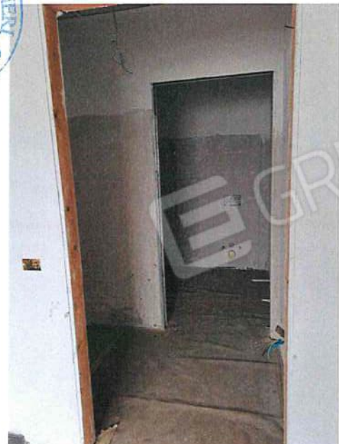
Foto 090 - Antibagno e bagno E sx p.II .jpg
