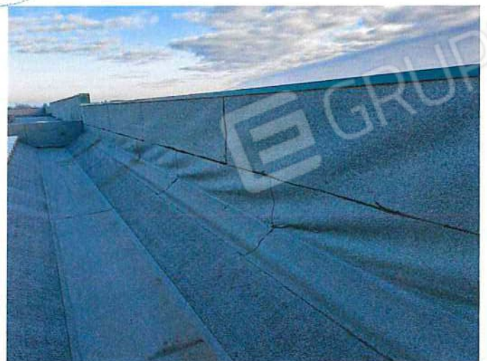
Foto 144 - Copertura parapetto prospetto S.jpg
