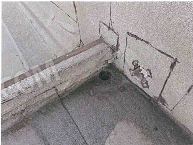
Foto 153 - Copertura lato S scarico angolo E porzione sopraelevata su uffici.jpg
