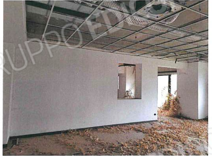
Foto 020 - Ingresso uffici p.T..jpg
