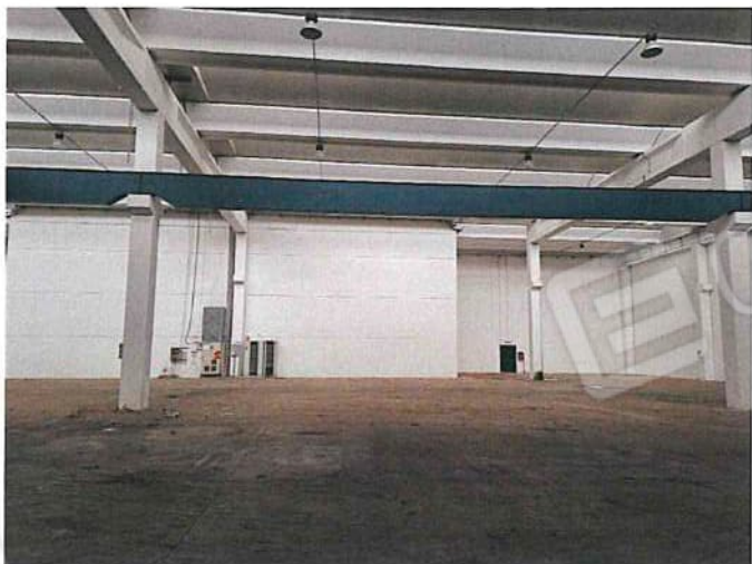
Foto 055 - Capannone porzione centrale.jpg
