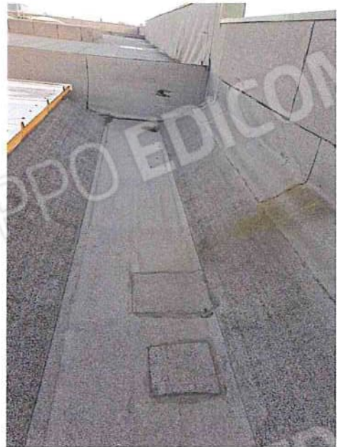
Foto 146 - Copertura lato S-O.jpg
