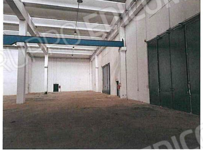
Foto 044 - Capannone lato O.jpg
