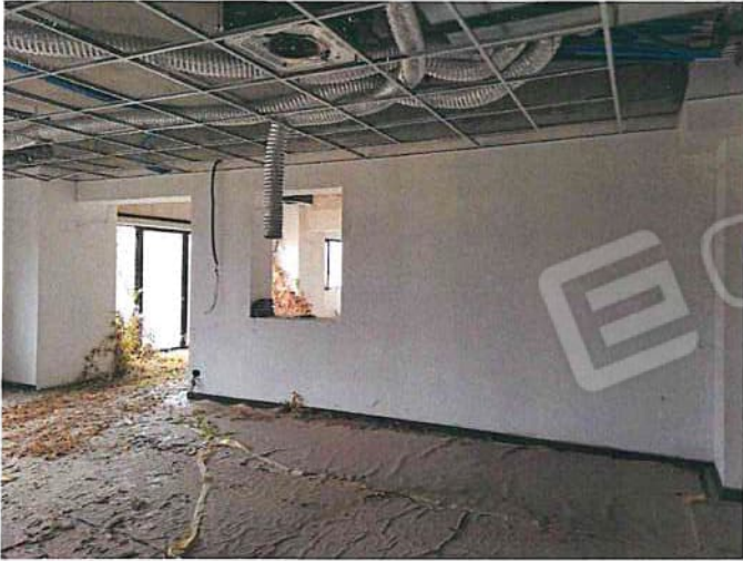
Foto 019 - Ingresso uffici p.T..jpg
