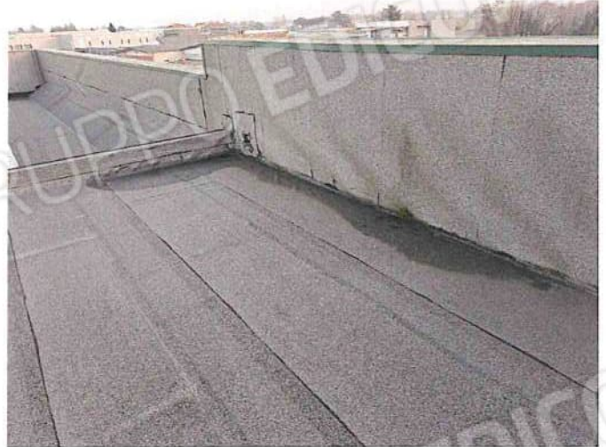
Foto 152 - Copertura porzione E sopraelevata su uffici.jpg
