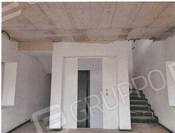
Foto 058 - Vano scala uffici p.l.jpg
