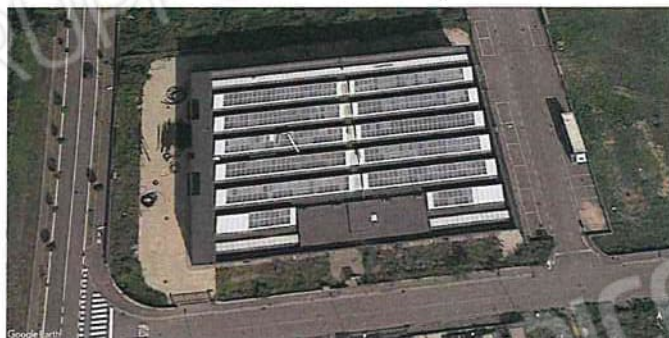
Foto 002 - Vista aerea copertura.jpg
