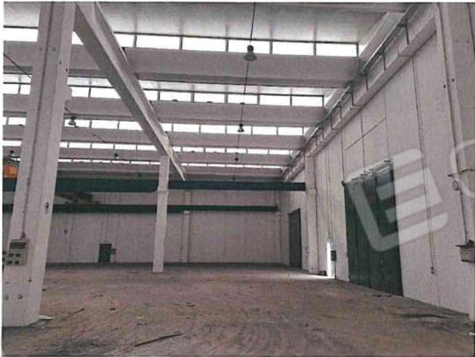
Foto 049 - Capannone lato E.jpg
