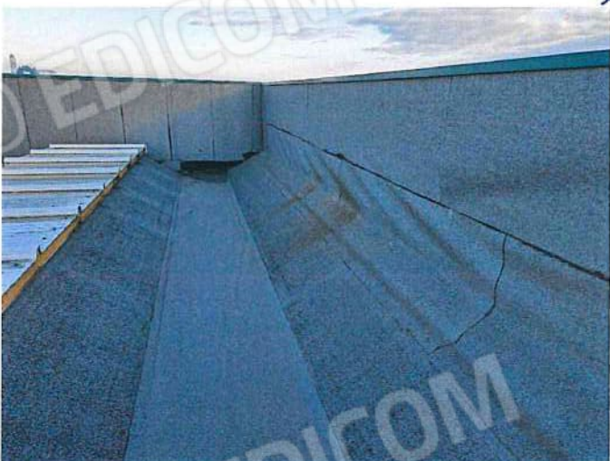
Foto 155 - Copertura parapetto prospetto S.jpg
