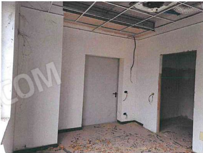
Foto 027 - Spogliatoio O p.T..jpg
