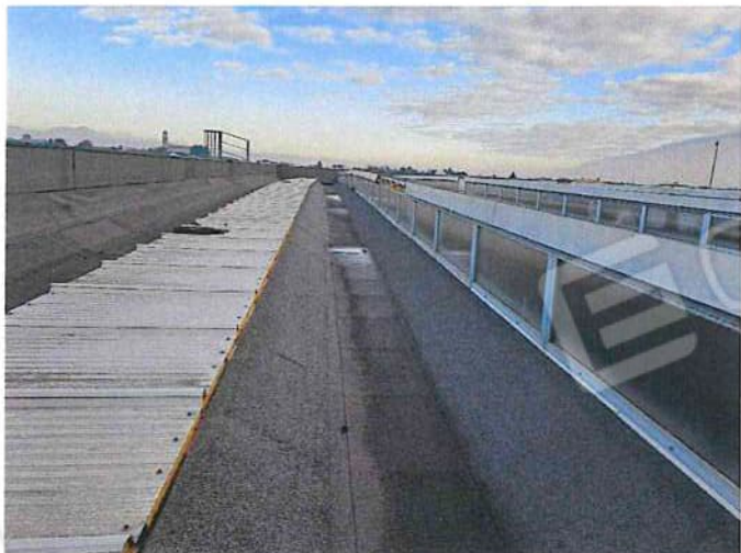
Foto 103 - Copertura lato N sx.jpg
