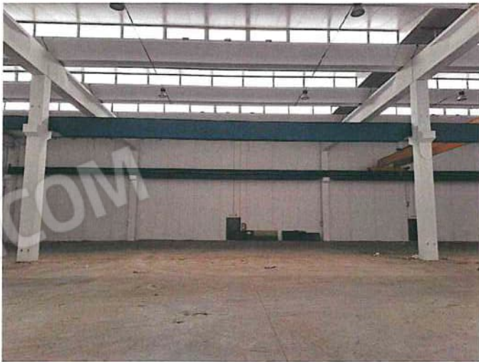
Foto 045 - Capannone porzione centrale.jpg
