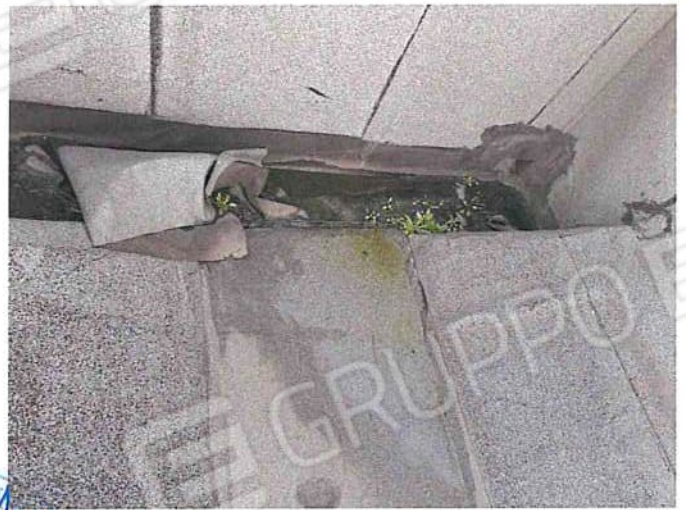
Foto 160 - Copertura gronda angolo S-E.jpg
