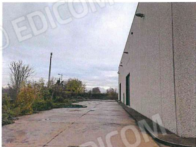
Foto 011 - Capannone industriale con uffici - area ext. esclusiva prospetto O.jpg
