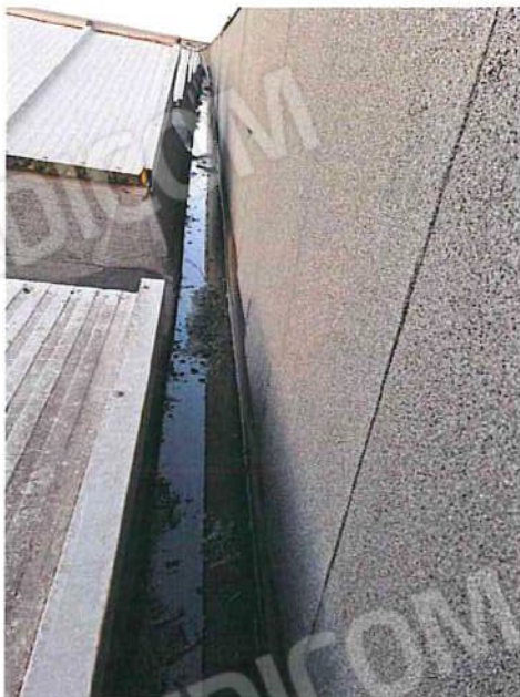
Foto 161 - Copertura gronda E.jpg
