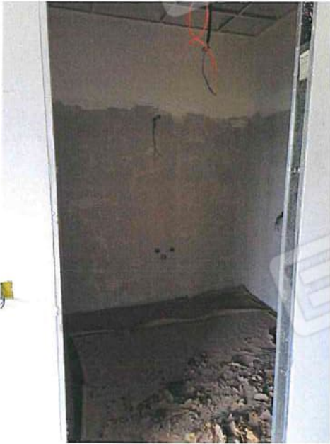
Foto 025 - Antibagno O disabili p.T..jpg
