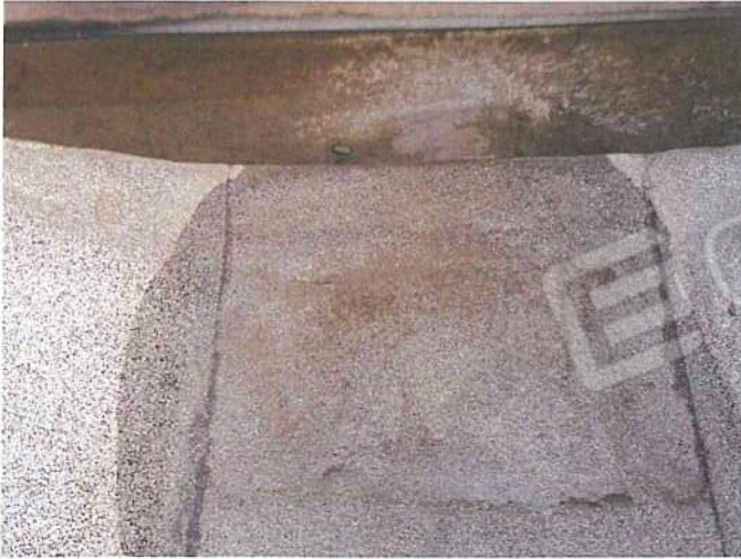
Foto 115 - Copertura gronda E.jpg
