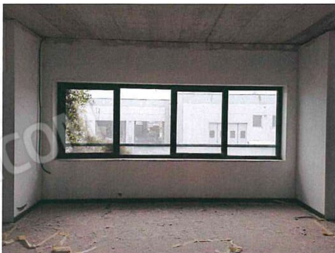
Foto 057 - Vano scala uffici p.l.jpg
