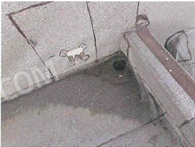
Foto 147 - Copertura lato S scarico angolo O porzione sopraelevata su uffici.jpg
