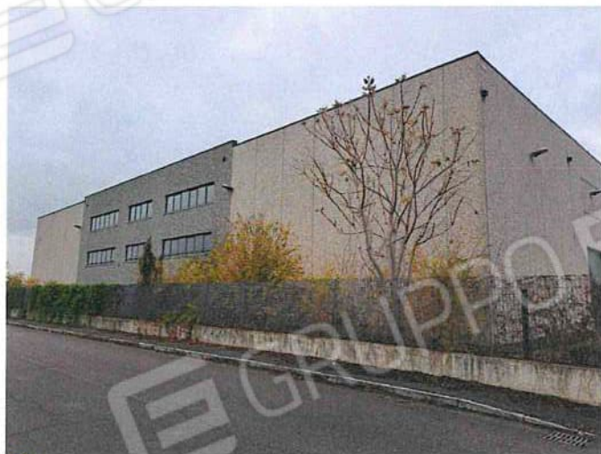
Foto 004 - Capannone industriale con uffici - prospetto S.jpg
