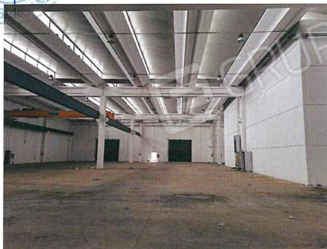
Foto 042 - Capannone porzione centrale .jpg
