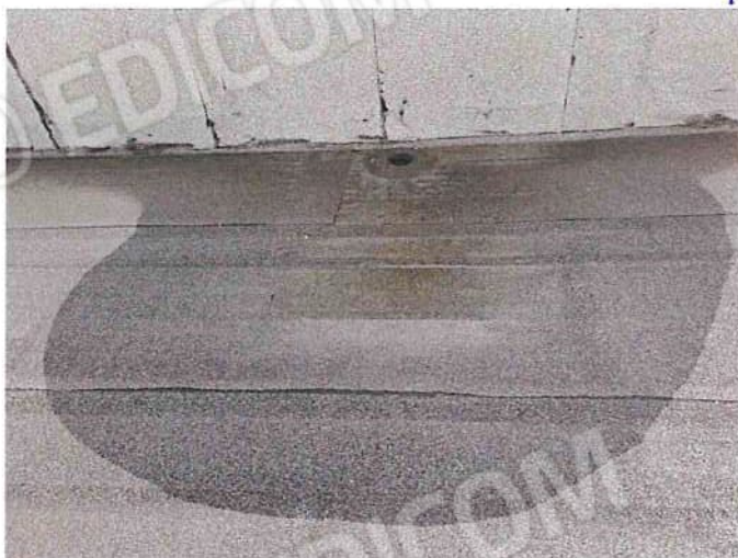
Foto 149 - Copertura scarico porzione O sopraelevata su uffici.jpg
