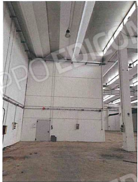
Foto 050 - Capannone angolo S-E .jpg
