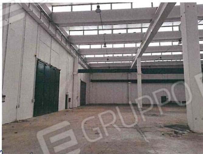
Foto 040 - Capannone lato O.jpg
