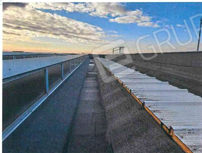
Foto 108 - Copertura lato N sx.jpg
