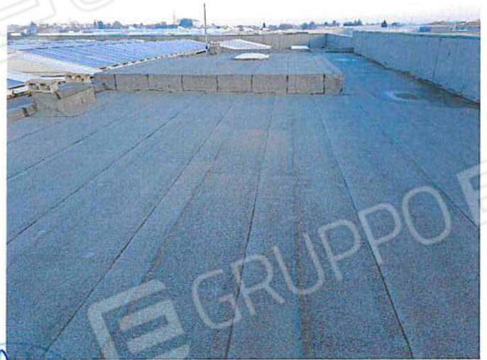
Foto 148 - Copertura porzione O sopraelevata su uffici.jpg
