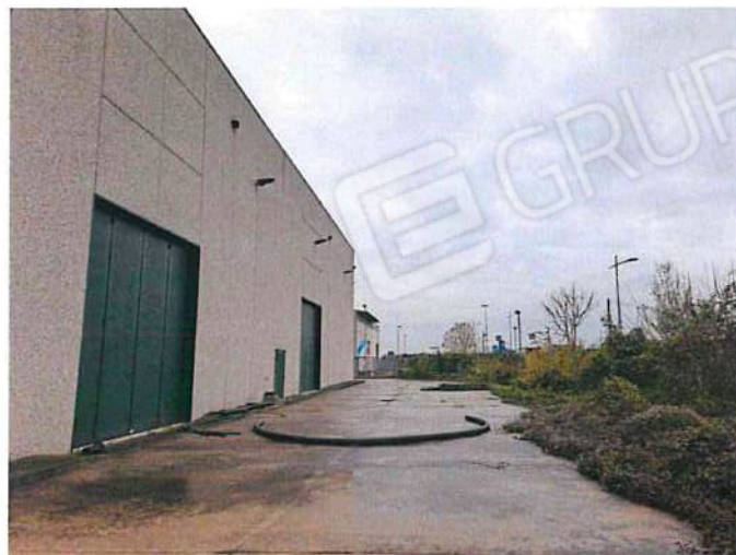
Foto 012 - Capannone industriale con uffici - area ext. esclusiva prospetto O.jpg
