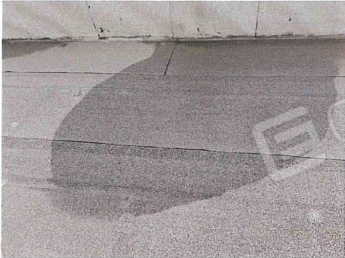
Foto 151 - Copertura porzione E sopraelevata su uffici.jpg
