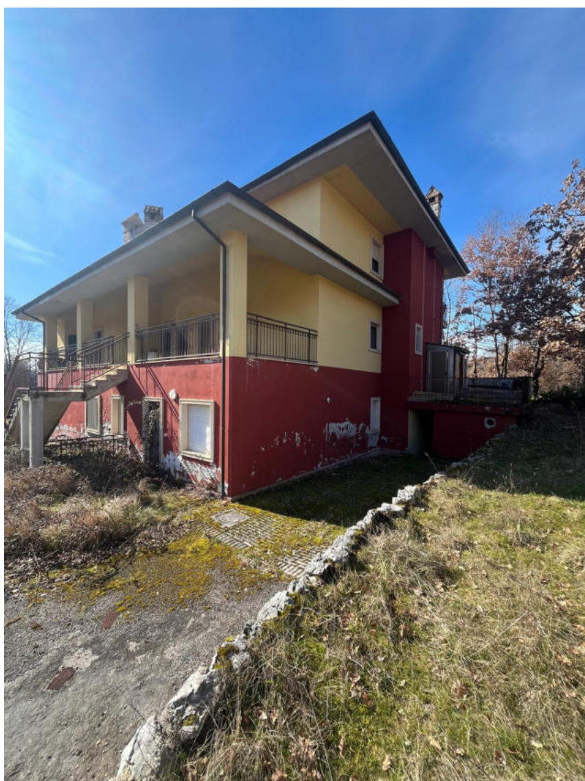
Foto n. 6 – Prospetto del fabbricato
