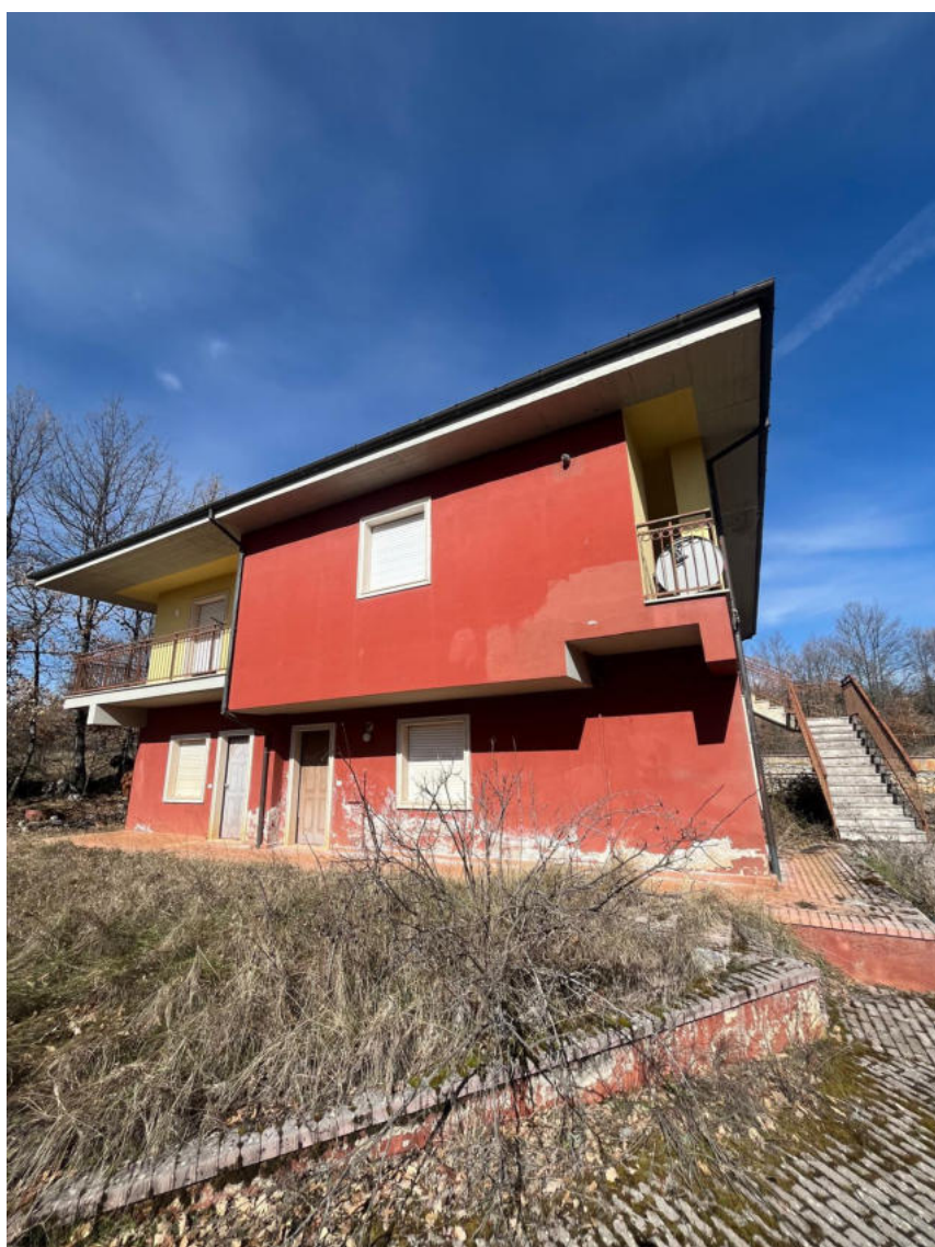
Foto n. 4 – Prospetto del fabbricato
