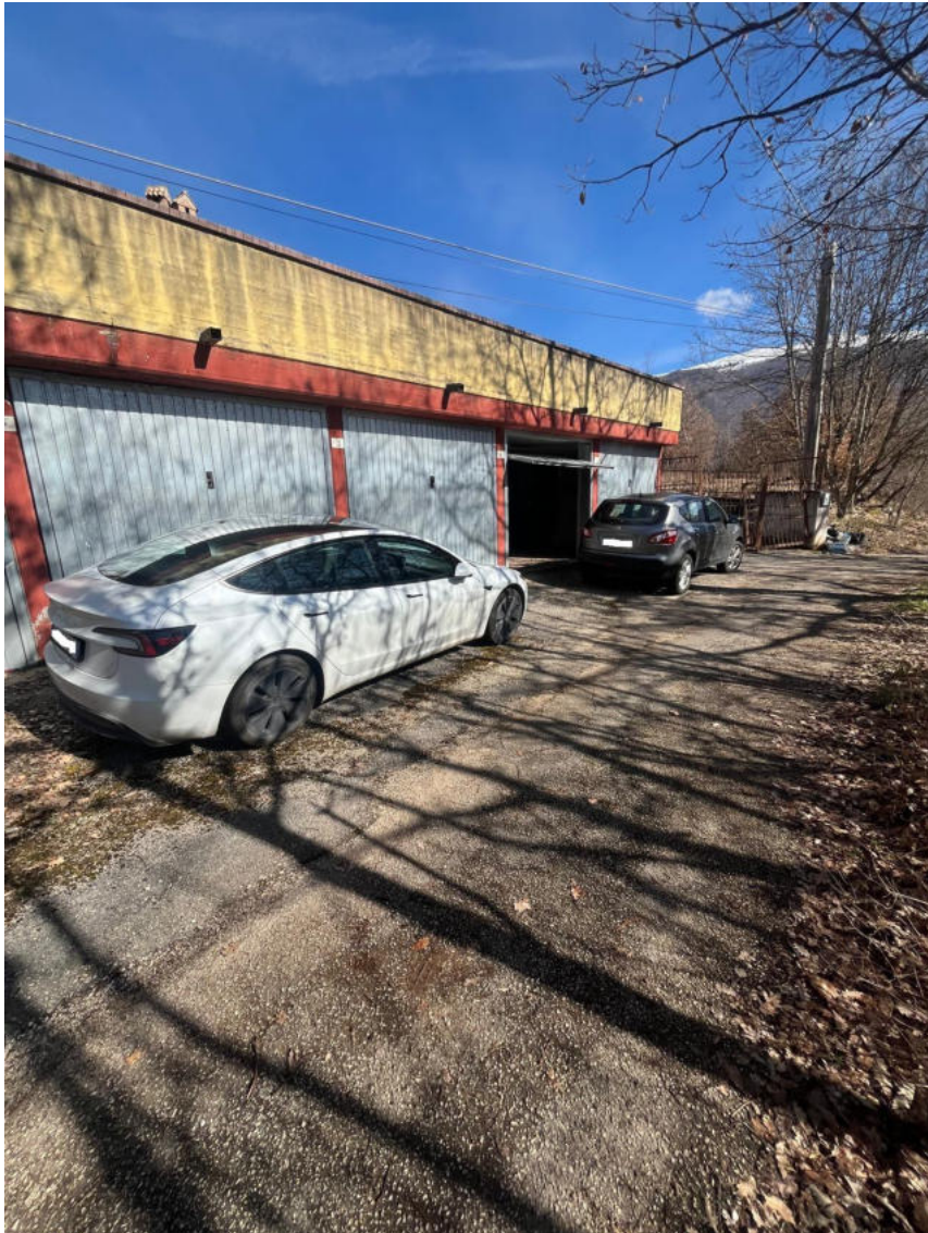
Foto n. 16 – Prospetto garage /cantina
