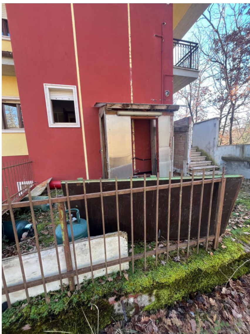
Foto n. 5 – Prospetto del fabbricato
