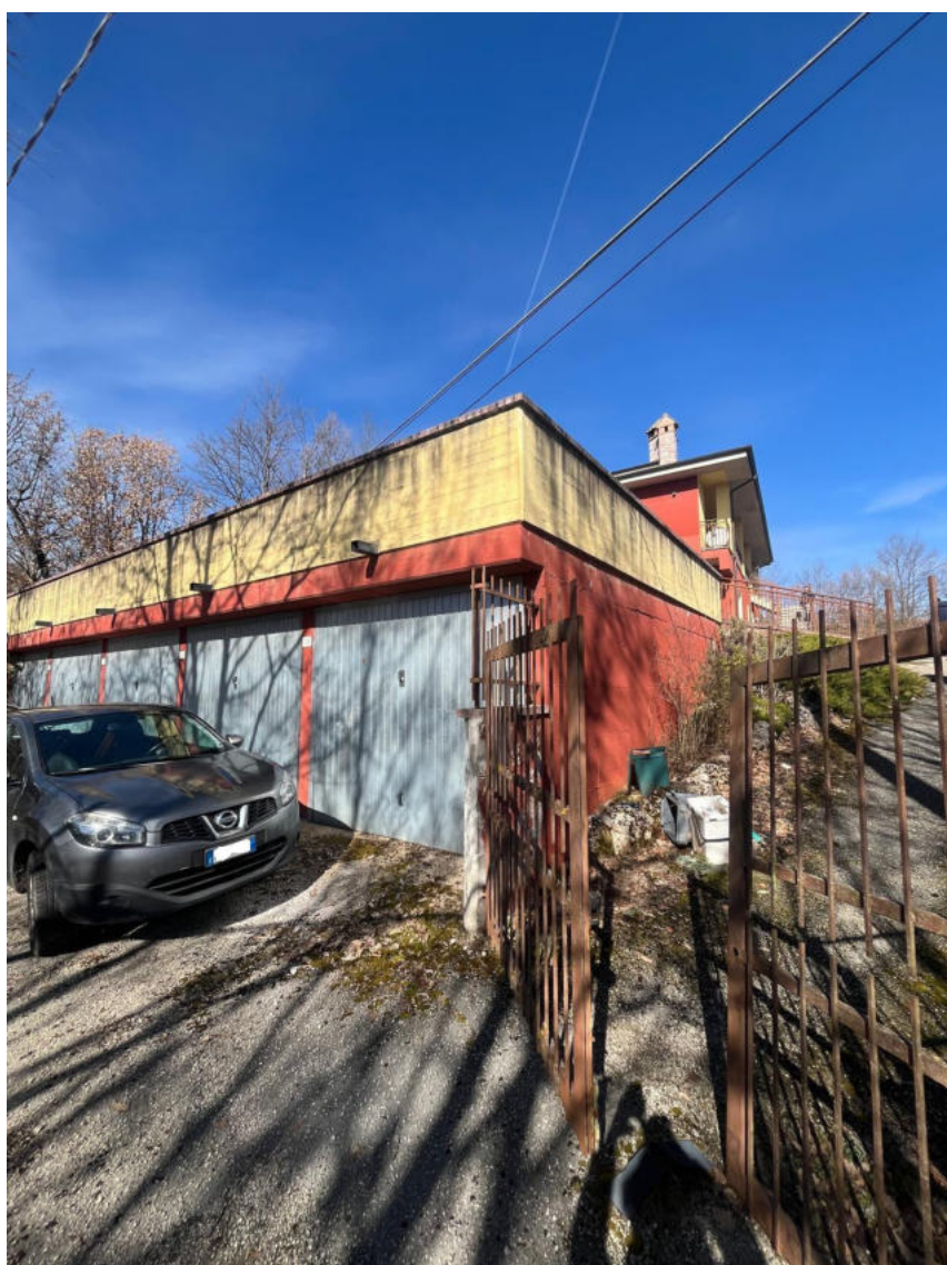
Foto n. 2 – Prospetto del fabbricato
