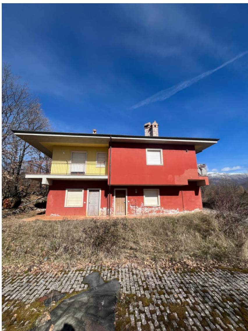
Foto n. 1 – Prospetto del fabbricato
