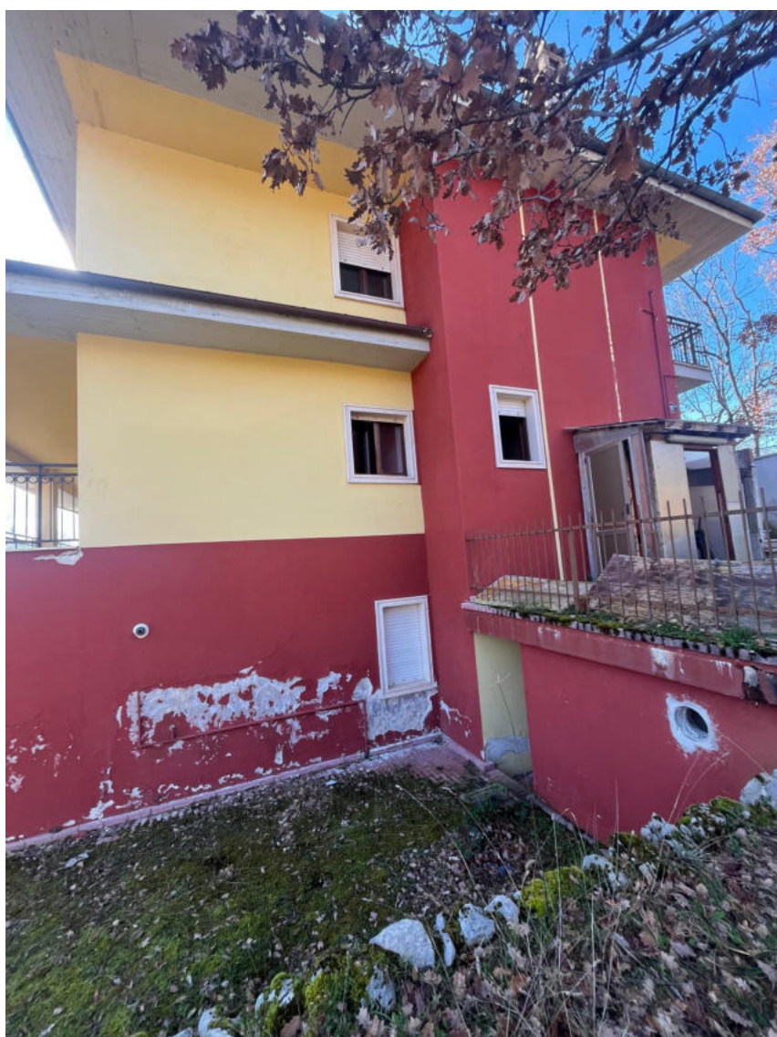
Foto n. 3 – Prospetto del fabbricato
