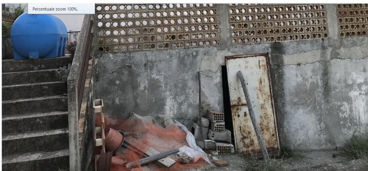
Vista prospettica retrostante dell'edificio in perizia (particolare scala accesso al PT)
