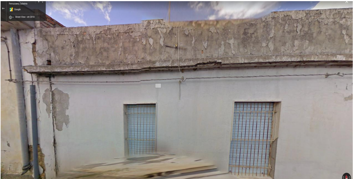
Vista prospettica (da Via Luigi Settembrini) dell'edificio in perizia - Particolare facciata
