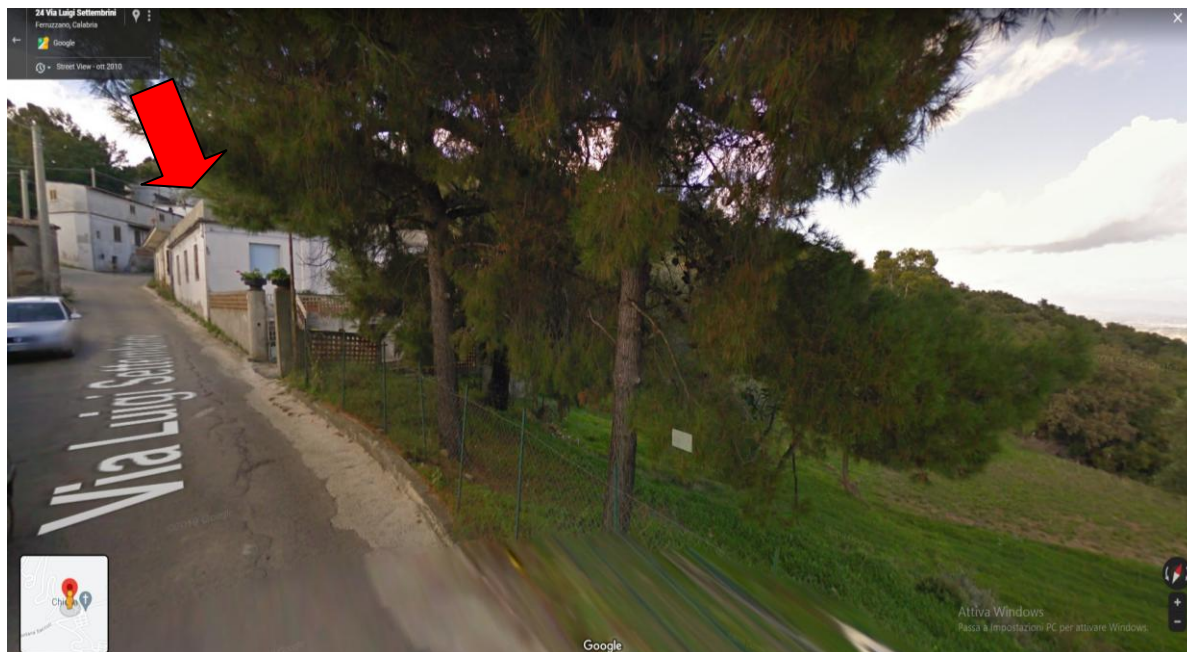
Vista prospettica (da Via Luigi Settembrini) dell'edificio in perizia
