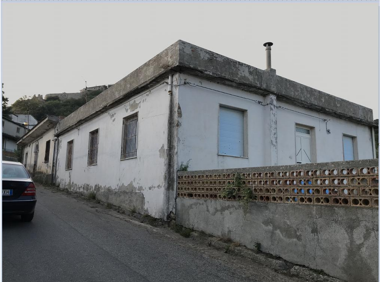
Vista prospettica (da Via Luigi Settembrini) dell'edificio in perizia
