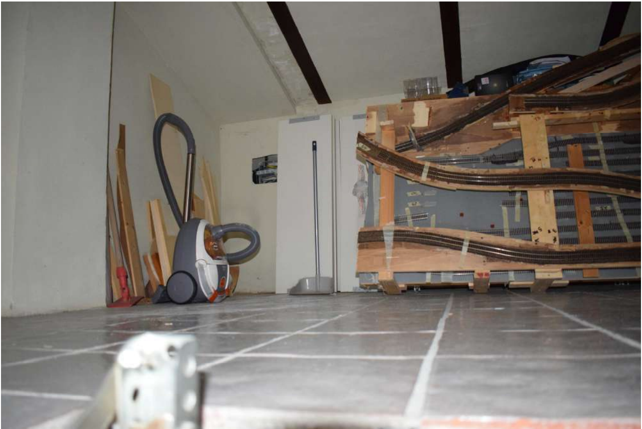
Foto n. 110 _ Sopralluogo del 05/10/2021 Il sottotetto accessibile dalla porzione [REDACTED]
