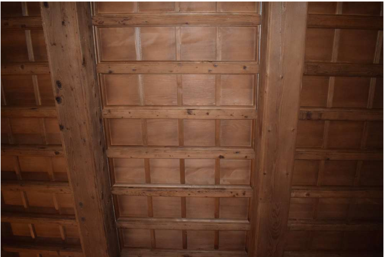
Foto n. 82 _ Sopralluogo del 05/10/2021 Il solaio ligneo della sala
