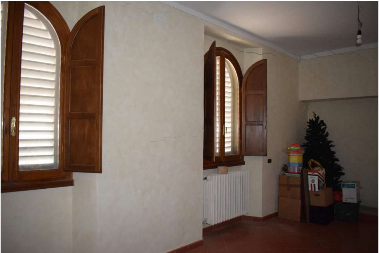
Foto n. 102 _ Sopralluogo del 05/10/2021 Piano primo: camera 1
