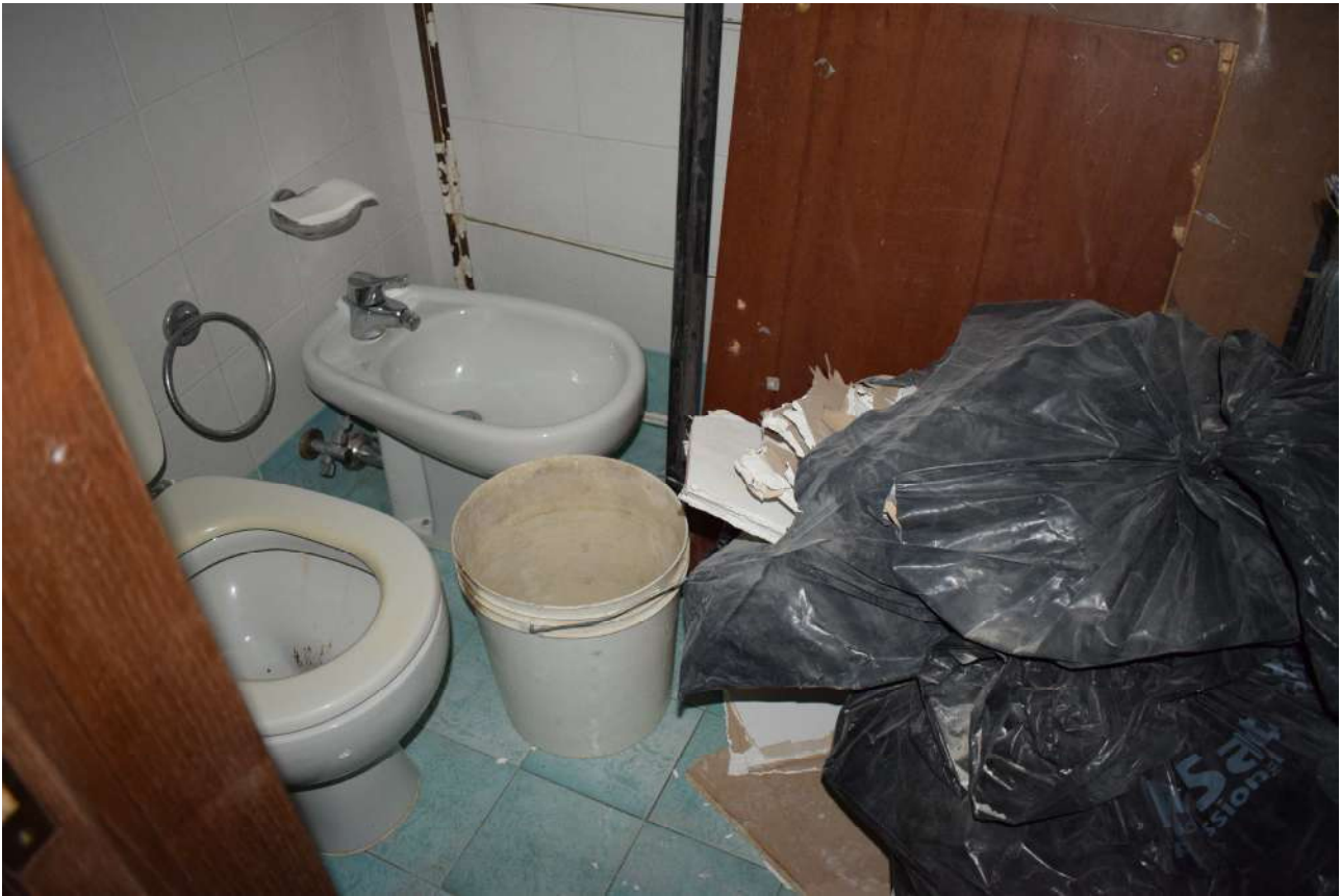
Foto n. 97 _ Sopralluogo del 05/10/2021 Uno dei due bagni (sotto soppalco) con materiali accatastati
