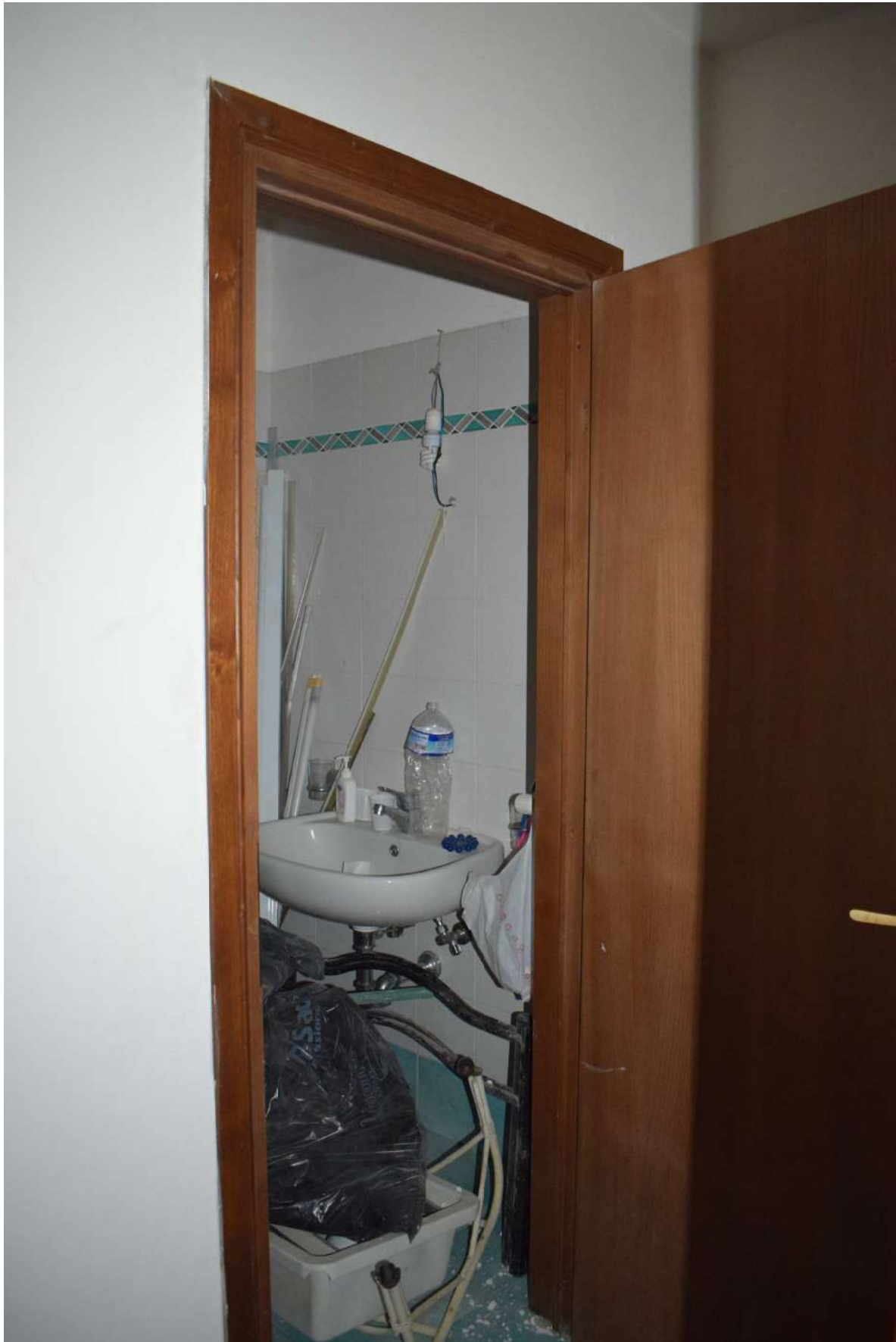
Foto n. 95 _ Sopralluogo del 05/10/2021 Uno dei due bagni (sotto soppalco) con materiali accatastati
