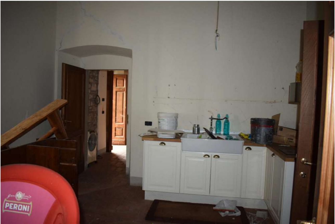
Foto n. 92 _ Sopralluogo del 05/10/2021 Cucina non collegata alla rete di acqua, gas e scarichi
