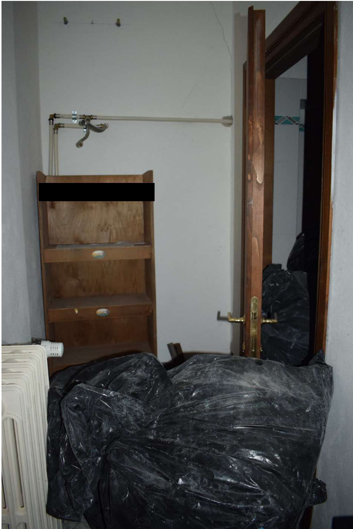
Foto n. 96 _ Sopralluogo del 05/10/2021 Antibagno (sotto soppalco) con materiali accatastati
