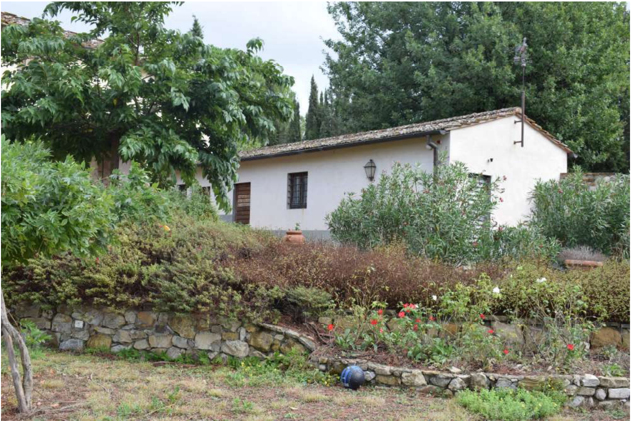
Foto n. 135 _ Sopralluogo del 05/10/2021 Annessi e locali tecnici
