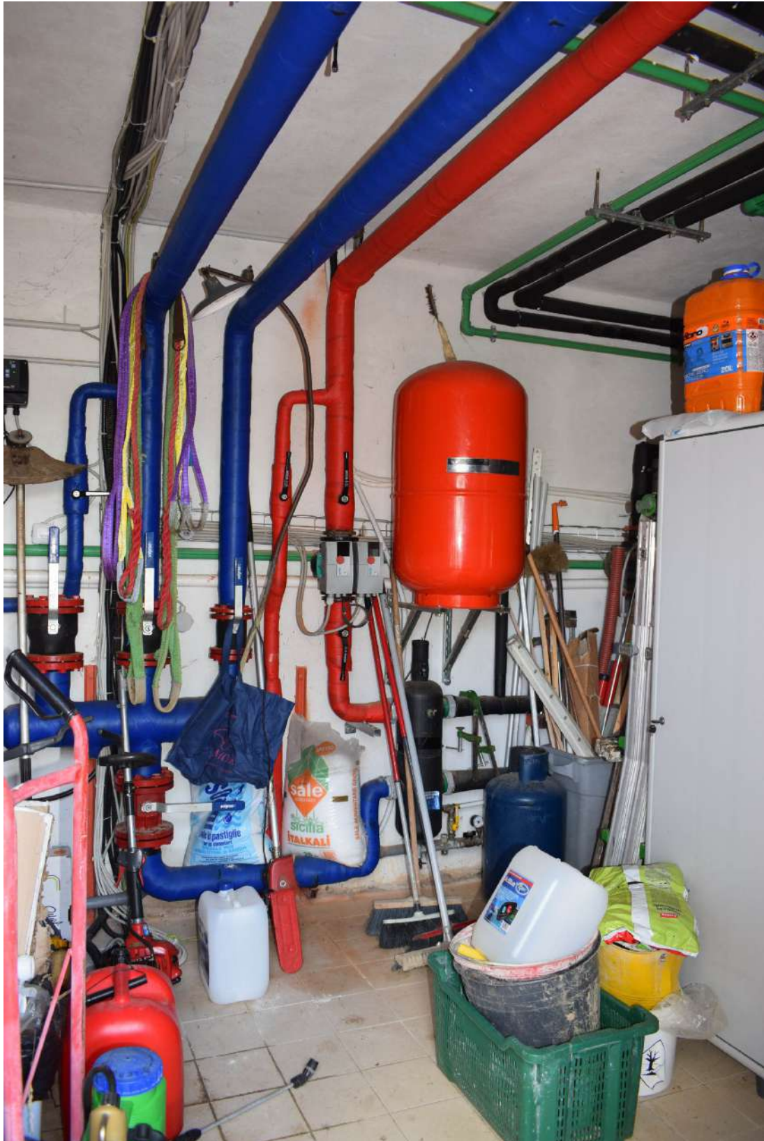
Foto n. 139 _ Sopralluogo del 05/10/2021 Annessi: locale 3 (locaie tecnico)
