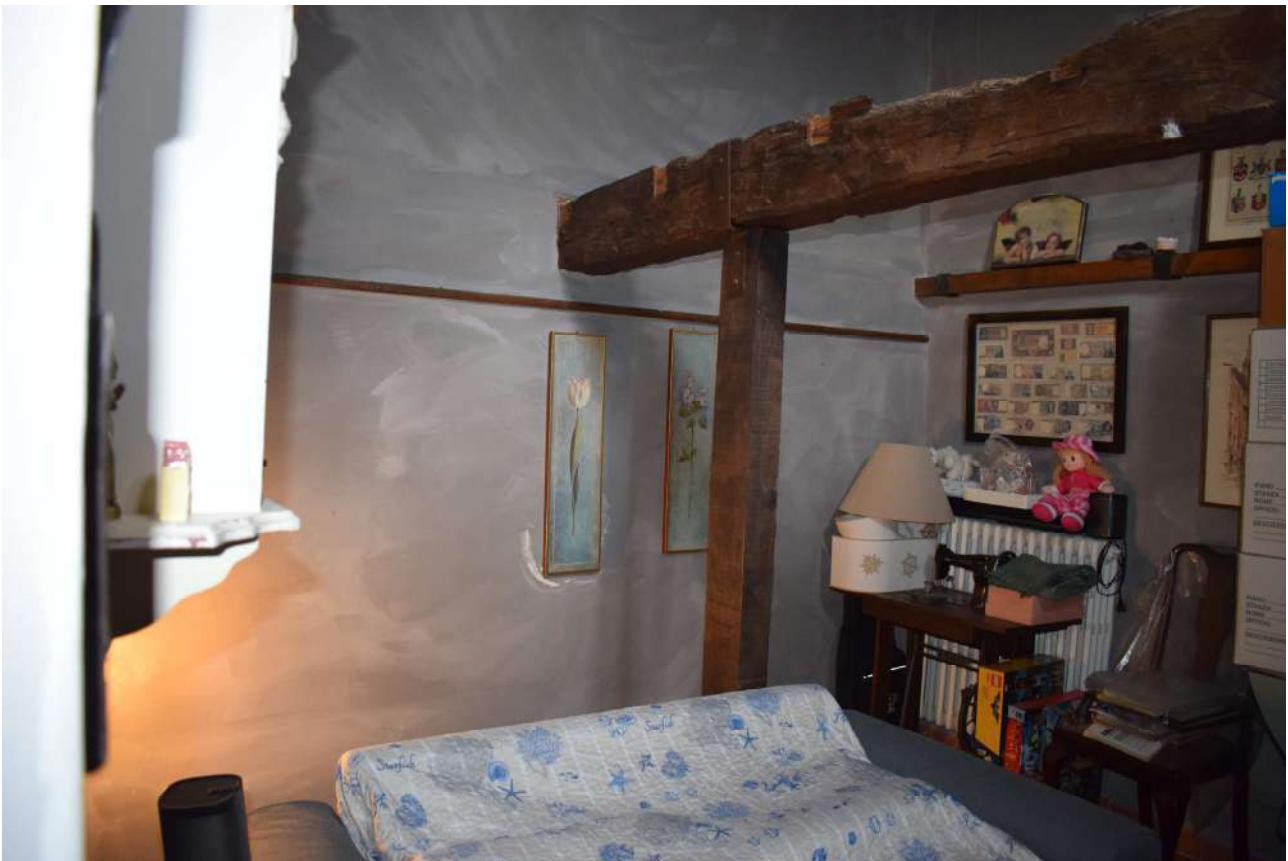
Foto n. 71 _ Sopralluogo del 05/10/2021 Piano secondo: camera in torre
