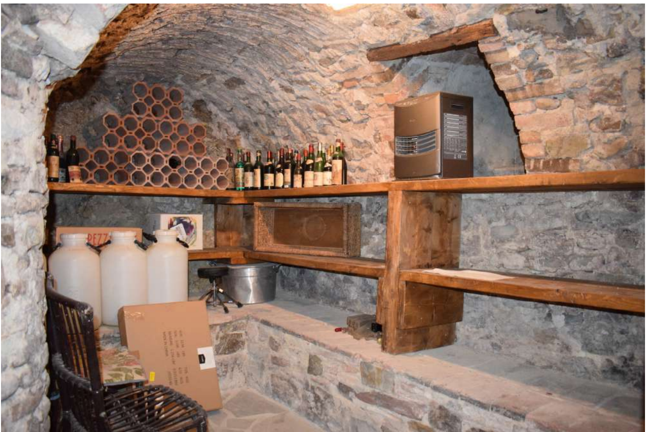
Foto n. 62 _ Sopralluogo del 05/10/2021 Piano interrato: cantina 1 (accessibile da ingresso foto n. 60)
