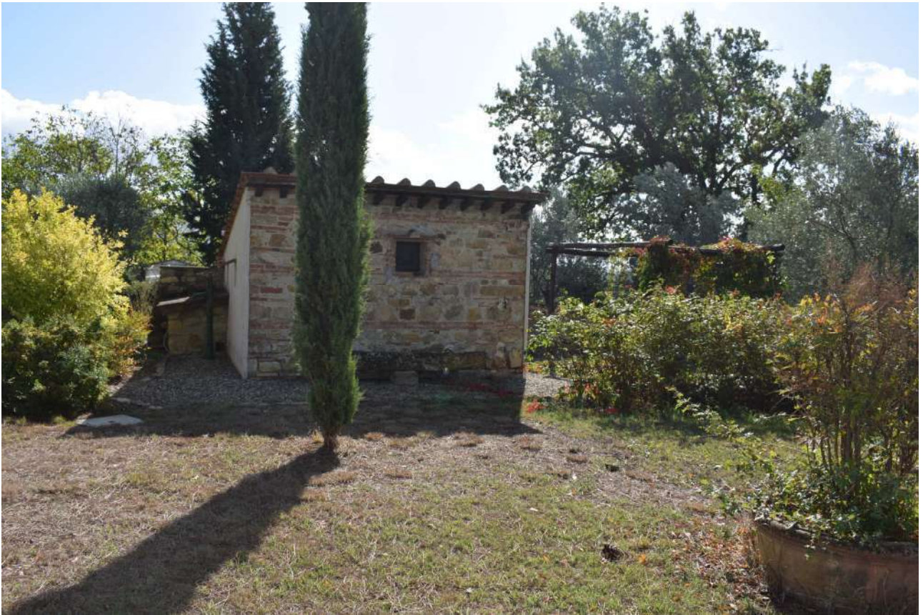
Foto n. 36 _ Sopralluogo del 05/10/2021 Un annesso isolato nel giardino tergale
