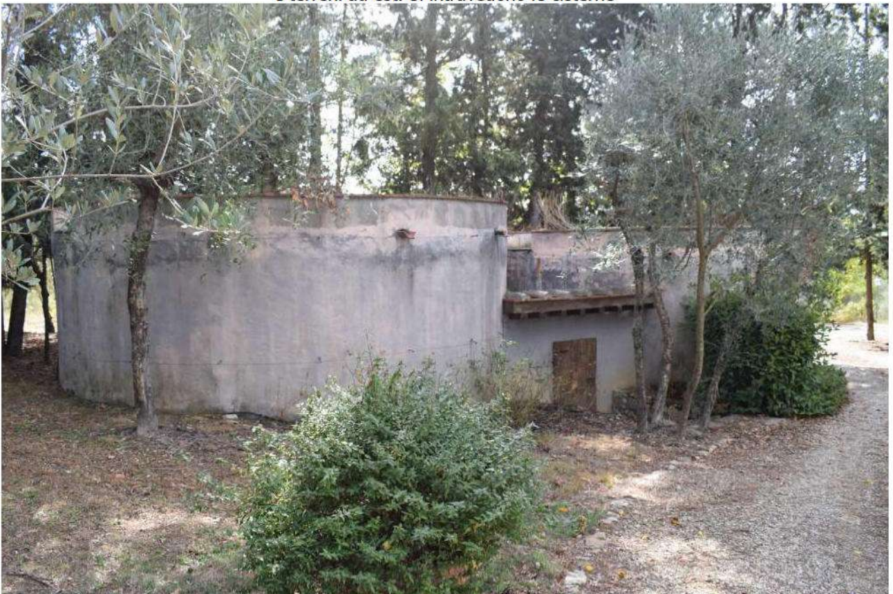
Foto n. 43 _ Sopralluogo del 05/10/2021 Cisterne
