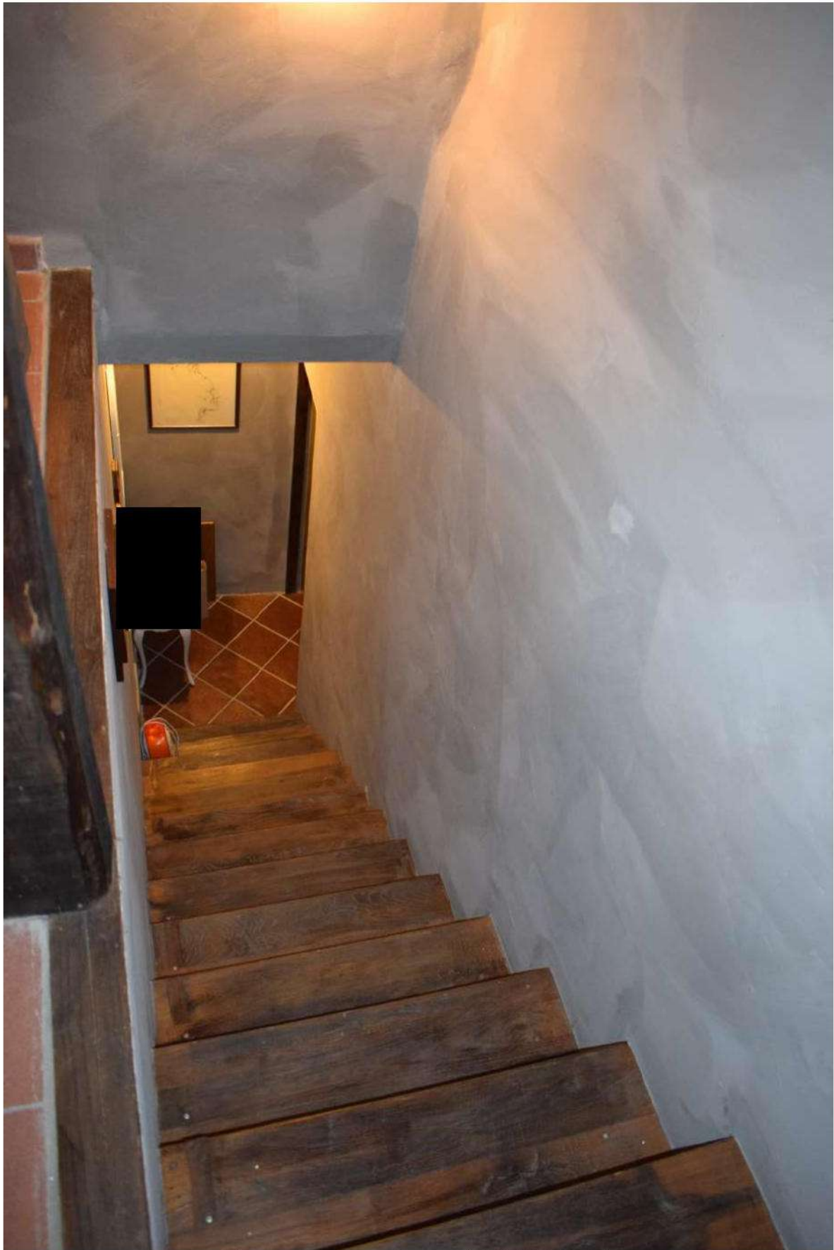
Foto n. 69 _ Sopralluogo del 05/10/2021 Dalla torre vista sulle scale di accesso
