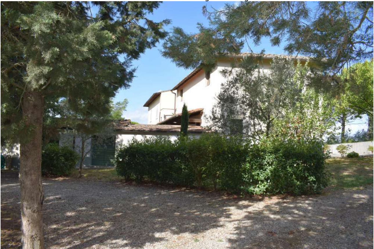
Foto n. 41 _ Sopralluogo del 05/10/2021 Lato est della villa e degli annessi
