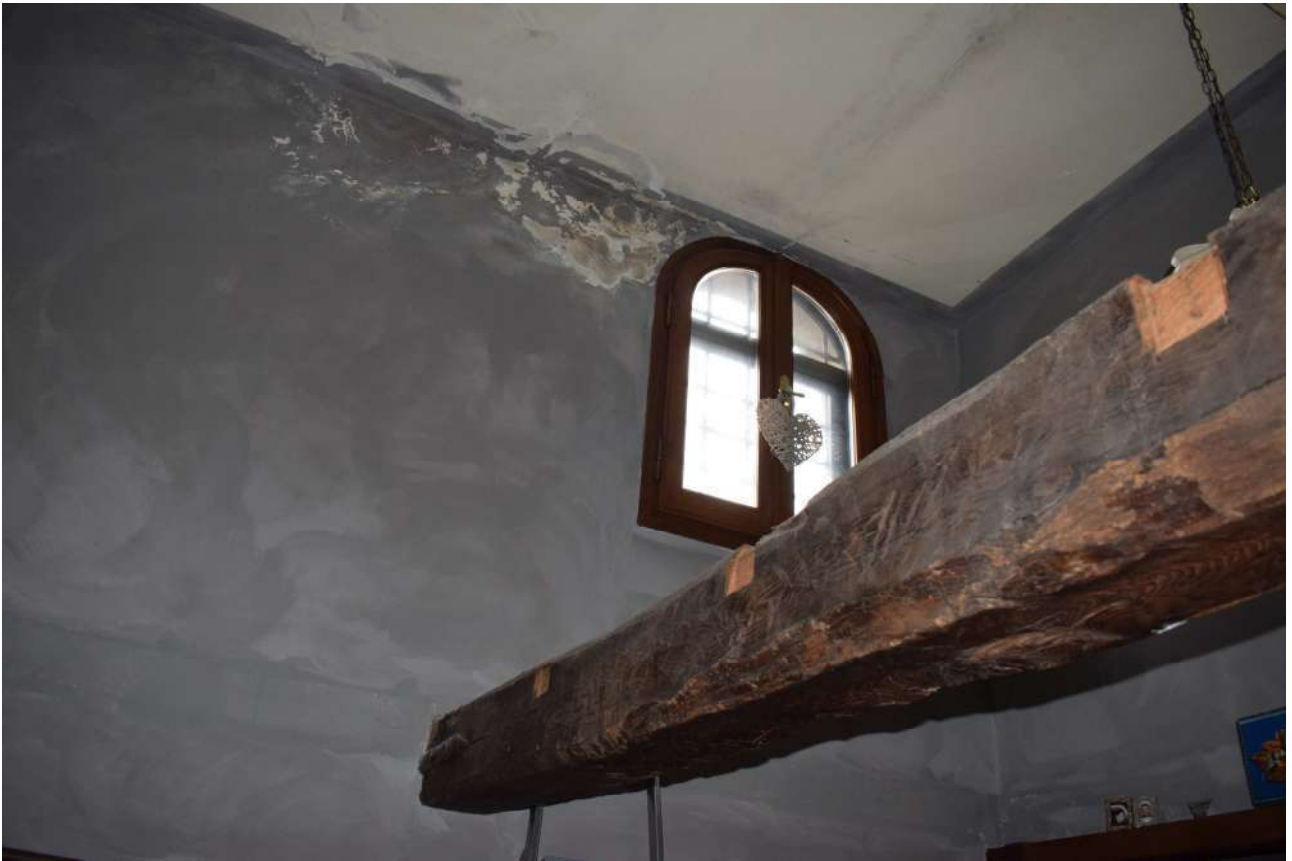
Foto n. 72 _ Sopralluogo del 05/10/2021 Piano secondo: camera in torre
