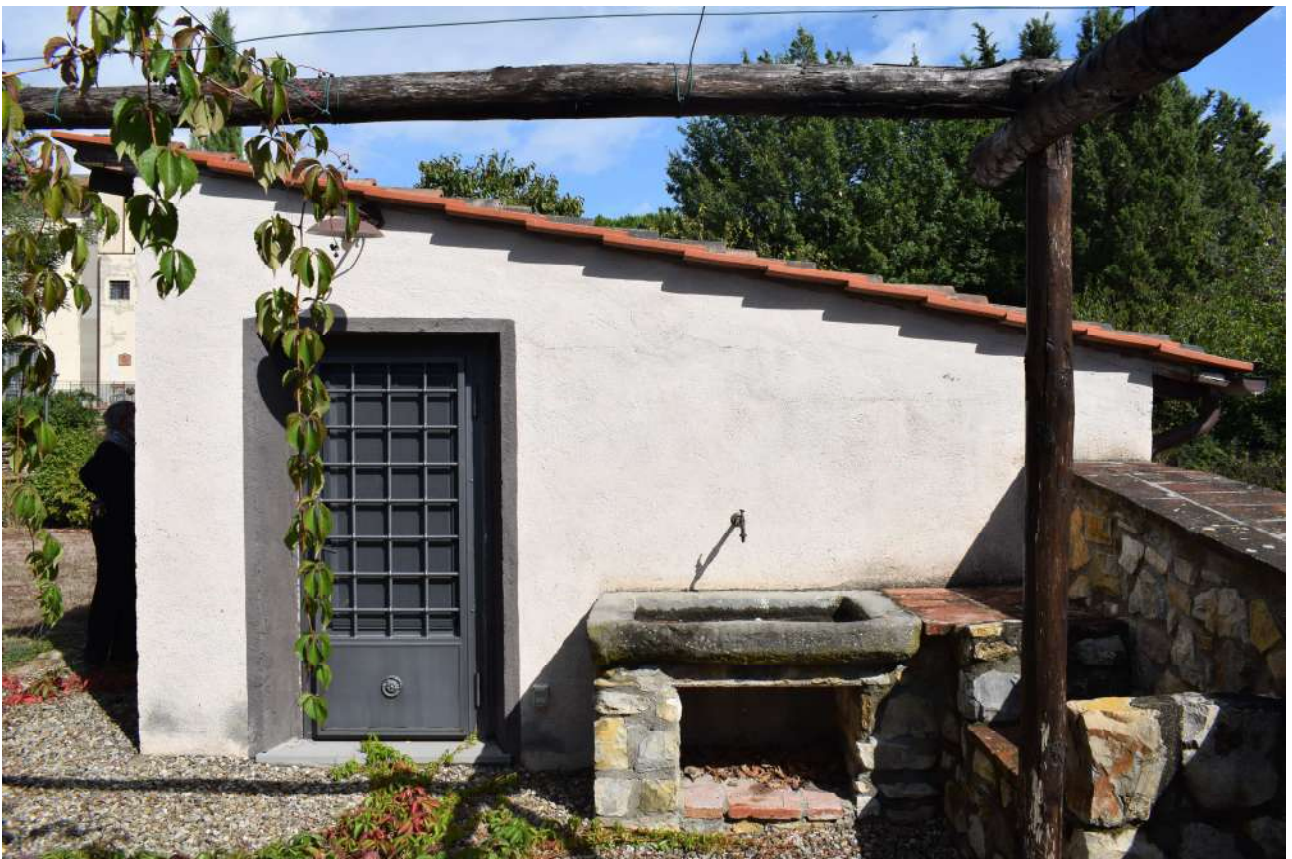
Foto n. 37 _ Sopralluogo del 05/10/2021 L'annesso di cui alla foto precedente
