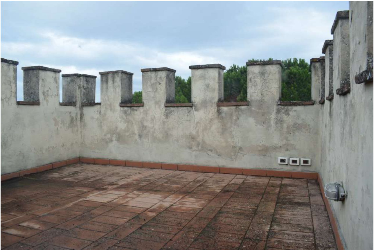
Foto n. 74 _ Sopralluogo del 05/10/2021 La terrazza (copertura piana della torre) con coronamento merlato
