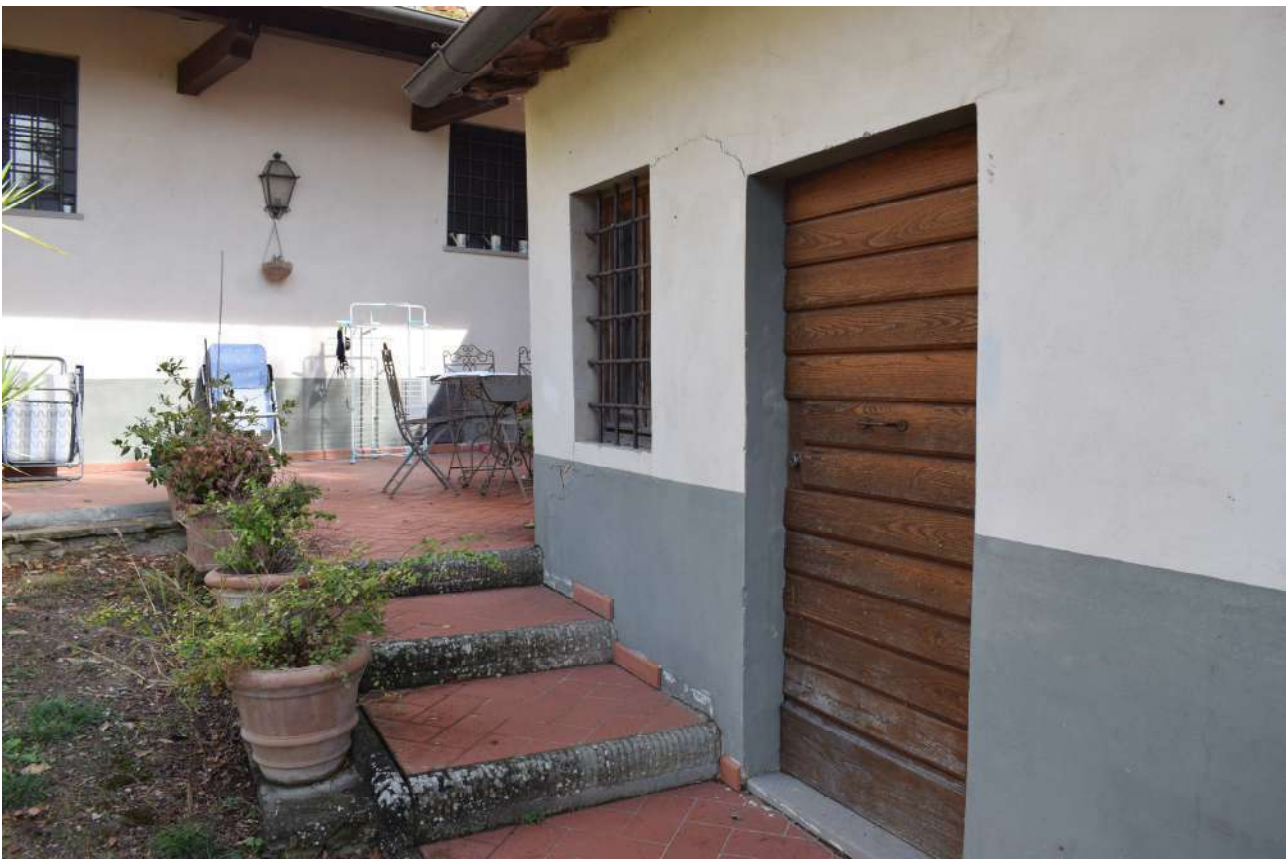
Foto n. 31 _ Sopralluogo del 05/10/2021 A lato la porta di un annesso al sub 500 e più in là il resede del sub 501
