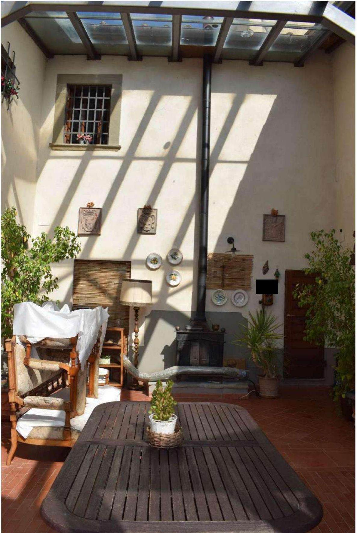
Foto n. 56 _ Sopralluogo del 05/10/2021 La veranda con struttura in ferro e vetro
