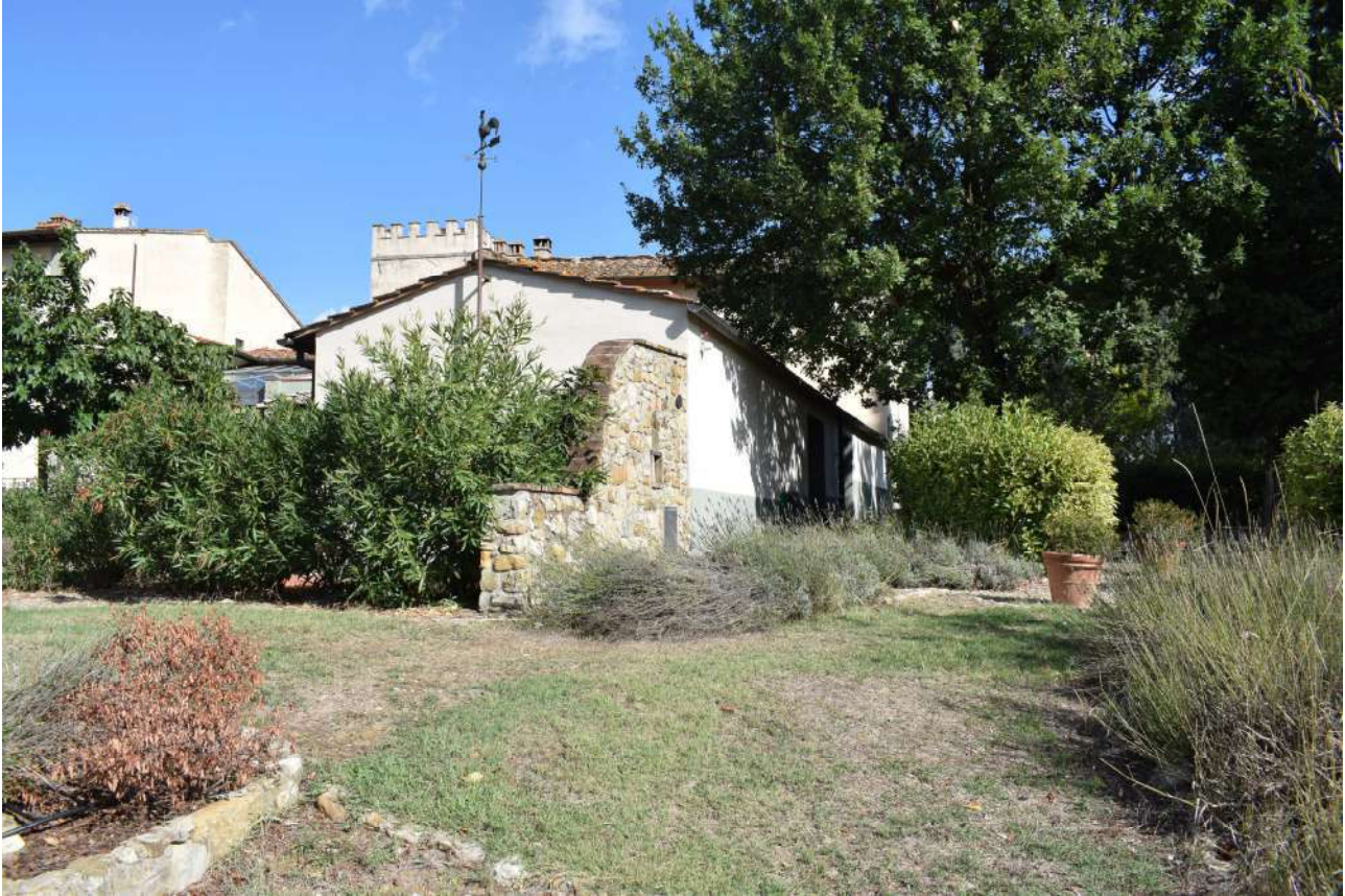
Foto n. 40 _ Sopralluogo del 05/10/2021 Gli annessi al sub 500 nel giardino tergale
