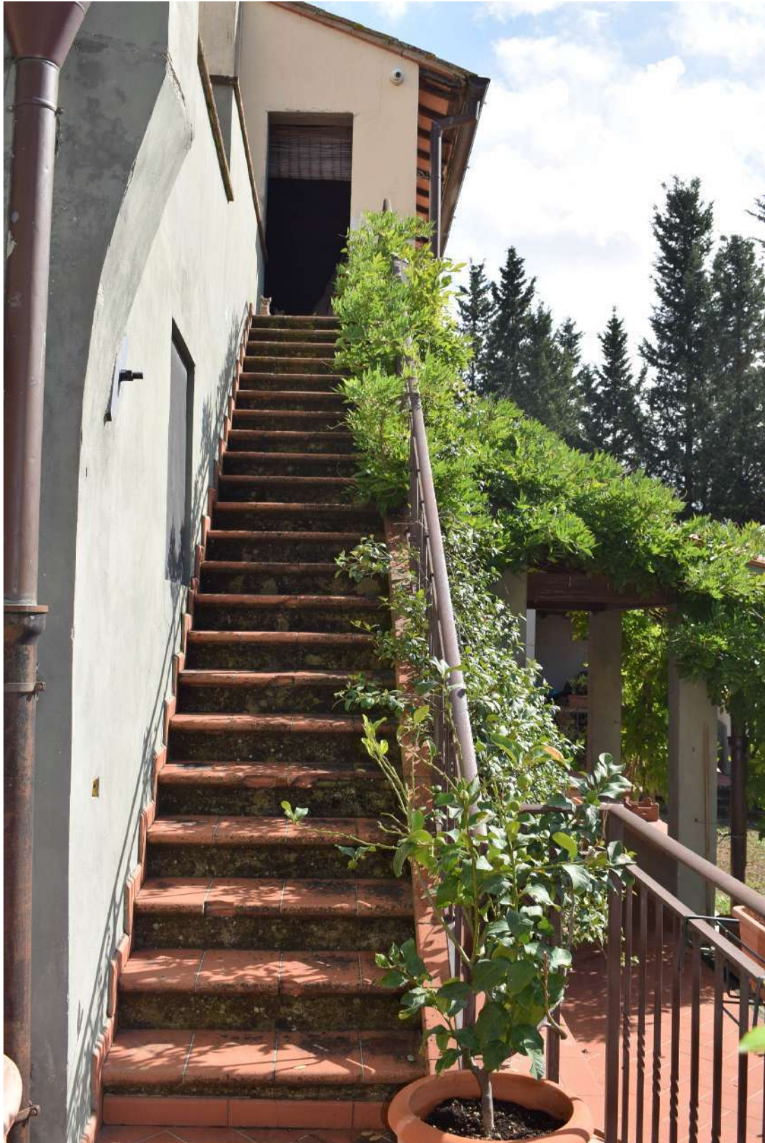
Foto n. 29 _ Sopralluogo del 05/10/2021 La scala esterna di accesso al magazzino
