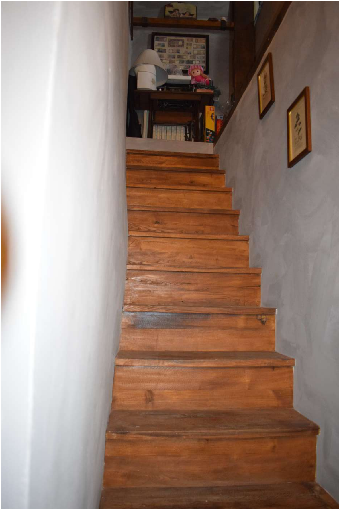
Foto n. 68 _ Sopralluogo del 05/10/2021 Dal piano primo la scaletta in legno conduce alla torre
