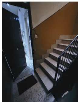
Vano scala da cui si accede all'immobile.
