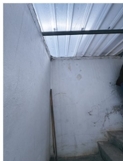
Vano scala da cui si accede all'immobile.
