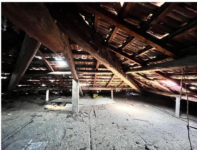
Immagine 49, 50. Il sottotetto, che rappresenta catastalmente una unità autonoma oggi è deposito ma potrebbe avvantaggiarsi della possibilità di un recupero tramite ristrutturazione edilizia ai fini abitativi.
