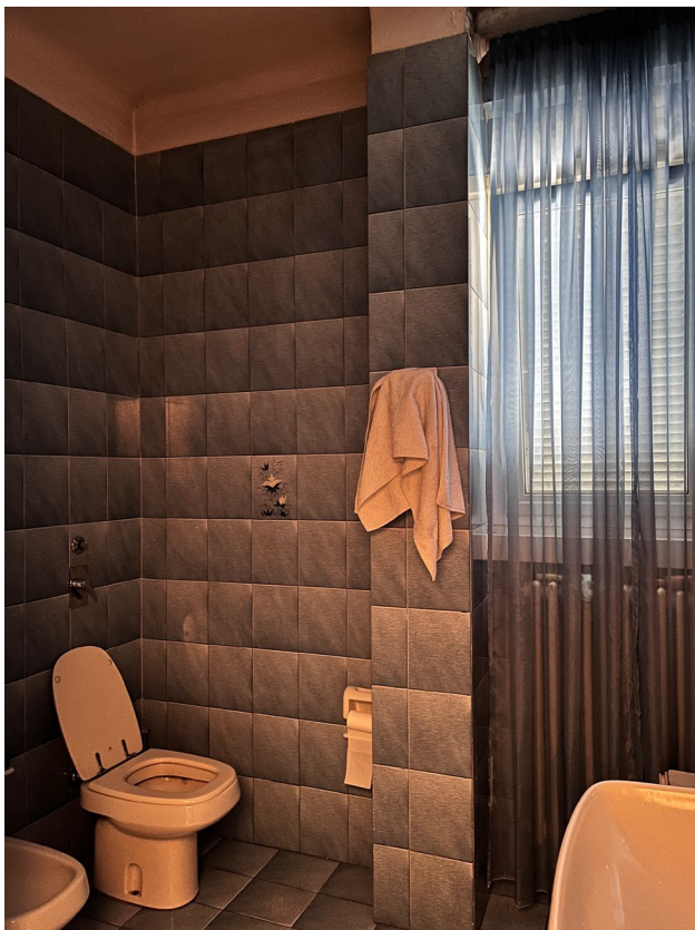
Immagine 26. Il secondo bagno che, come il primo, è aerato e illuminato naturalmente.
