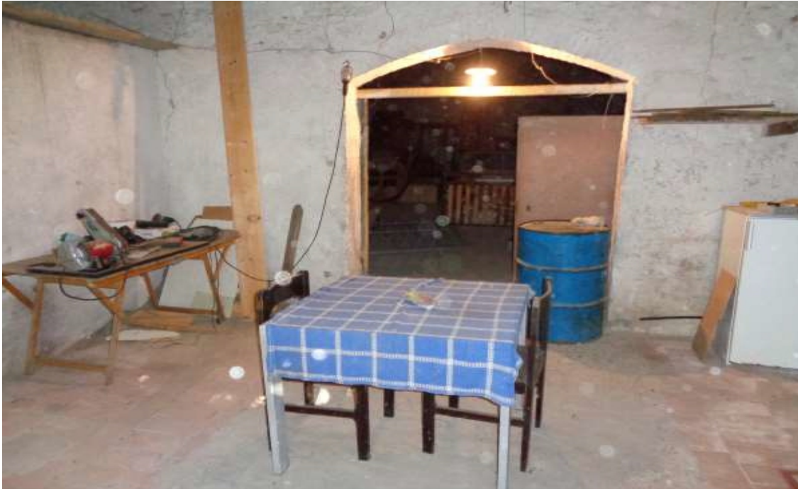
cantina primo ambiente
