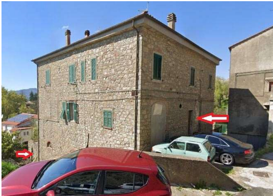
Accesso esterno cantina dal fabbricato
