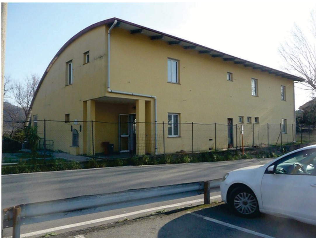
Foto n 7 prospetto principale fabbricato
