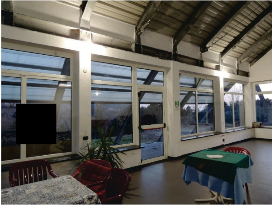
Foto n 35 Sala principale PT lato sud-ovest
