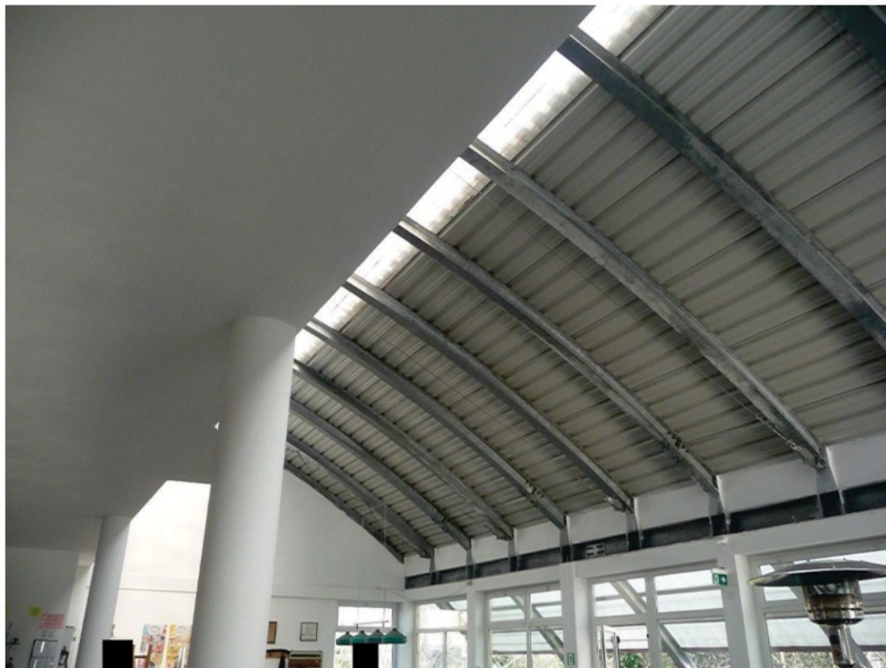
Foto n 38 Vista copertura con travatura curva in acciaio e pannelli traslucidi
