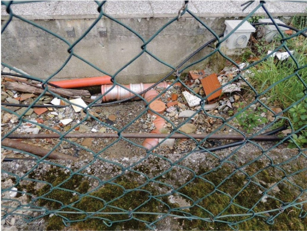
Foto n 19 predisposizione da completare per allaccio fognario comunale lato nord esterno fabbricato
