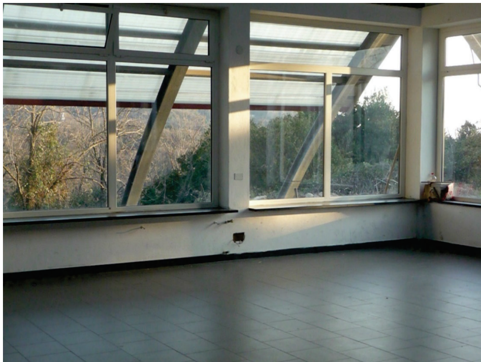
Foto n 32 impianti di riscaldamento con attacco ai caloriferi sottratti
