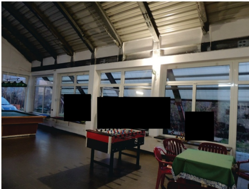
Foto n 34 Sala principale PT parete finestrata lato sud-est
