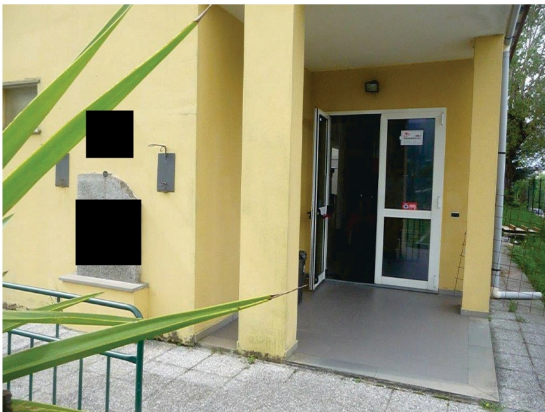
Foto n 15 ingresso della sede Circolo [redacted] via Pierino Negrotto Cambiaso civico n. 67D
