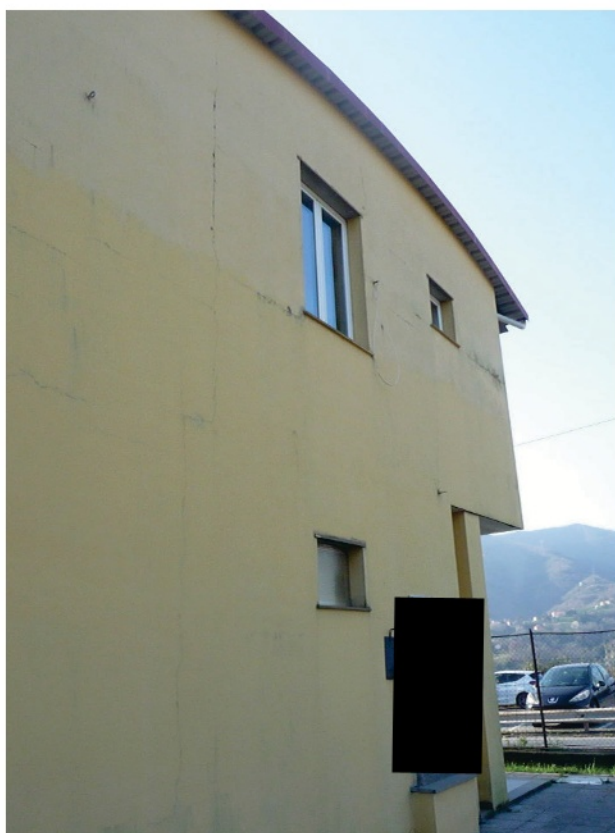
Foto n 16 prospetto nord-est fabbricato
