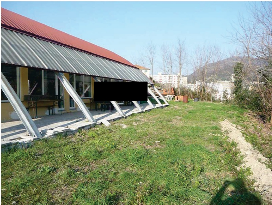
Foto n 20 esterno fabbricato e spazio verde antistante da sistemare
