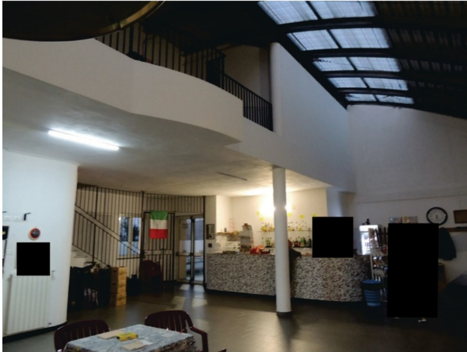
Foto n 25 Sala principale PT con vista su PP
