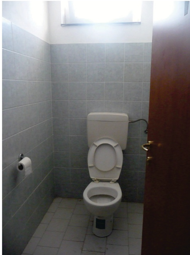
Foto n 37 Bagni PT n 2 + 1 handicappati
