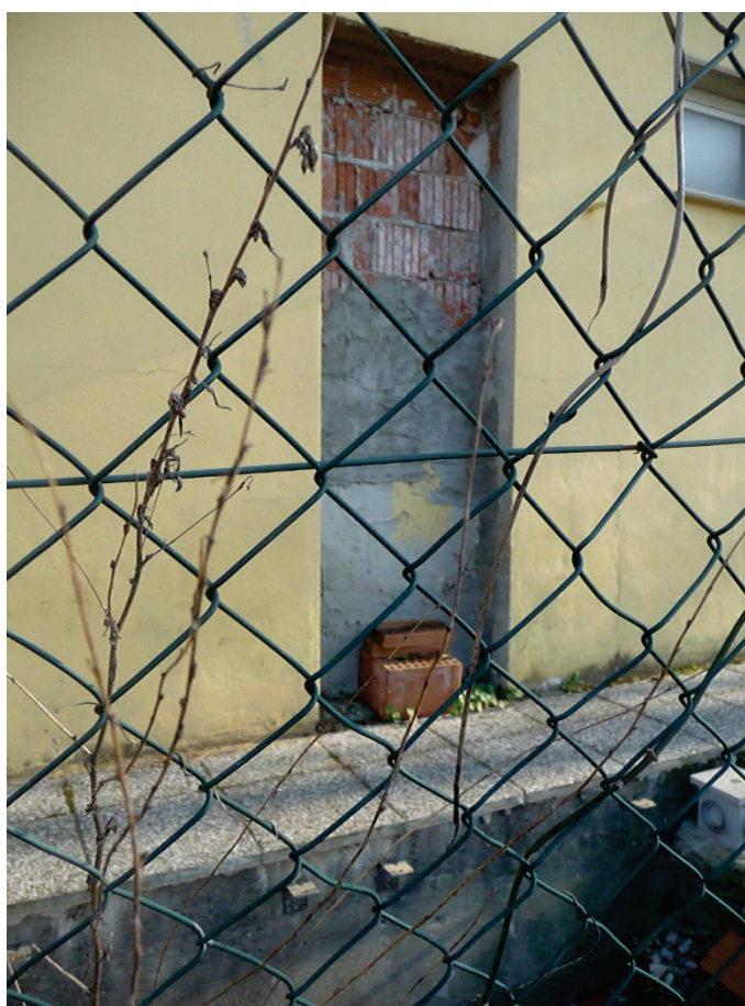
Foto n 18 particolare costruttivo esterno fabbricato lato nord da completare
