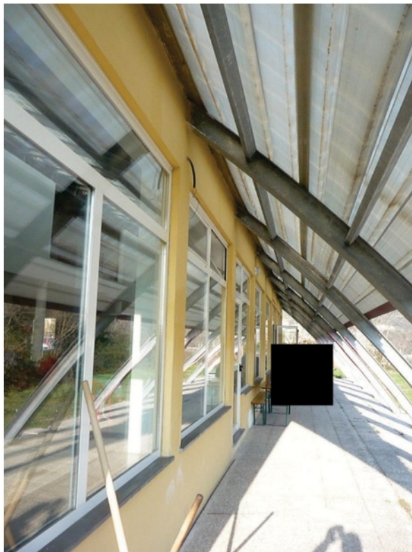
Foto n 22 esterno fabbricato con particolare area coperta
