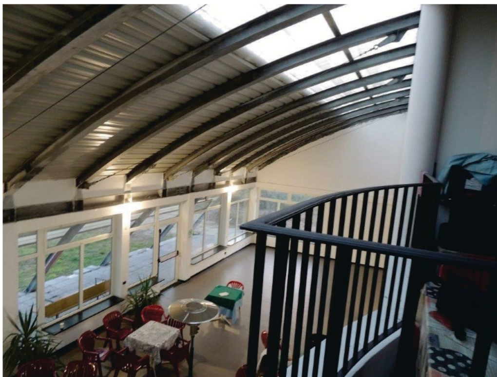
Foto n 44 PP vista su sala principale da soppalco lato sud-ovest
