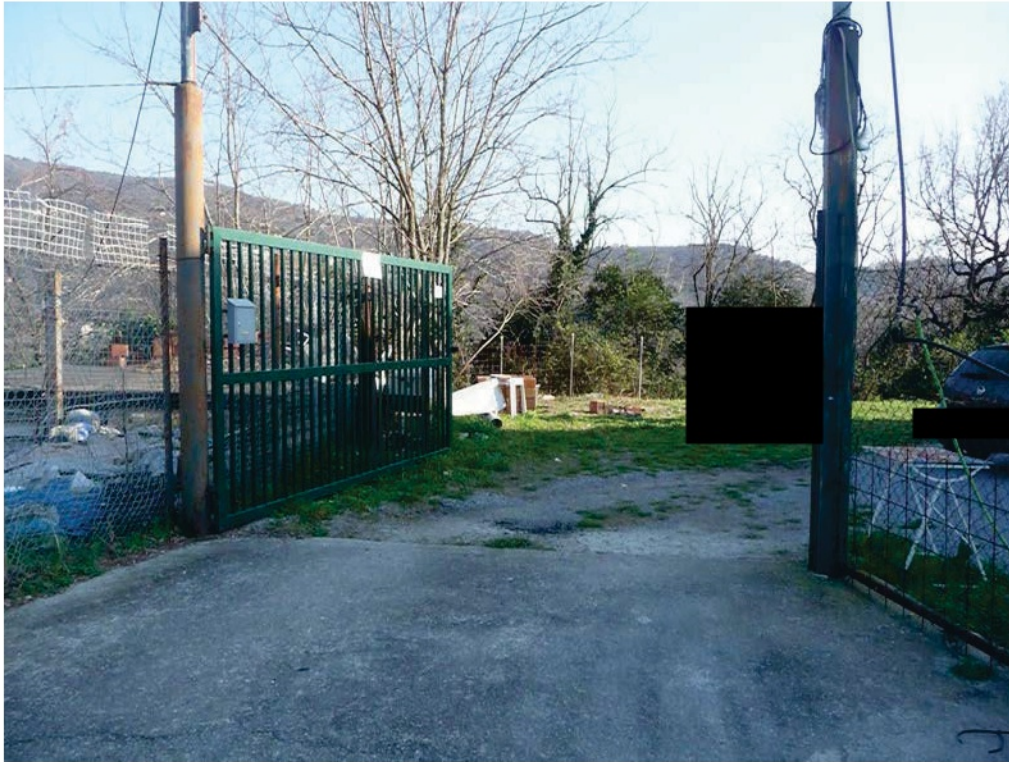
Foto n 11 cancello di ingresso fabbricato con terreni di proprietà civ 67 D
