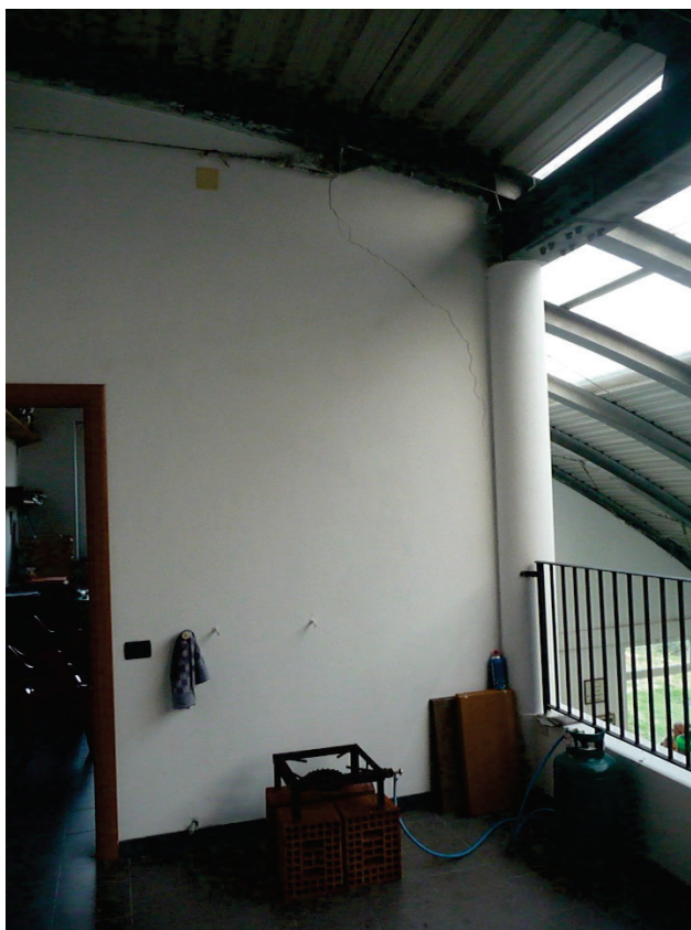
Foto n 45 ballatoio su soppalco dettaglio
