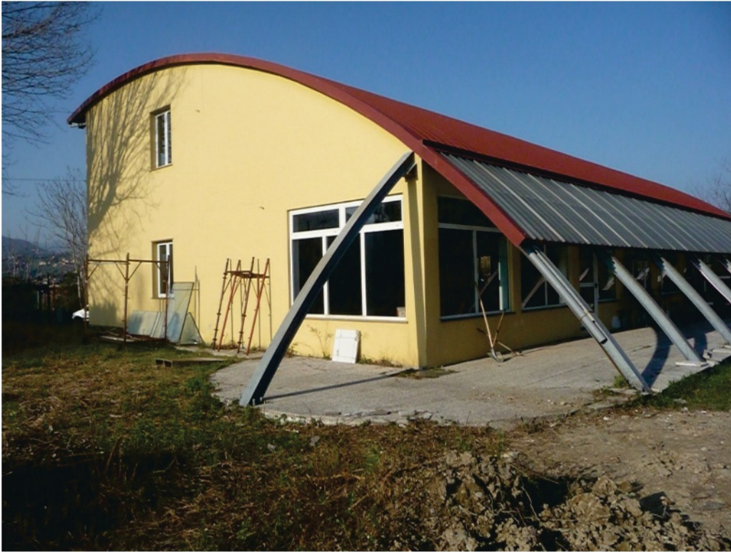
Foto n 21 esterno fabbricato con area limitrofa lato sud-ovest
