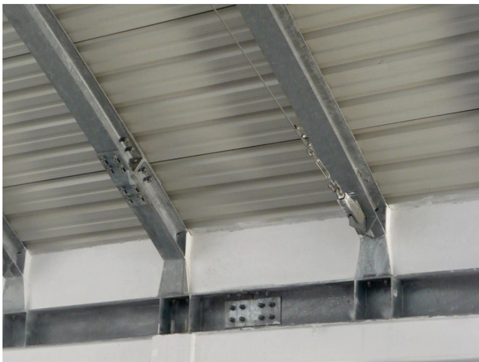
Foto n 39 copertura con travatura curva in acciaio e tiranti, dettaglio
