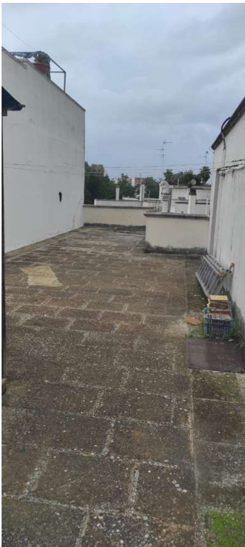
Figura 11 - LASTRICATO SOLARE DI COPERTURA
