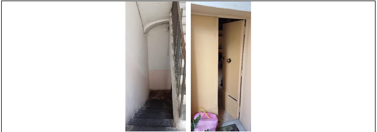
Foto n. 3/4 vista vano scala, ingresso
