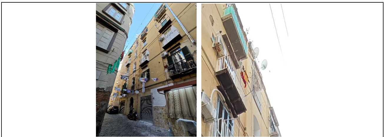
Foto n. 1/2 vista della Facciata d'ingresso e dell'unità
