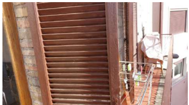
Foto nr.42: particolare infissi e balcone
