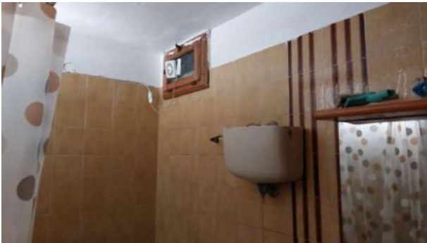
Foto nr.29: particolare zona bagno
