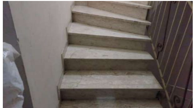
Foto nr.14: particolare scala in proprietà esclusiva
