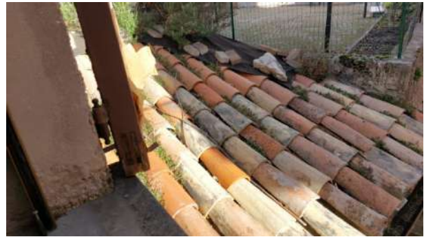
Foto nr.06: vista manto di copertura
