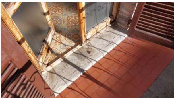
Foto nr.41: particolare infissi
