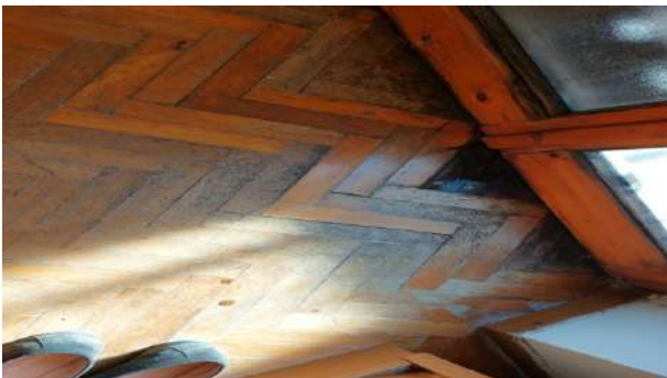
Foto nr.33: particolare camera 1
