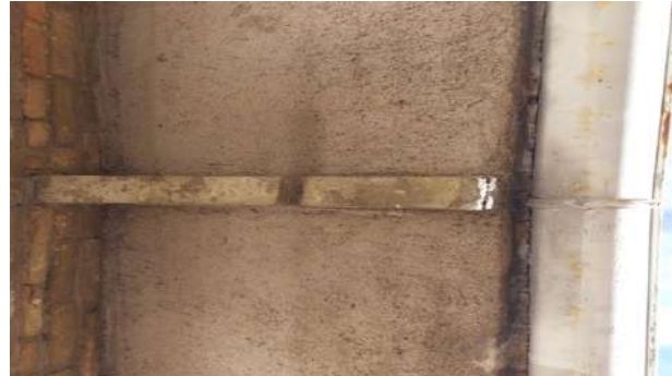
Foto nr.08: particolare sporto di gronda
