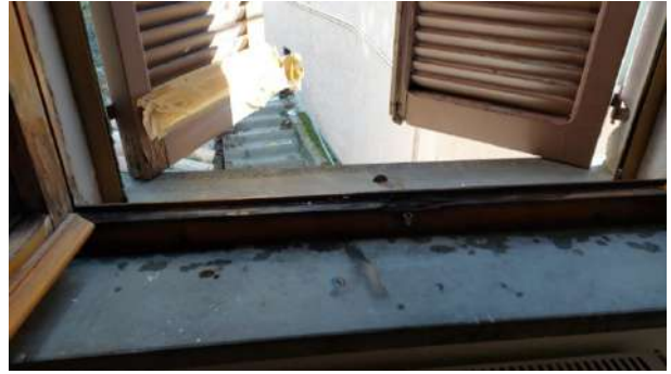
Foto nr.36: particolare infissi
