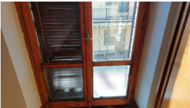
Foto nr.39: particolare infissi
