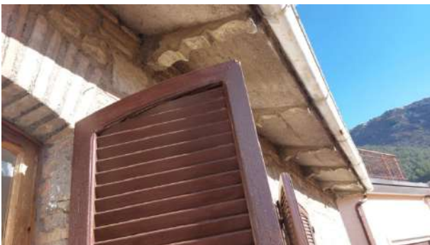
Foto nr.07: vista sporto di gronda
