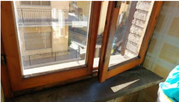
Foto nr.37: particolare infissi
