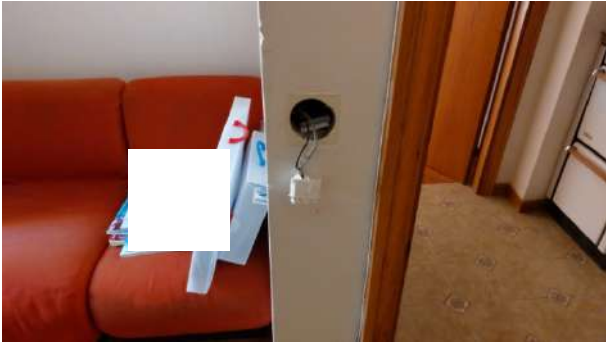
Foto nr.35: particolare camera 2
