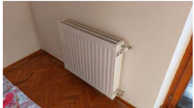
Foto nr.32: particolare camera 1
