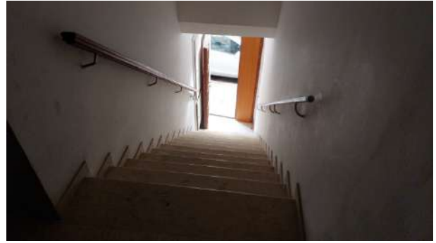
Foto nr.12: scala comune ingresso edificio
