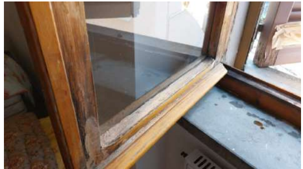
Foto nr.38: particolare infissi
