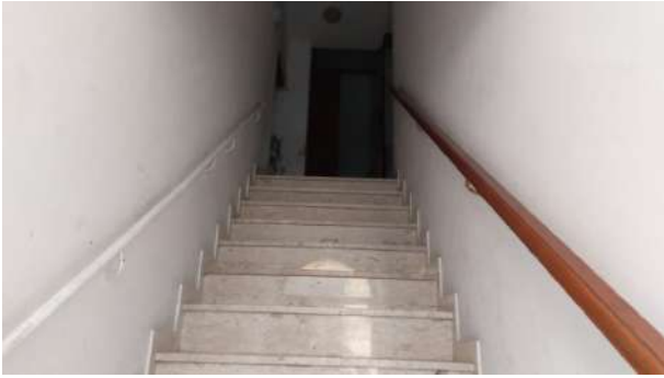
Foto nr.11: scala comune ingresso edificio
