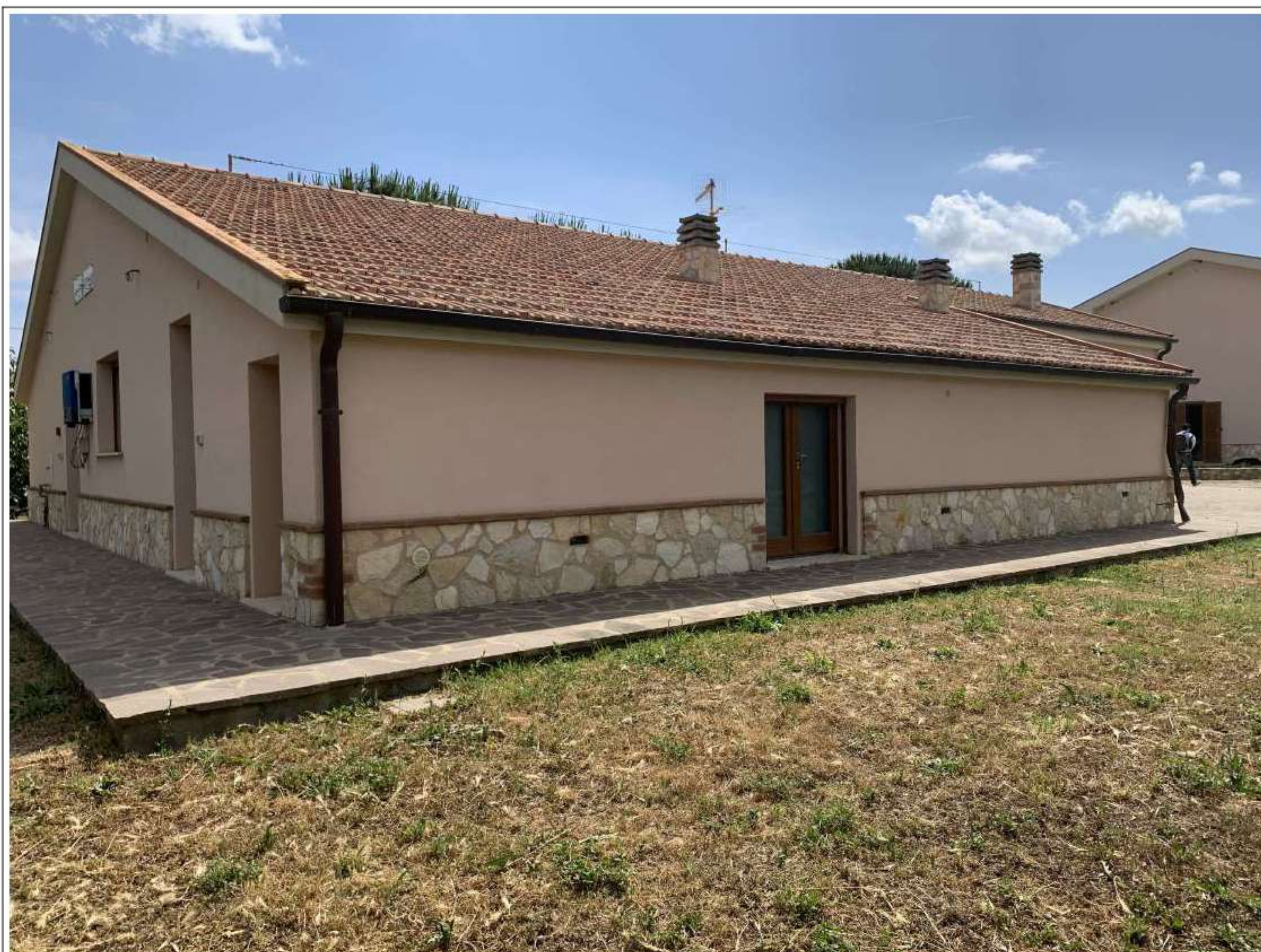
20 – Fabbricato B – esterno lato sud ovest – vendita/pasti agrituristici - laboratorio
