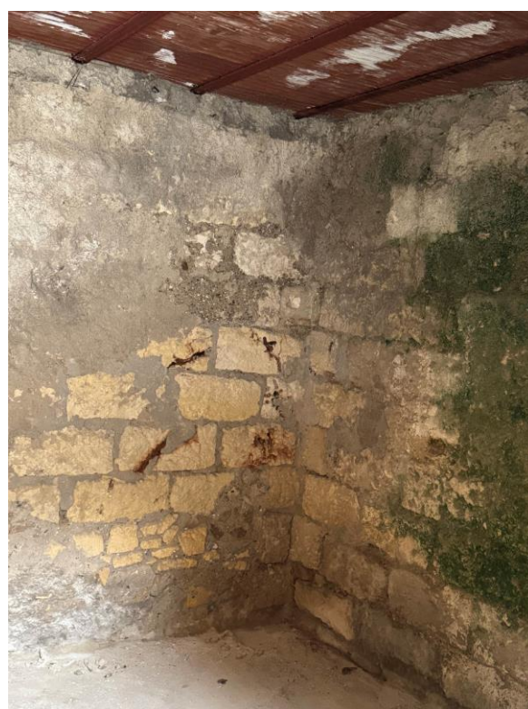
Foto n. 5 – Interno della camera coperta da solaio
