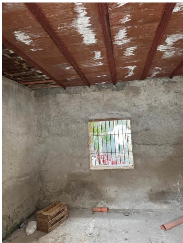
Foto n. 4 – Interno della camera coperta da solaio
