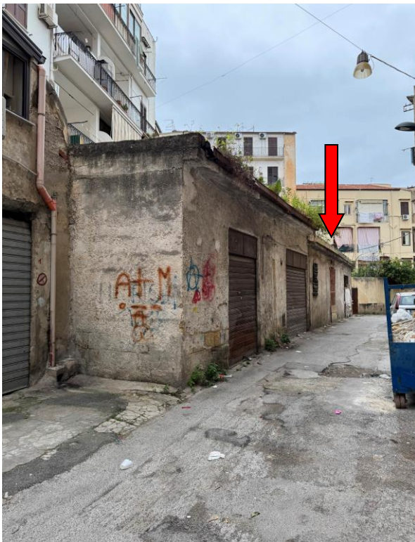
Foto n. 1 –Veduta dell'immobile da via Papa S. Leone II
