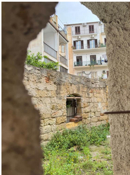
Foto n. 7 – Interno fotografato dalla finestra del WC
