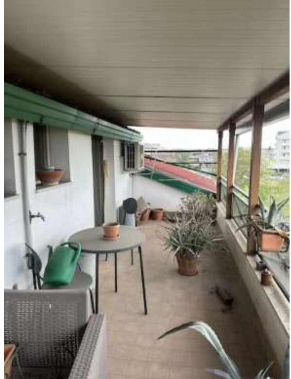
Foto n.5 – Particolare balcone coperto
