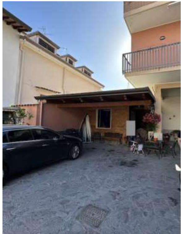
Foto n.3 – Particolare manufatto comune piano terra
