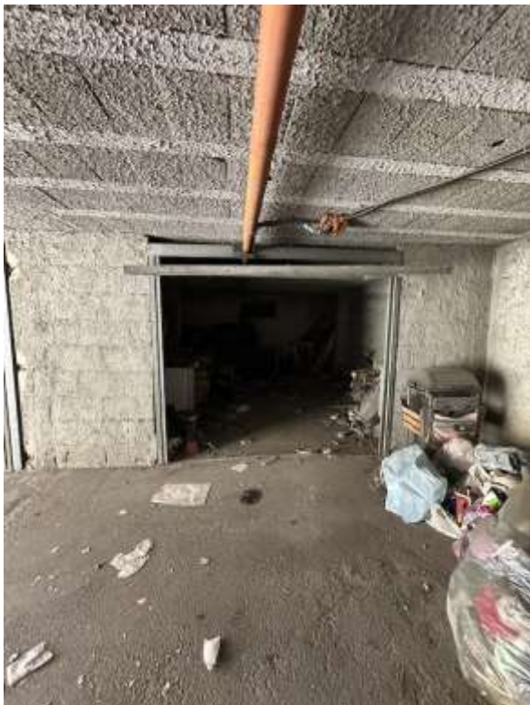
Foto n.6 – Particolare box auto pertinenziale
