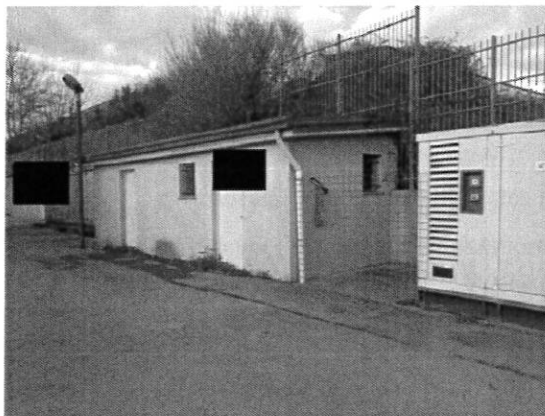
Vista esterna deposito C
