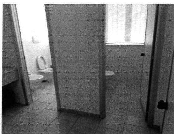
Vista interna - servizi igienici
