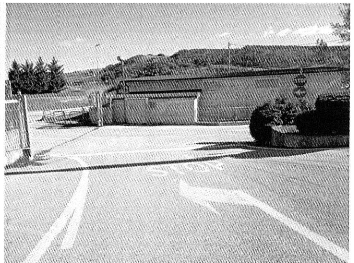
Foto n. 90 – Cabina elettrica - Part. 1120 sub 5
