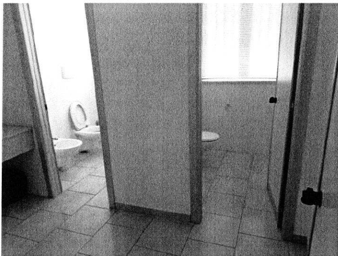
Foto n. 69 – Piano soppalco - bagni
