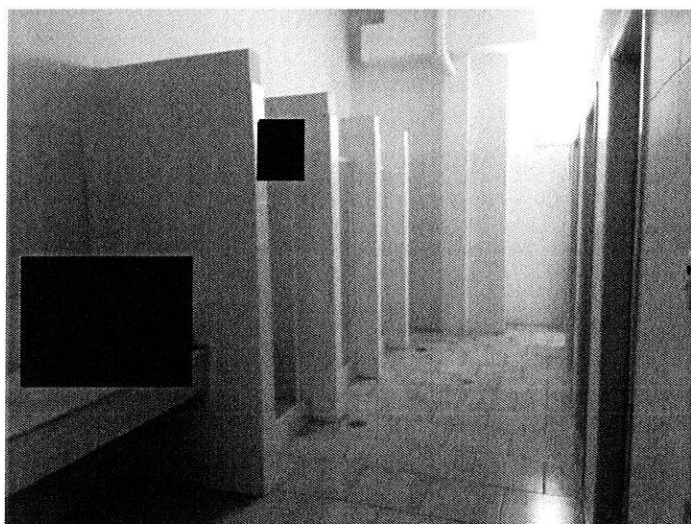
Foto n. 37 – Piano secondo sottostrada - Vista interna - servizi
