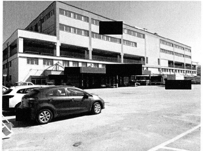
Foto n. 6 – Vista esterna immobile - Prospetto principale
