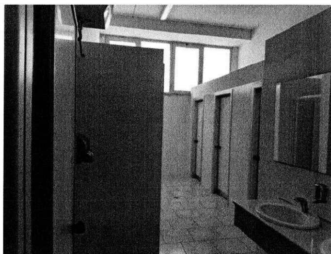
Foto n. 38 – Piano secondo sottostrada - Vista interna - servizi
