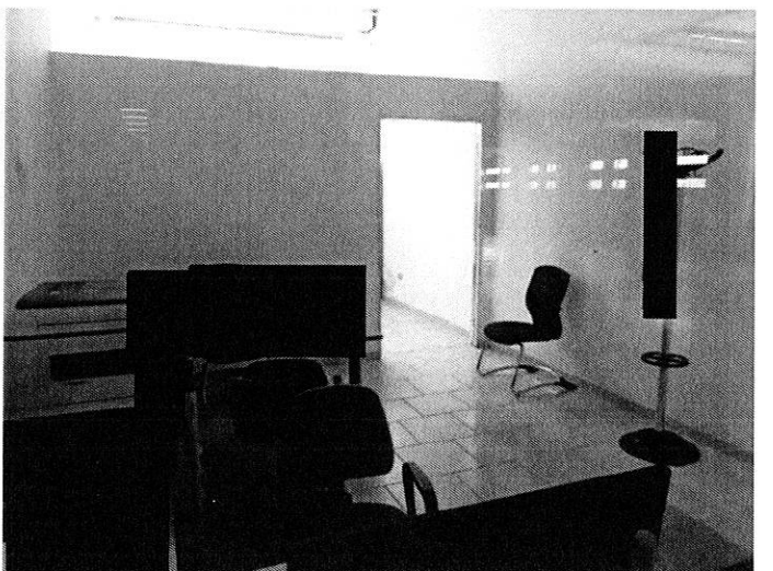
Foto n. 32 – Piano secondo sottostrada - Vista interna - ufficio
