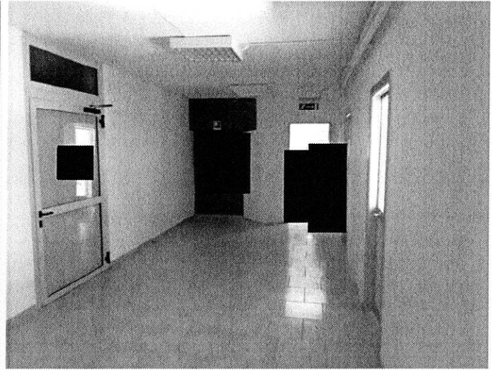
Foto n. 58 – Piano soppalco - disimpegno
