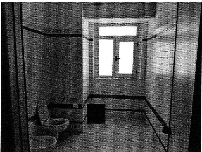
Foto n. 85 – Piano soppalco - ufficio 24 - bagno
