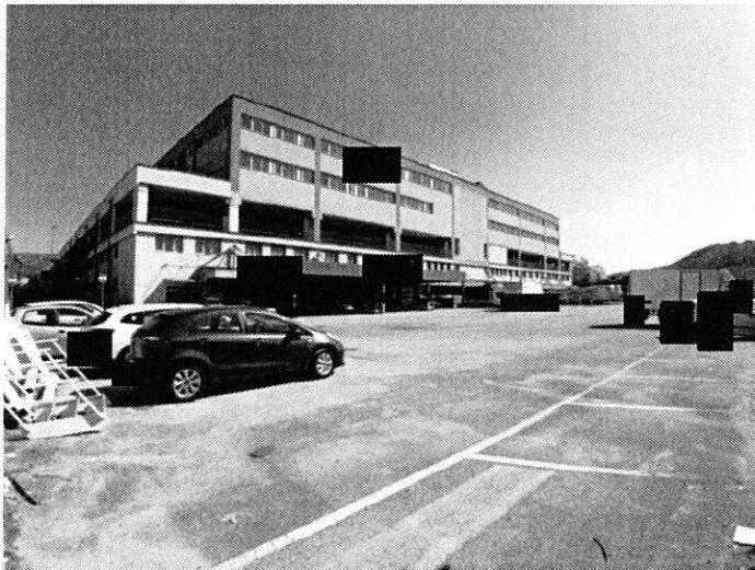
Foto n. 5 – Vista esterna immobile - Prospetto principale
