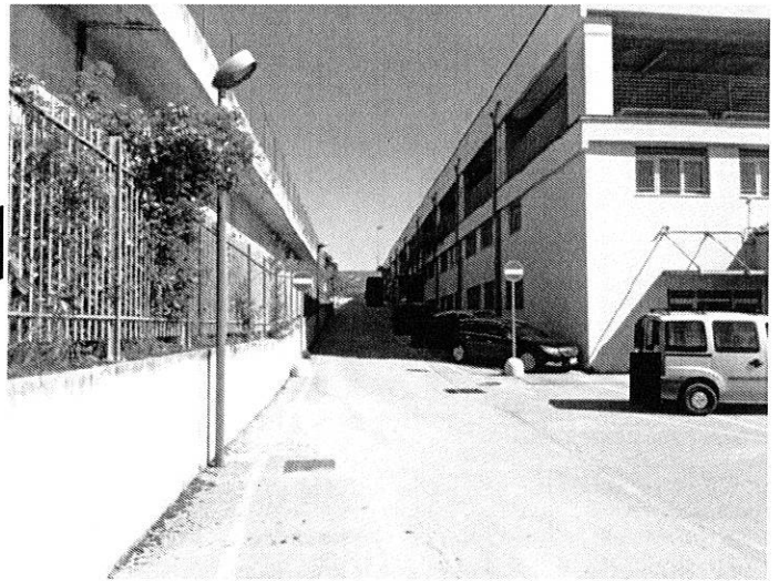
Foto n. 4 – Vista esterna immobile - Prospetto Ovest
