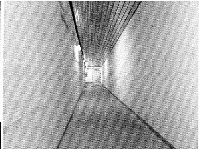
Foto n. 40 – Piano secondo sottostrada - Vista interna - tunnel laterale
