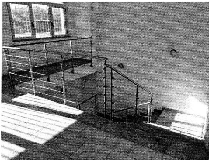
Foto n. 81 – Piano soppalco - scala
