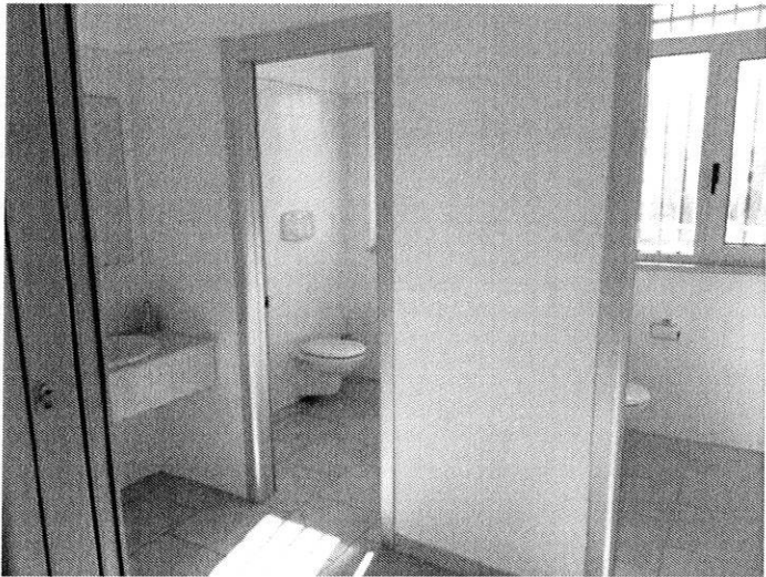
Foto n. 65 – Piano soppalco - Bagni
