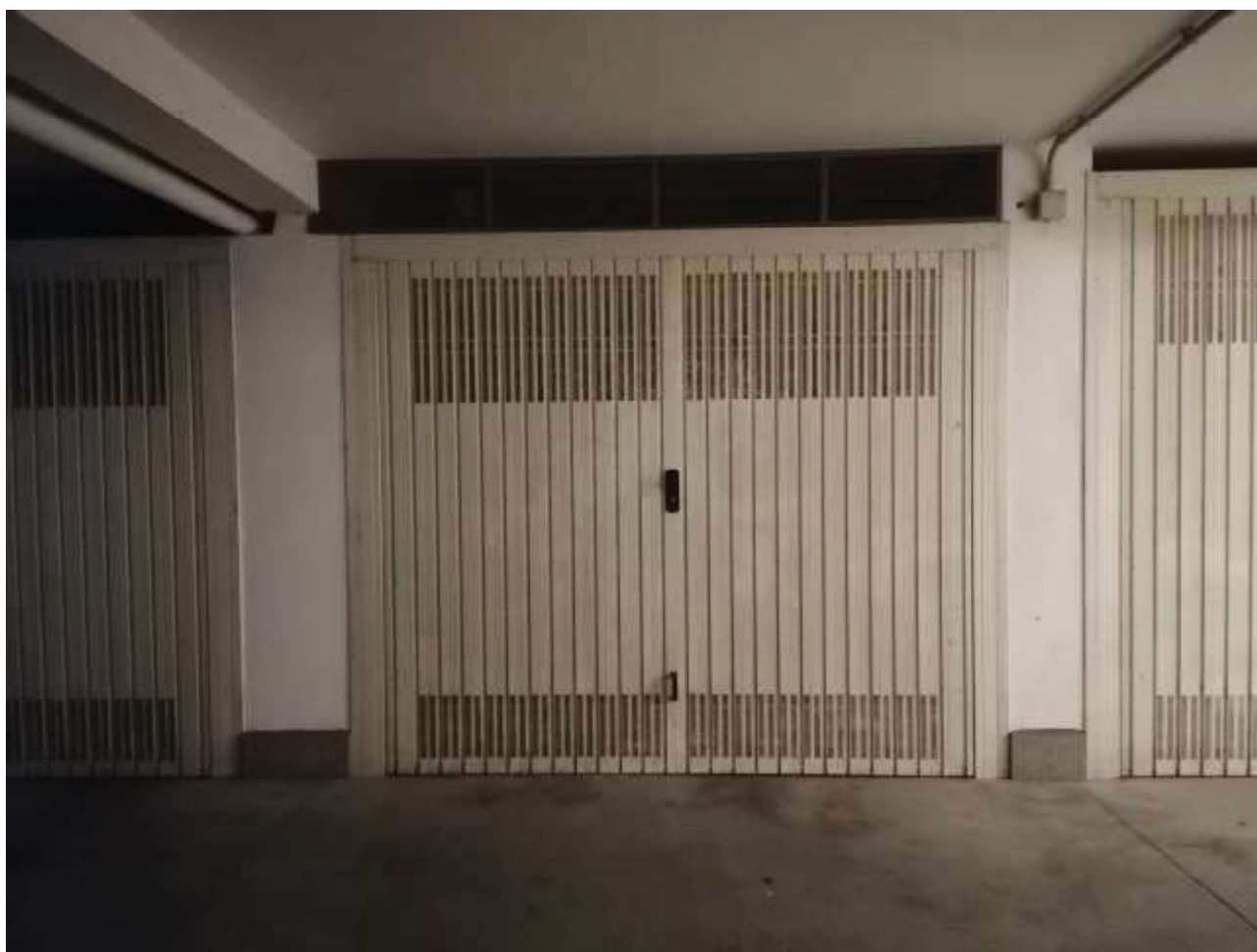
Foto n.1 Vista esterna garage
