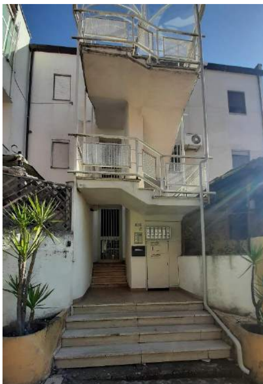
Foto 13. Vano scala comune.
