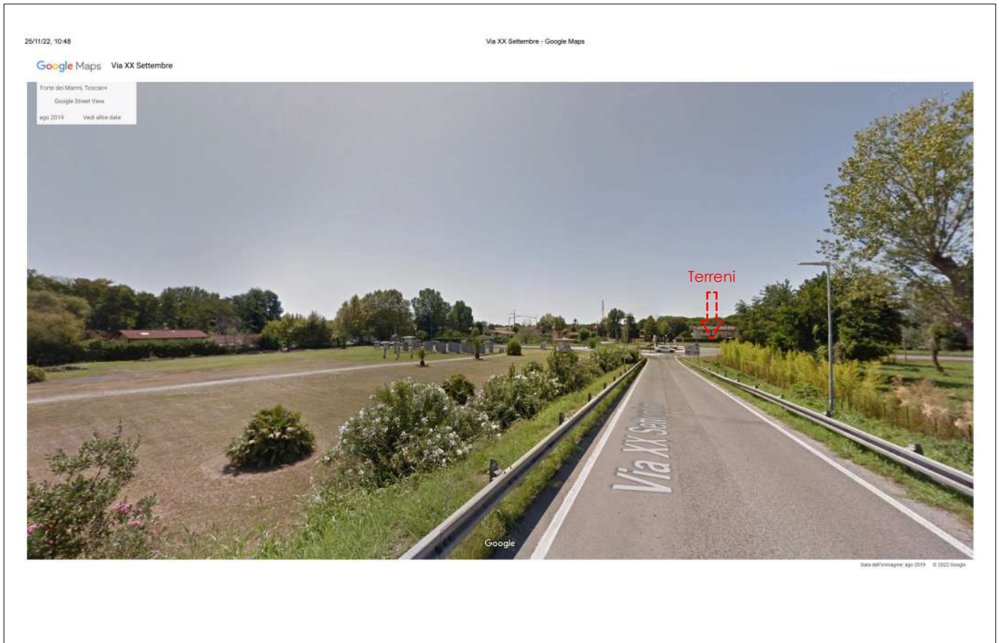
FOTO 4: Estratto Google Street View - Via XX Settembre: Vista dal cavalcavia dell'Autostrada.
