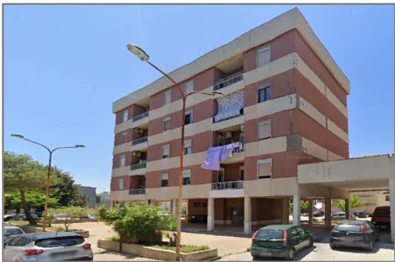
Foto prospetto principale
