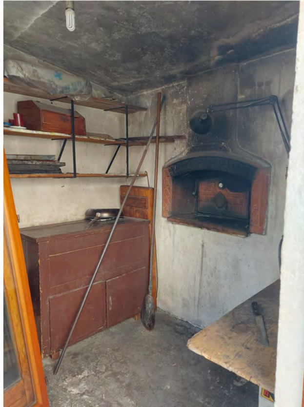
FOTO N. 11-12- Vista della cantine al PS1 nel fabbricato da cielo a terra con annessi terreni a destinazione agricola, sito in località "Capolli" del Comune di Poggio Nativo, con accesso da via Colle Comune, individuato al NCEU del detto comune al fg. 7 part. 57 sub. 1-2-3-4 il fabbricato, part. 408 il garage e part. 56 e 409 i terreni annessi.
