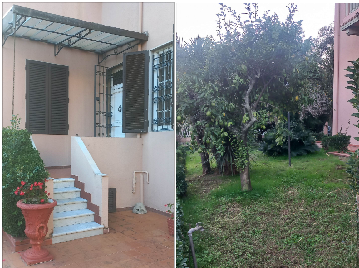
Vista esterna del piano rialzato di ingresso all'abitazione e resede esterna a comune.
