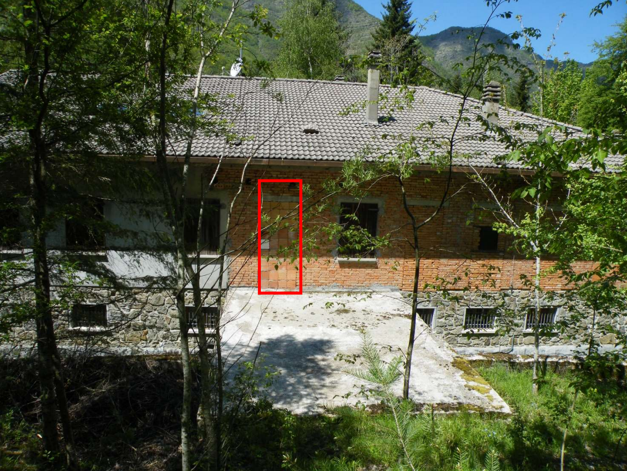
Prospetto Sud vista passerella di transito acceso murato P.2
