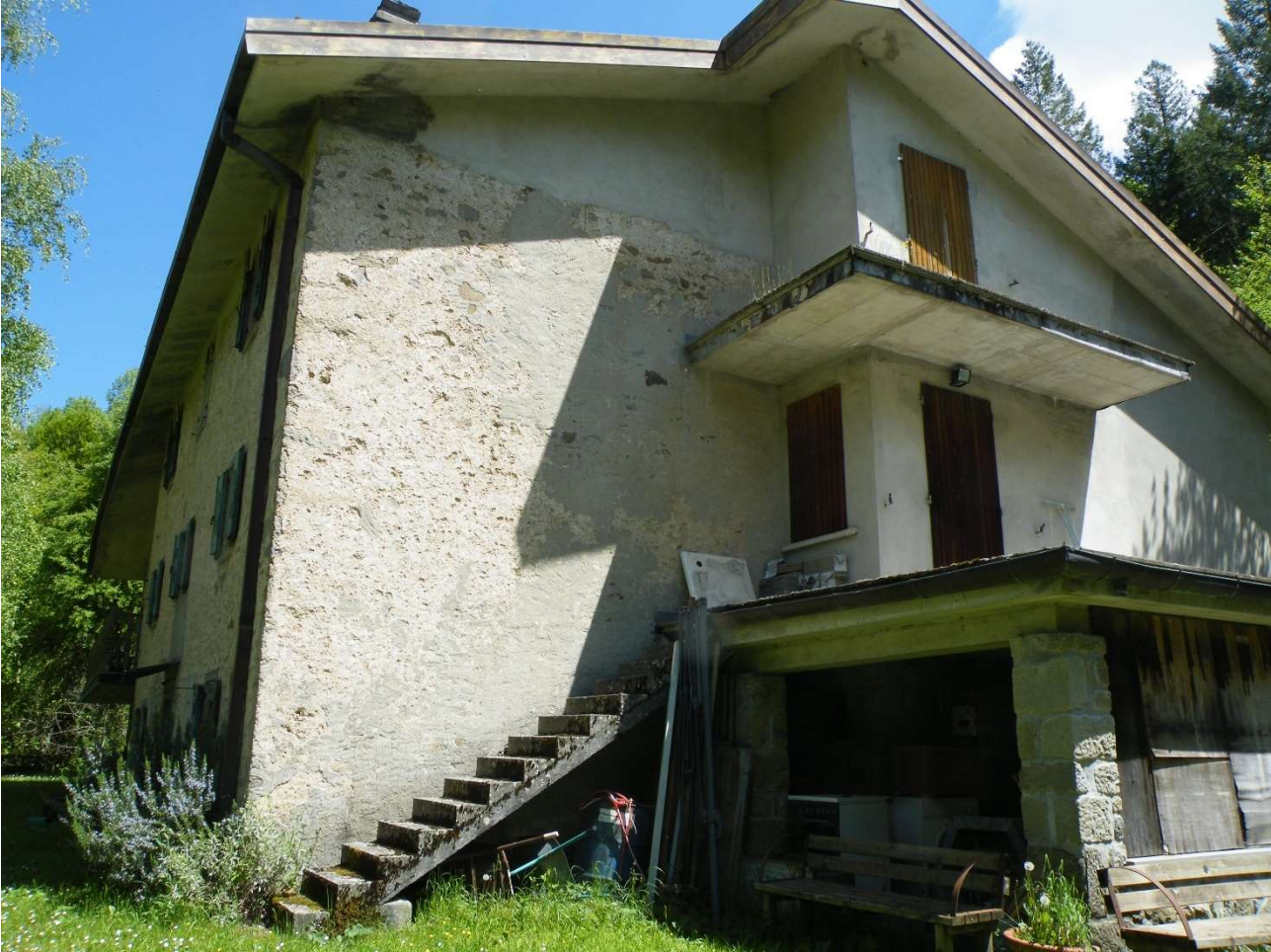
Vista Prospetto Sud-Est rampa irregolare di collegamento terrazza P.1
