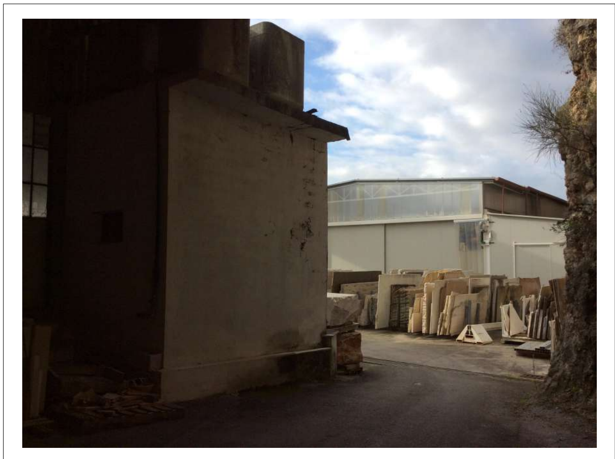
FOTO 12: Vista dalla porzione sottostante la Tettoia verso il Capannone di cui all'Esecuzione Immobiliare 92/2021 - Lotto 5.
