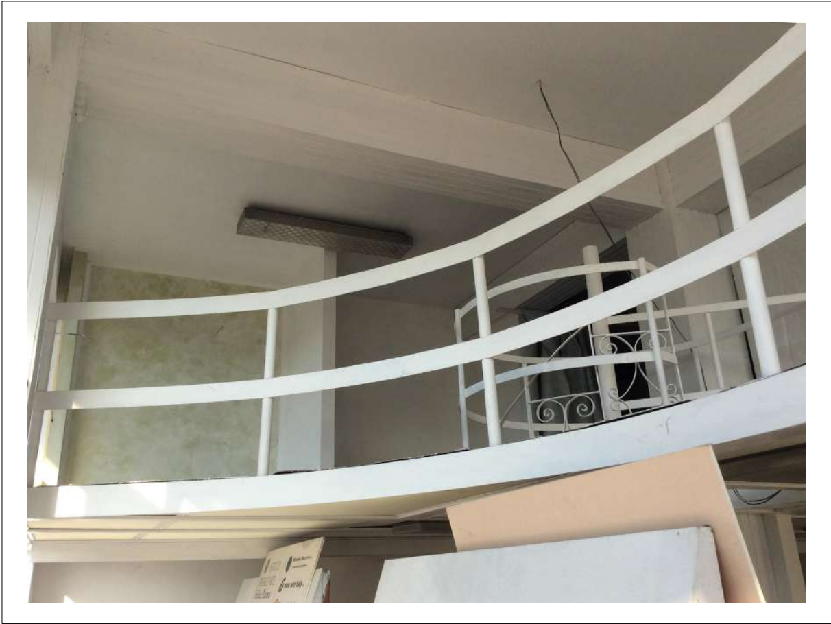
FOTO 45: Palazzina Piano TERRA - Vista verso il Soppalco.
