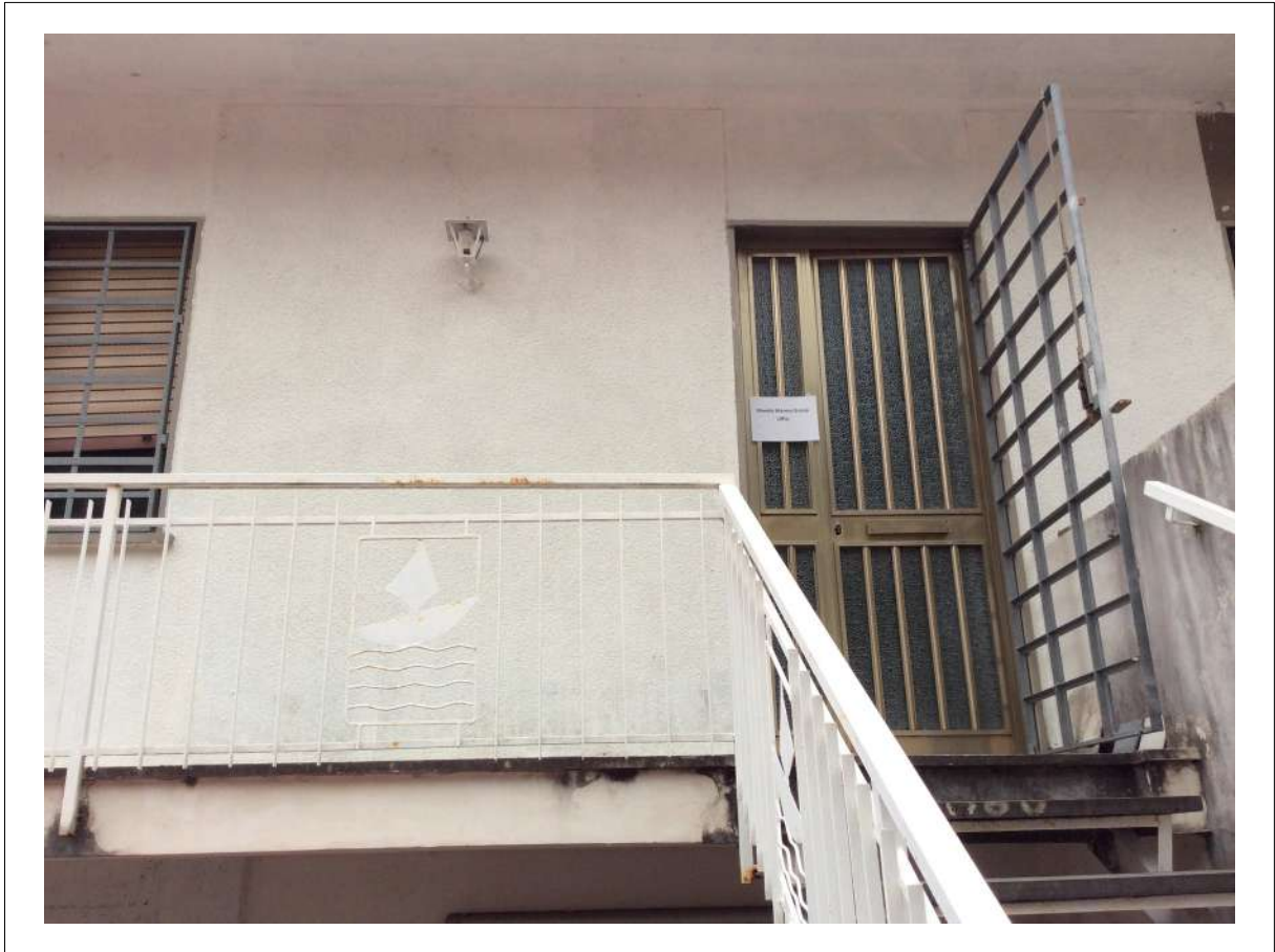
FOTO 51: Palazzina Piano PRIMO - Dettaglio scala e portoncino di accesso.
