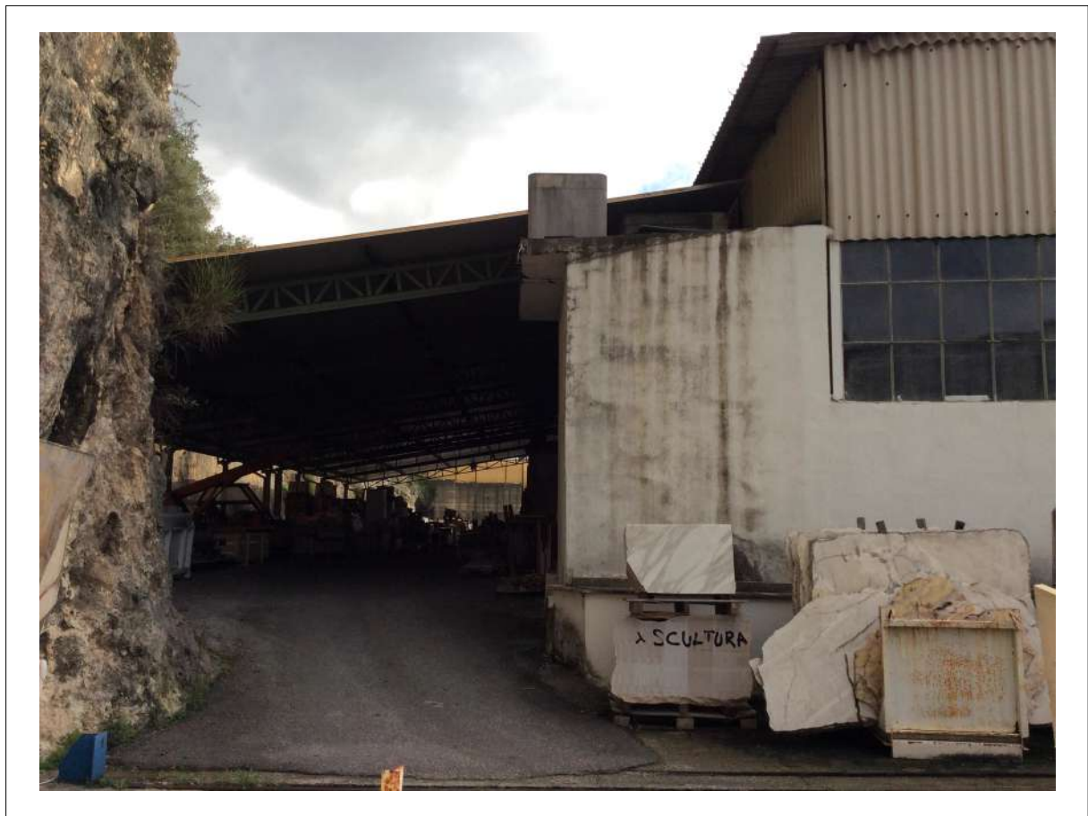
FOTO 11: Vista della porzione Nord del Complesso occupata da Tettoia con struttura metallica.
