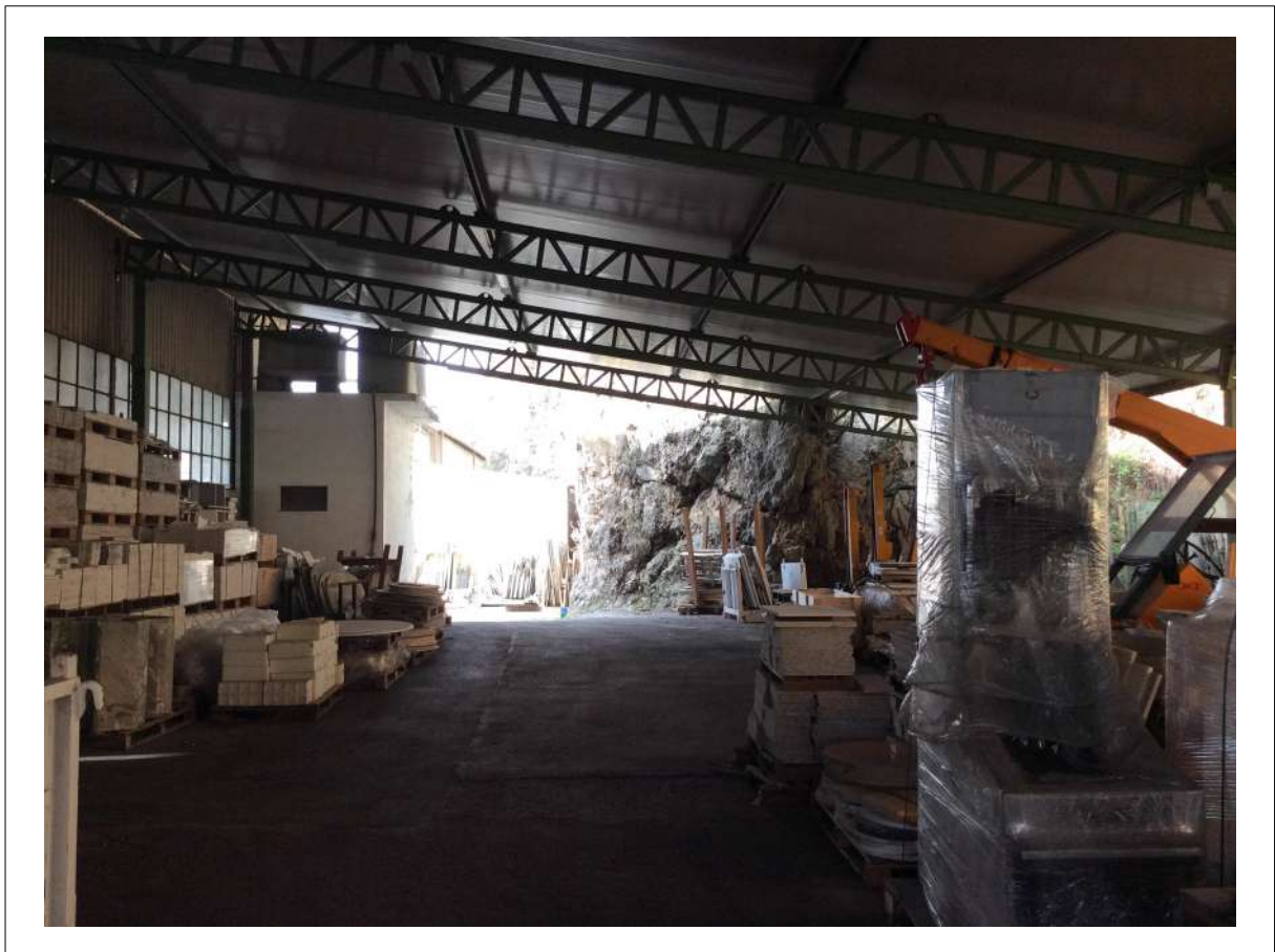
FOTO 20: Tettoia Posteriore - Vista verso Nord-Ovest.
