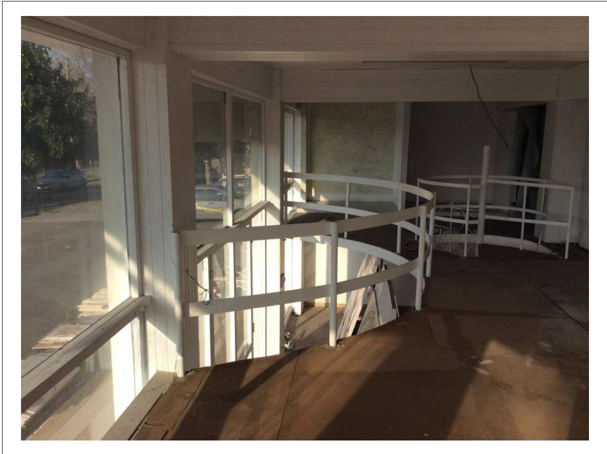
FOTO 49: Palazzina Piano SOPPALCO - Vista delle vetrine lato Via Aurelia.
