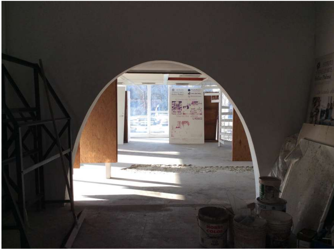
FOTO 41: Palazzina Piano TERRA - Vista dai locali del Capannone centrale.
