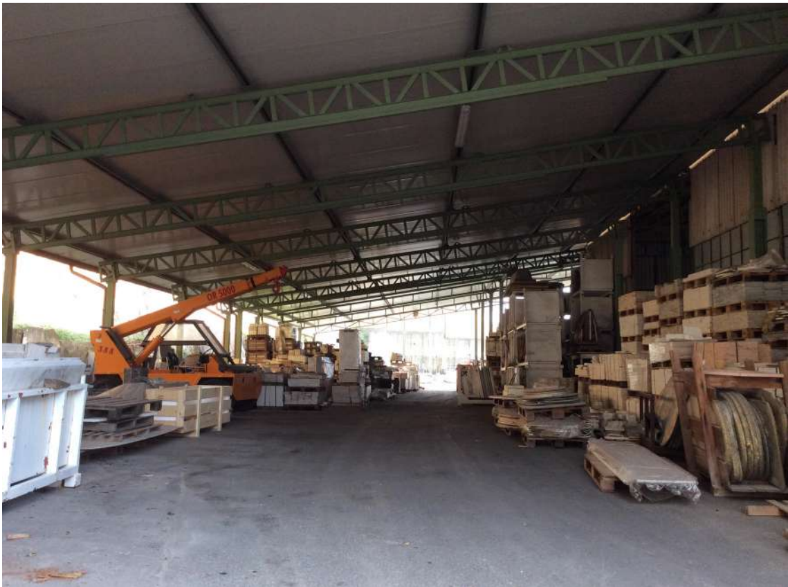
FOTO 22: Tettoia Posteriore - Vista verso Sud-Est.
