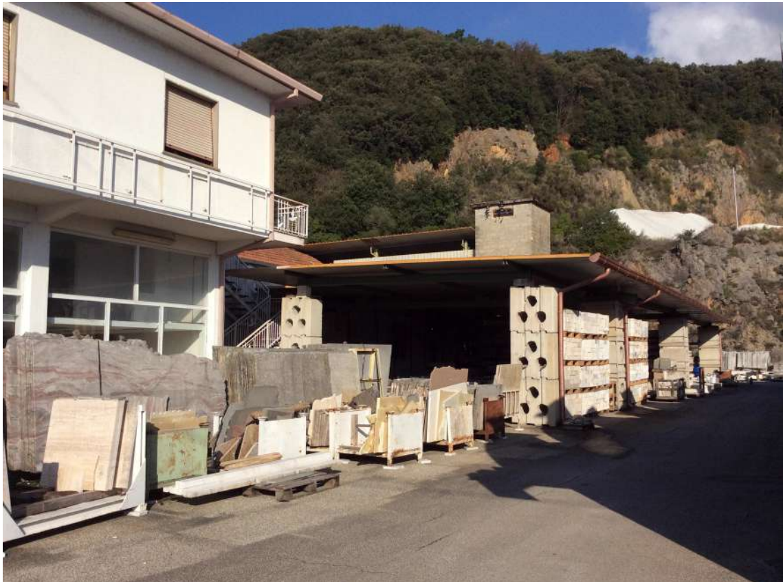
FOTO 14: Vista della della facciata Sud-Est della Palazzina e della Tettoia addossata al Capannone centrale (realizzata con elementi in calcestruzzo semplicemente appoggiati).
