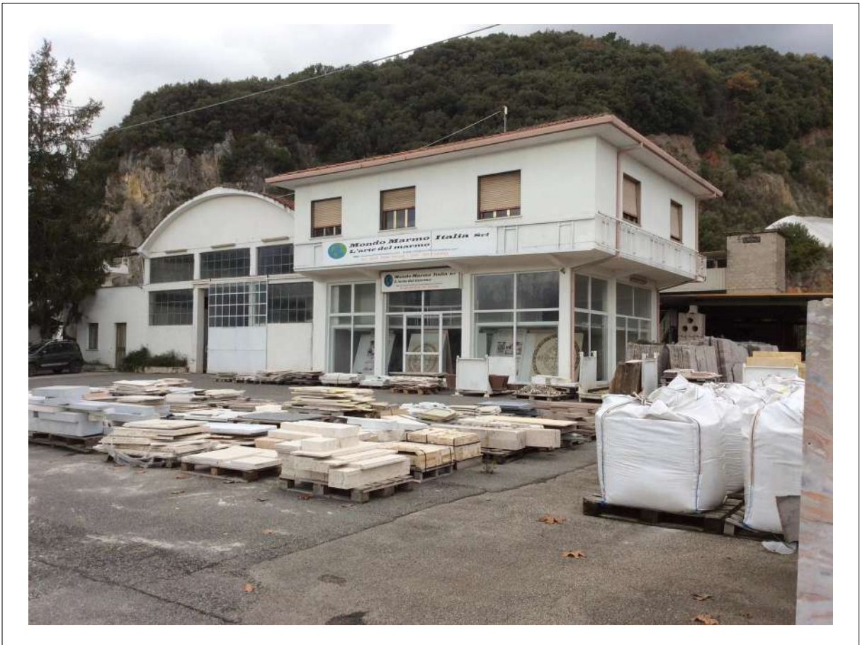
FOTO 7: Vista da Sud della Palazzina e del Capannone centrale.
