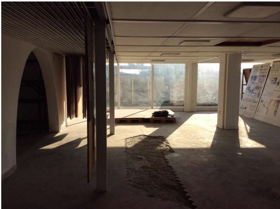
FOTO 42: Palazzina Piano TERRA - Vista verso Sud-Est.
