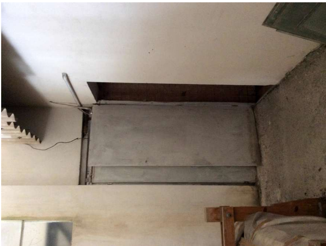
FOTO 38: Porta di accesso ai Servizi igienici.
