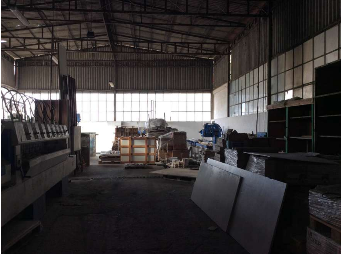
FOTO 35: Capannone posteriore - Vista verso Nord-Ovest.
