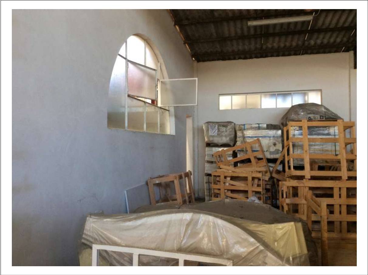
FOTO 24: Capannone centrale - Vista della porzione Sud-Est.
