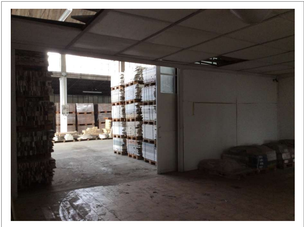
FOTO 28: Capannone centrale - Vista verso il Magazzino centrale dai locali posti in collegamento con l'Esposizione.
