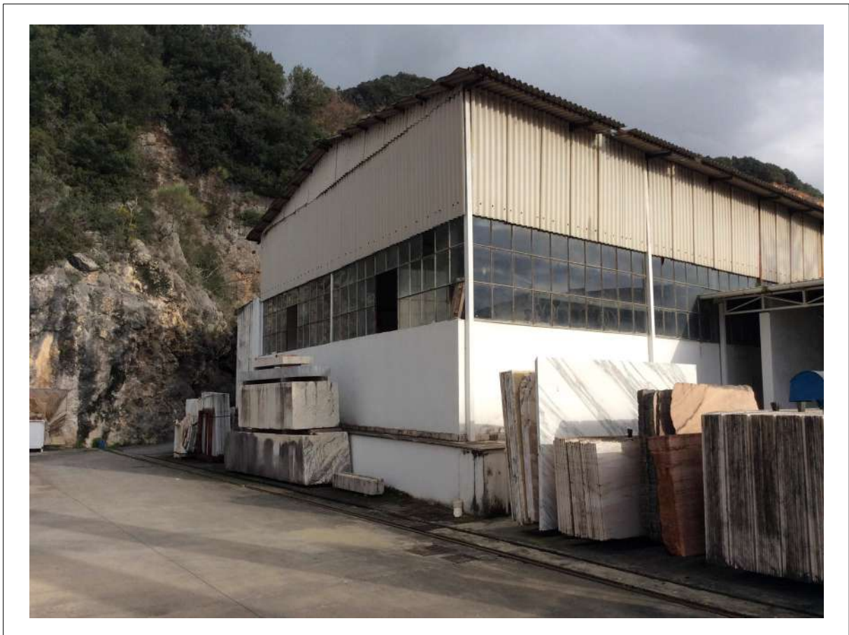
FOTO 10: Vista del Capannone posteriore.
