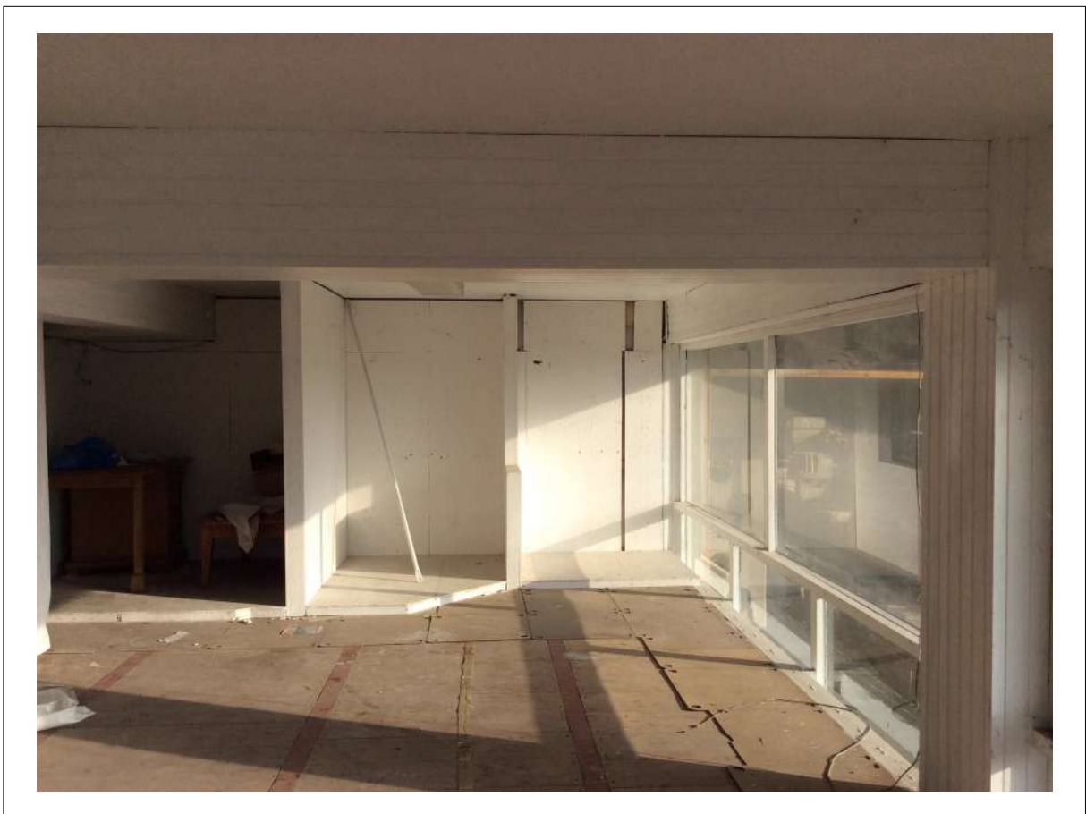
FOTO 48: Palazzina Piano SOPPALCO - Vista della porzione Sud-Est.
