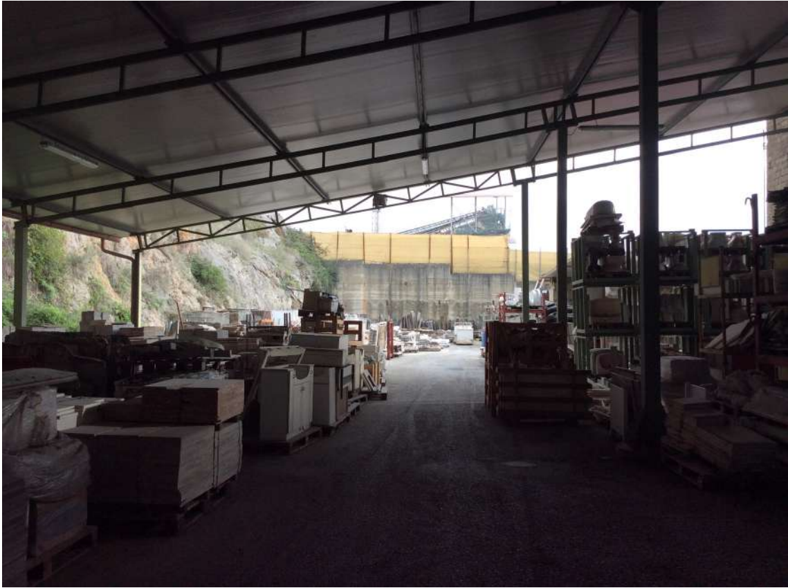
FOTO 21: Tettoia Posteriore - Vista verso Sud-Est.
