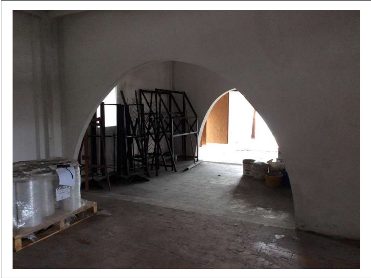
FOTO 29: Capannone centrale - Locali a corredo dell'Esposizione.
