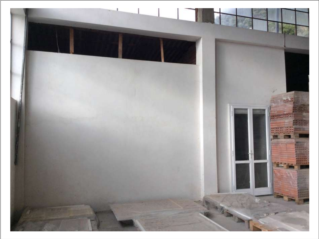
FOTO 26: Capannone centrale - Volume ricavato nella porzione lato Via Aurelia.
