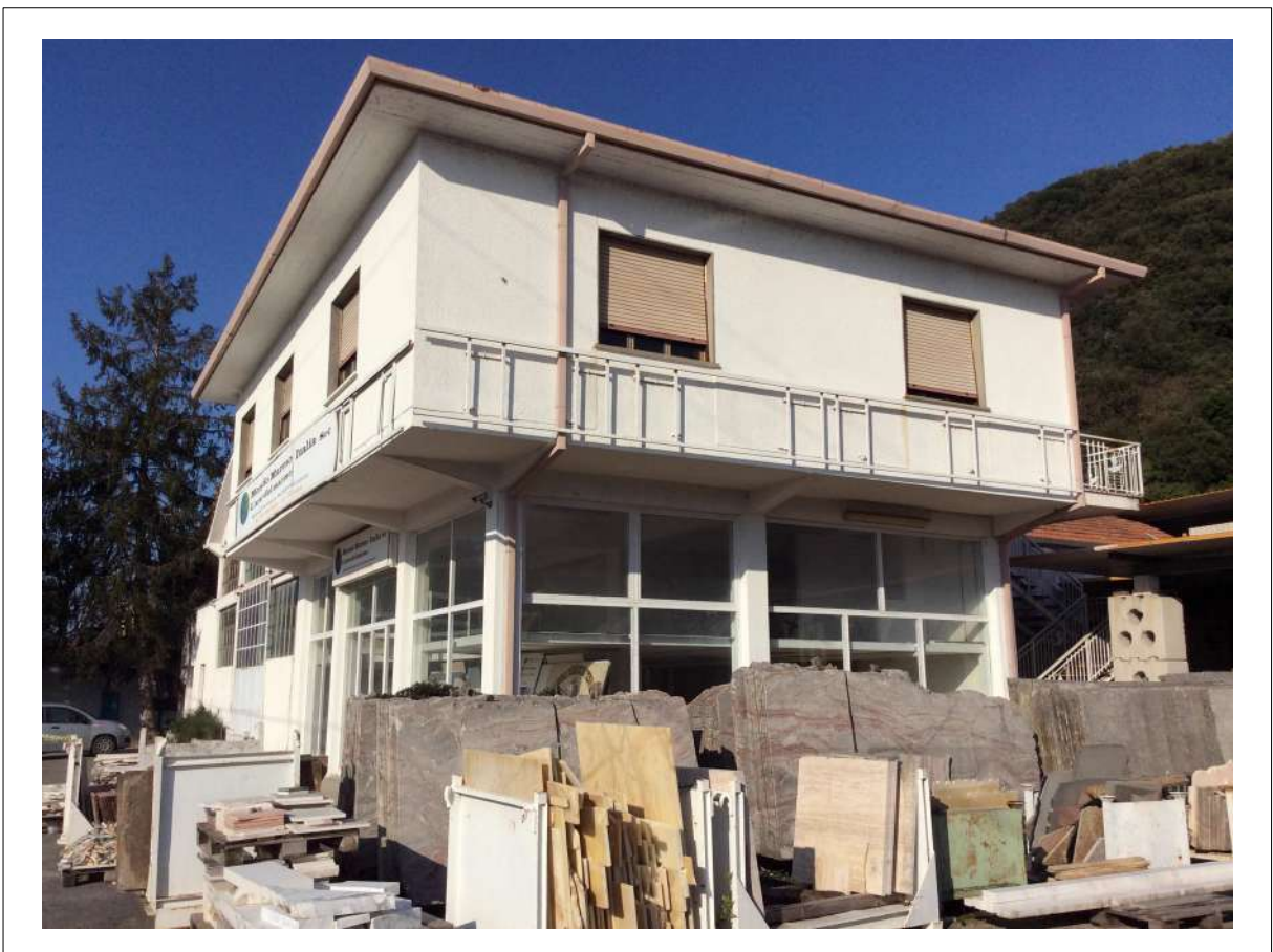
FOTO 6: Vista da Sud-Est della Palazzina destinata a Esposizione e Uffici.
