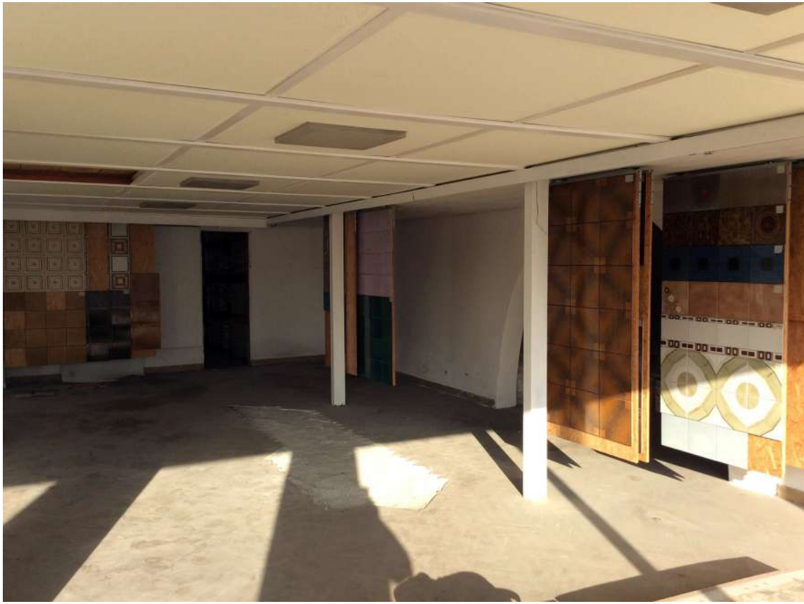
FOTO 43: Palazzina Piano TERRA - Vista verso Nord-Ovest.
