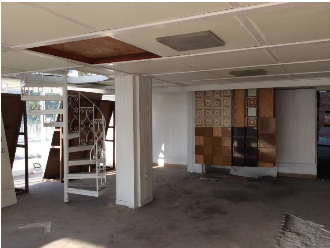
FOTO 44: Palazzina Piano TERRA - Vista verso l'Aurelia e la scala a chiocciola di accesso al Piano Soppalco.
