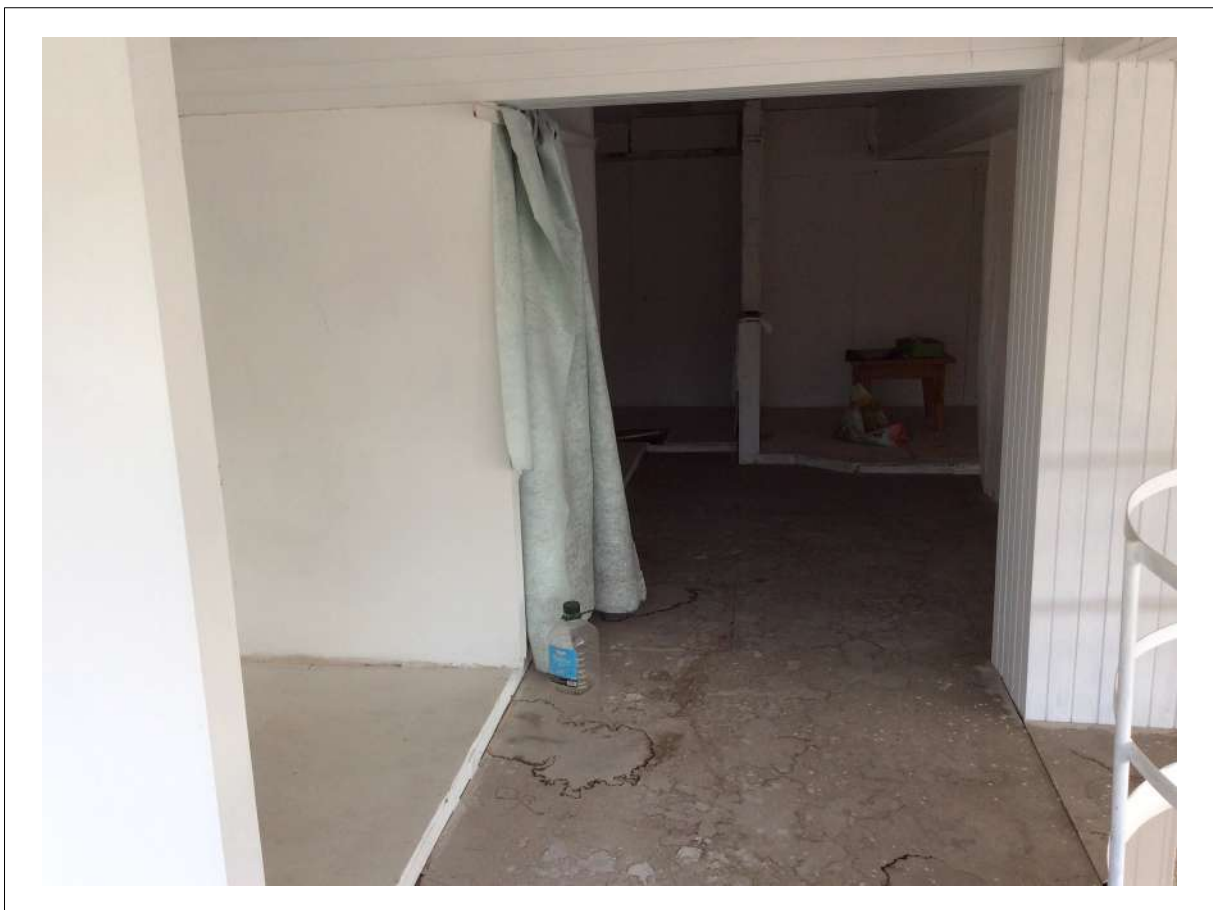
FOTO 50: Palazzina Piano SOPPALCO - Vista della porzione Nord-Ovest.
