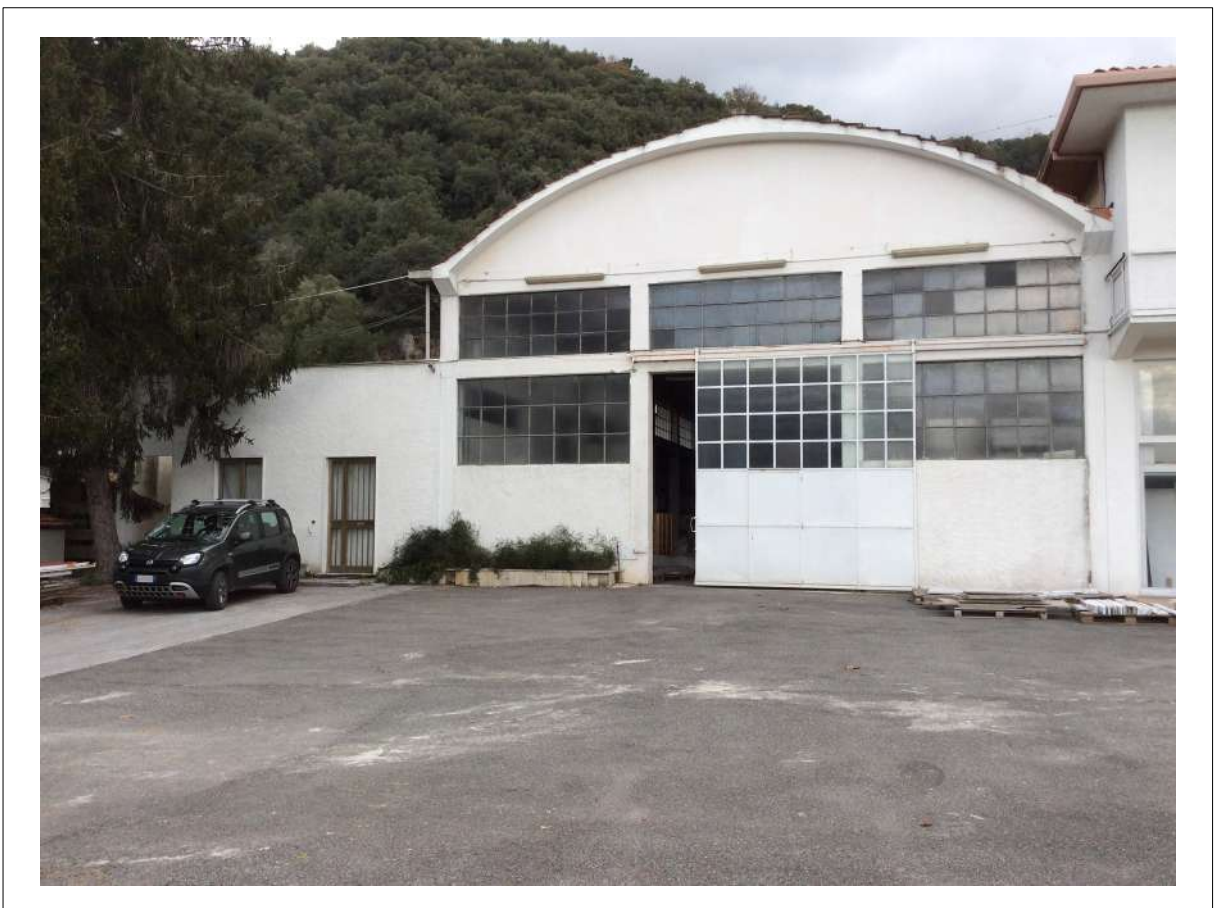
FOTO 8: Vista da Sud del fronte Sud del Capannone centrale.
